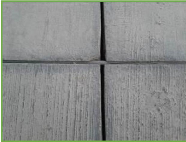
Se puede apreciar el cordón de respaldo introducido dentro de la junta de contracción.
