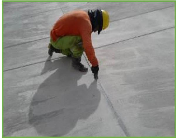
Se puede apreciar la colocación del sellador en la junta de contracción.
