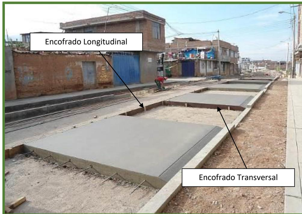
Este encofrado utiliza madera con un espesor entre 1” a ½” y el ancho de la madera, será acorde al espesor de la losa de concreto hidráulico a ser encofrada, generalmente entre 6” (15 cm) a 8” (20 cm), “así como para dar el arriostre necesario, se colocan estacas de madera a cada 75 cm aproximadamente de dimensiones 2” x 2” con una altura de 30 cm”.
