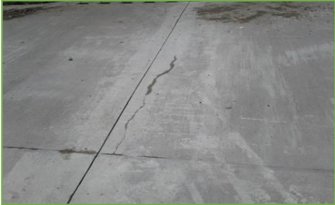
Se aprecia en la vista el corte de la junta de contracción en la Av. Mariátegui, que se realizó luego de ocurrida la contracción.
