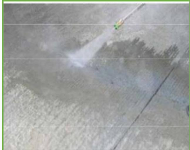
Se aprecia la limpieza que se realizó a la junta de contracción antes de la colocación del cordón de respaldo.
