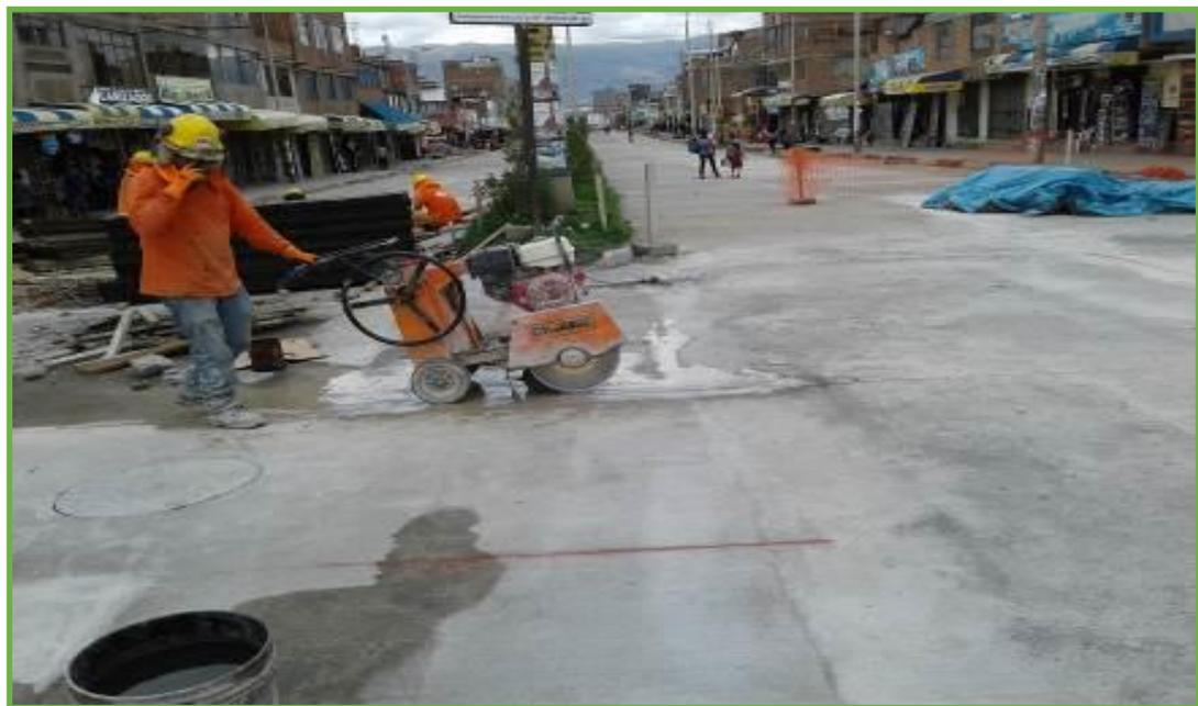
Se aprecia en la vista el corte de la junta de contracción en la Av. Mariátegui, utilizando cortadora de concreto.
