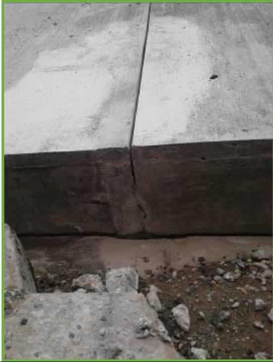
Se aprecia el corte de la junta de contracción en la Av. Mariátegui con una profundidad de 7cm (un tercio de la losa).
