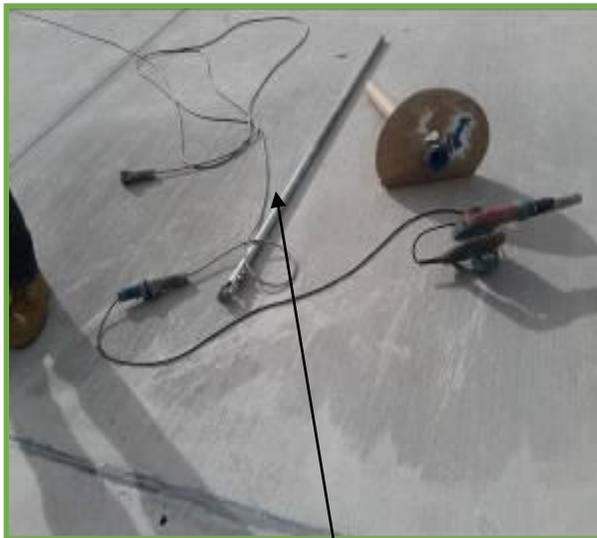
Se aprecian los instrumentos para el sellado de juntas.
