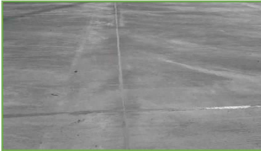
Se puede apreciar a la junta de contracción sellada, propia de la utilización del concreto premezclado.
