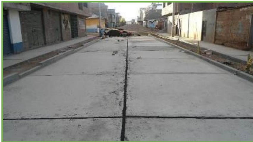
Se puede apreciar las juntas de la losa de concreto utilizando el método tradicional, en el cual el sellado se realiza por medio de una mezcla de asfalto y arena fina, el grosor es de 1".
