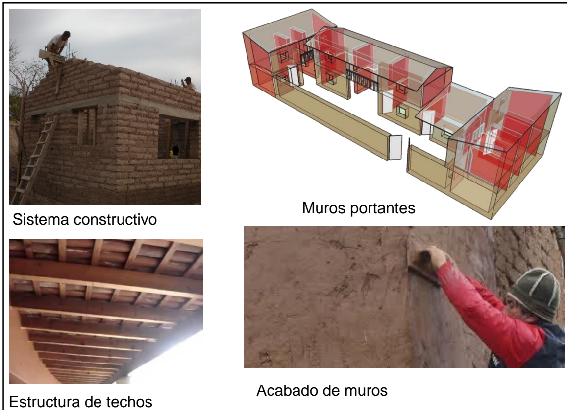
Figura 11 Patrones Estructurales-Constructivos (Segundo Cuartel)
