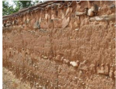
Sistema Constructivo - Tapial
