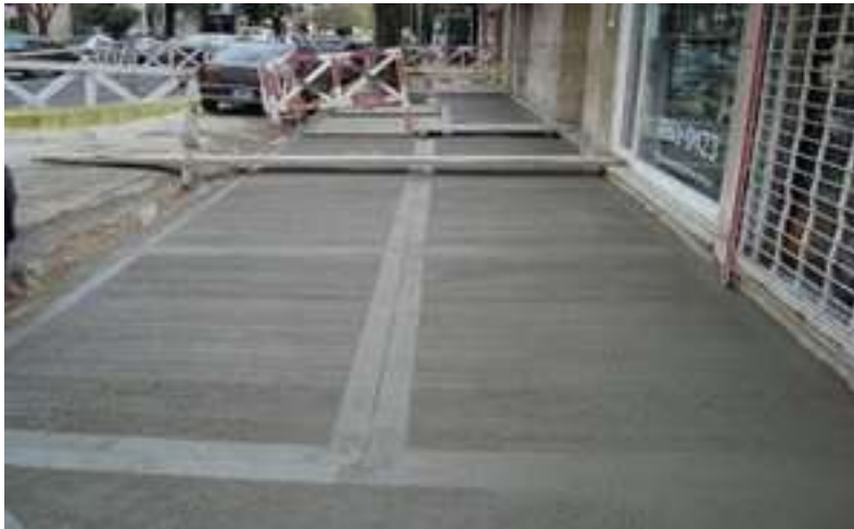
FIGURA 5: VEREDA DE HORMIGÓN PEINADO. FUENTE: VEREDAS ADOQUINADAS Y OTRAS
