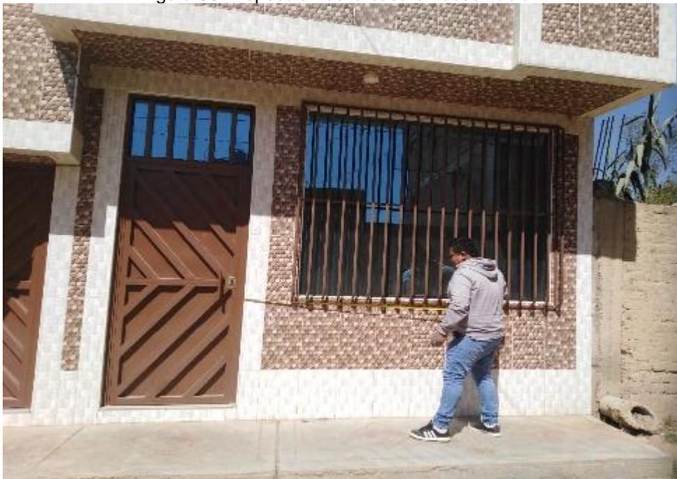
Figura 31. Toma de medidas para su respectivo replanteo y modulación en Etabs.
