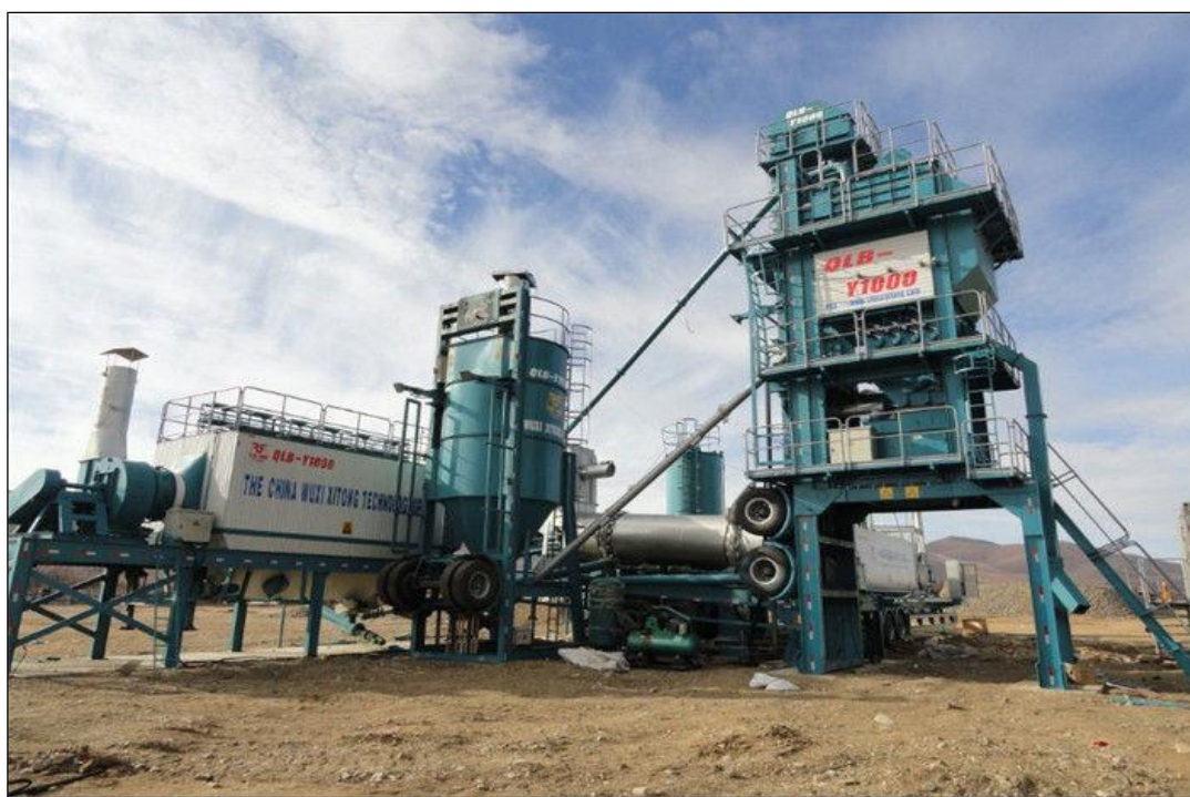
Fuente: Planta de Asfalto ASTEC – Propietario Consorcio “VARGAS” , Ubicación : Paraje La Huaycha – Concepción.
