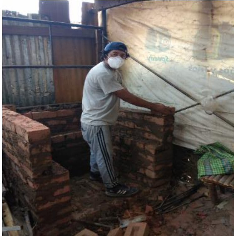
Elaboración del horno artesanal.
