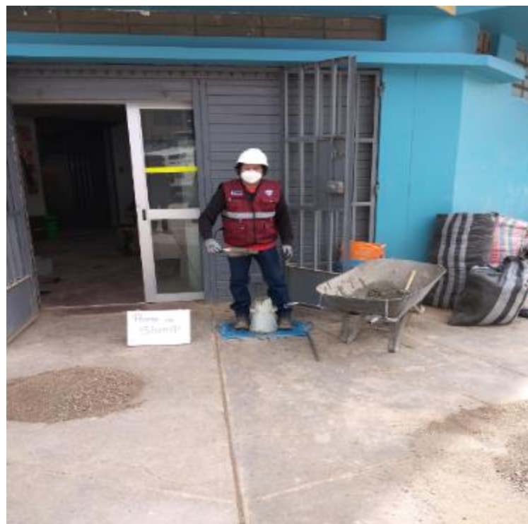
Ensayo de Slump.
