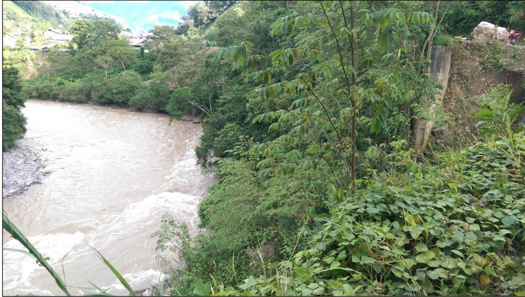
Figura 64: Vista Río Huancabamba al Pie de Talud
