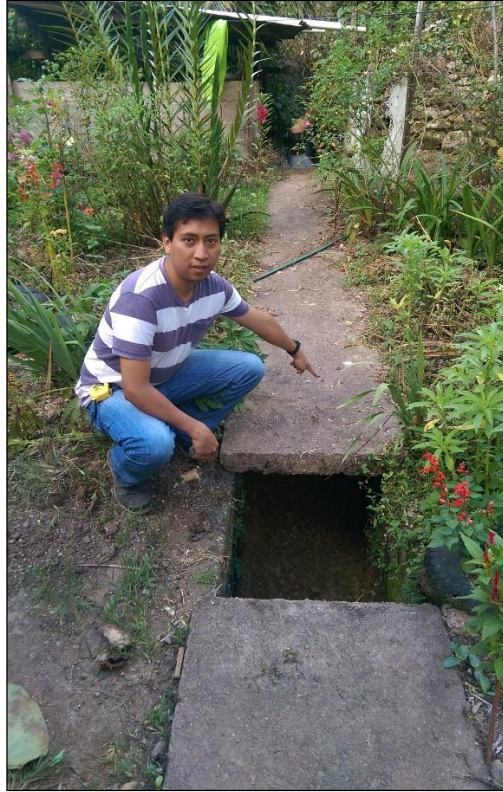
Figura 61: Existencia de Canal de Concreto Armado (Fuente: Propia, 2017)
