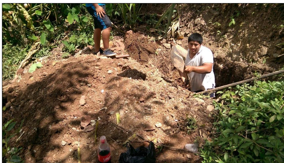
Figura 56: Excavación de calicata N° 1
