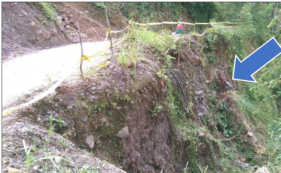
Figura 66: Macheteo de las zonas con cobertura vegetal (Fuente: Propia, 2017)
