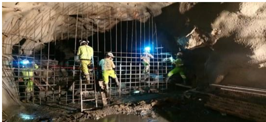
Imagen 21: Armado de aceros de refuerzo
