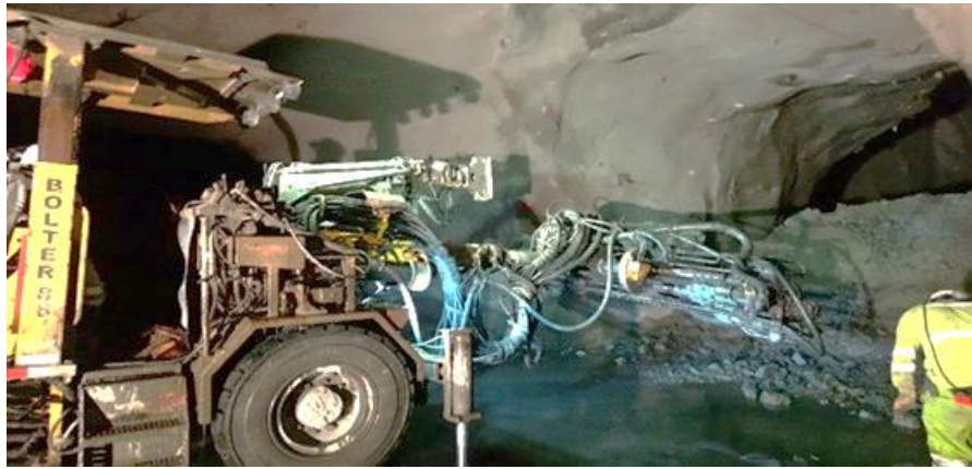
Imagen 18: Perforación con Maquinaria Bolte
