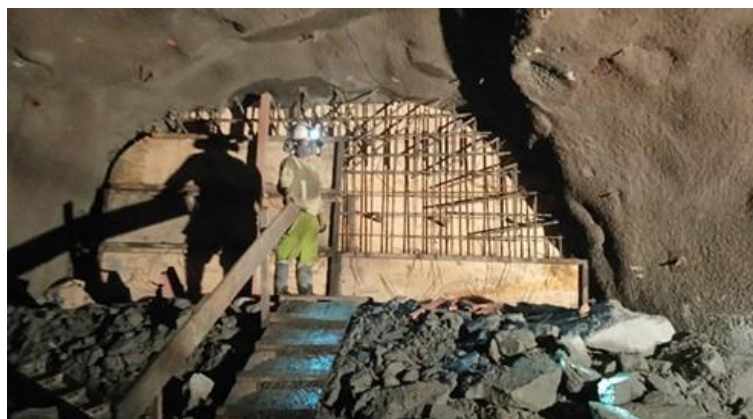
Imagen 25: Armado de refuerzo del 2do nivel
