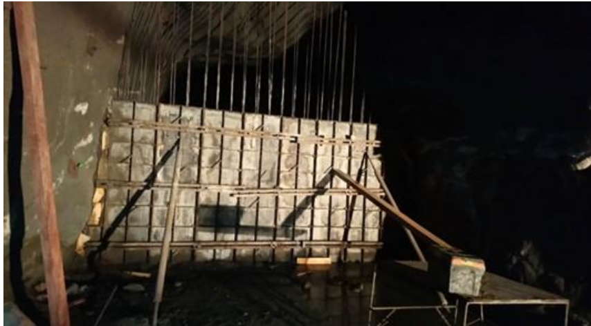
Imagen 22: Armado de aceros de refuerzo
