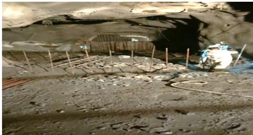
Imagen 19: Perforación con Equipo Jack Hanner
