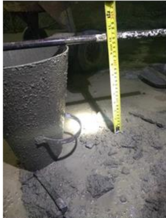
SLUMP FINAL 10" CON ADITIVO
