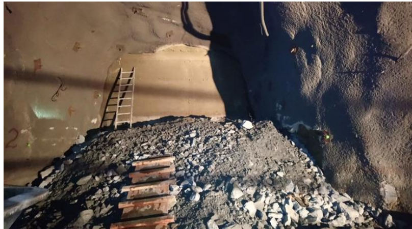
Imagen 28: Desencofrado externo del 2do nivel
