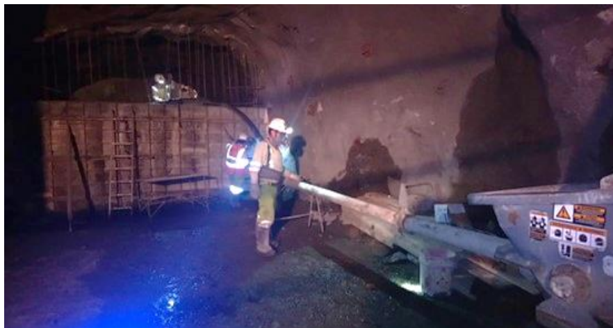
Imagen 23: Colocación del concreto del 1er nivel
