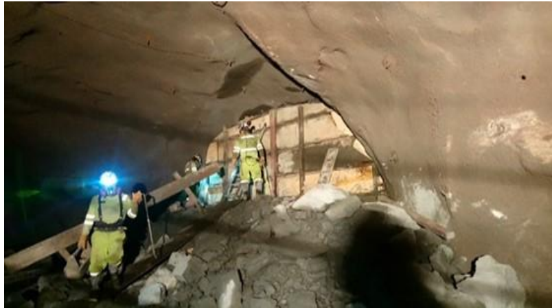
Imagen 26: Encofrado externo del 2do nivel
