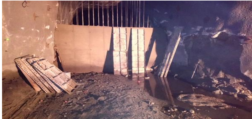
Imagen 24: Desencofrado del 1er nivel
