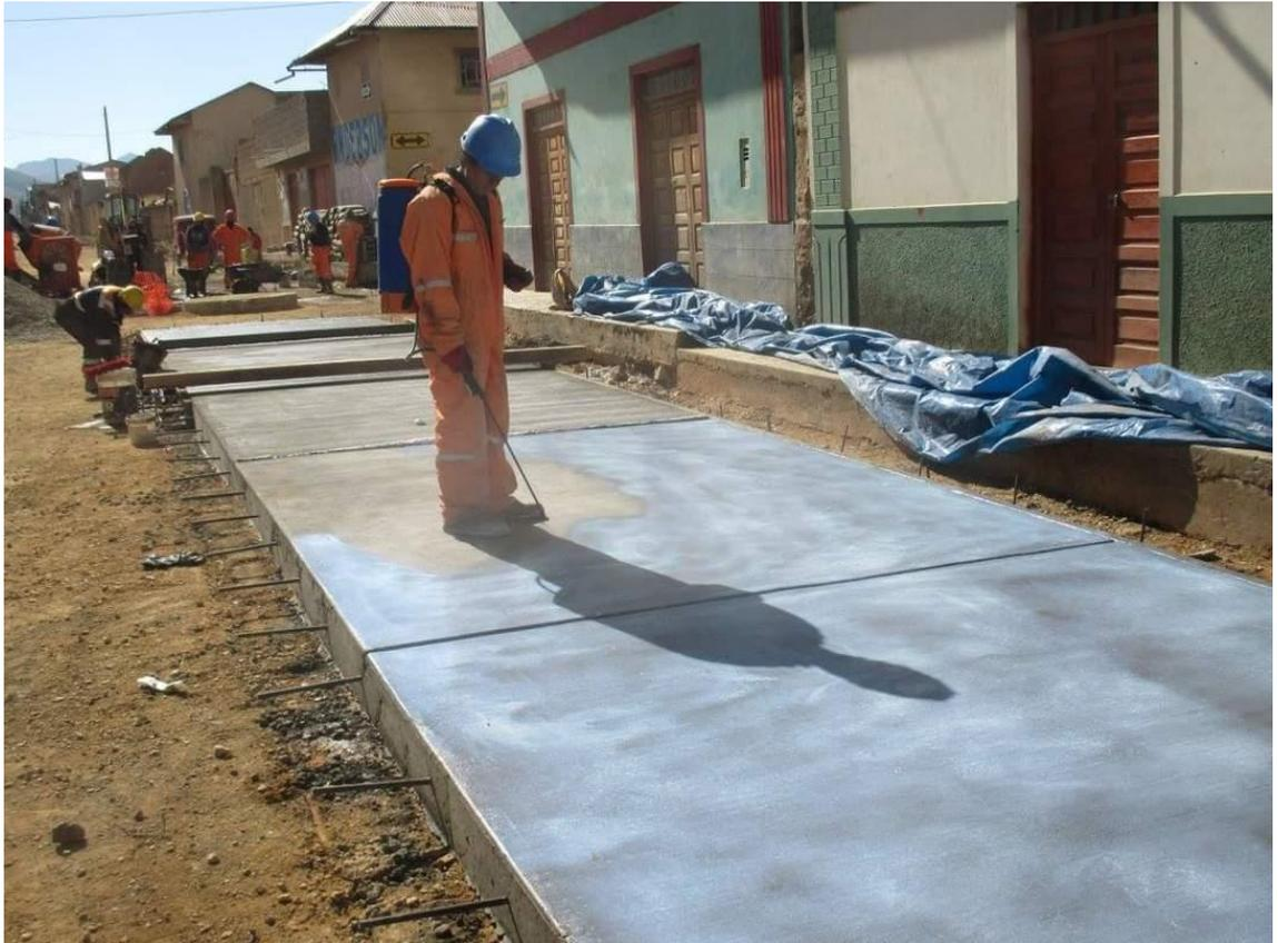
Fotografía 5. Se muestra el curado de concreto con aditivo.
