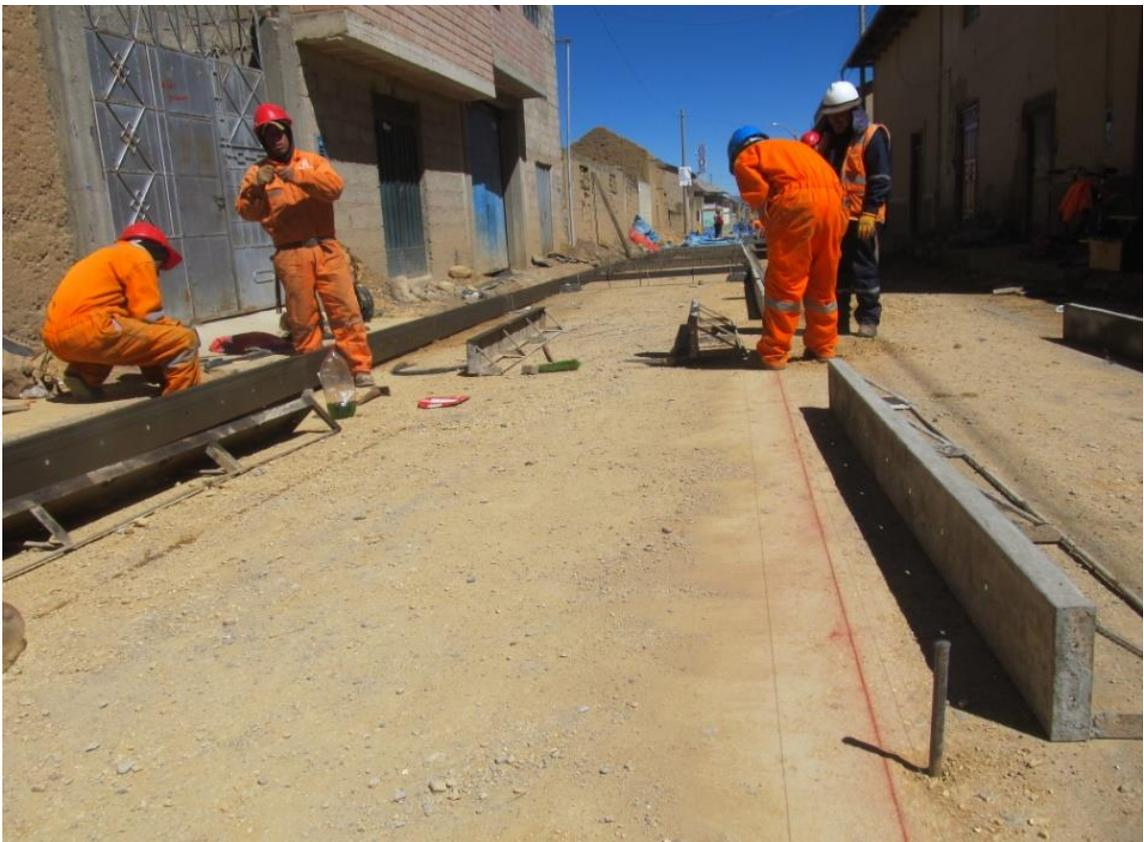
Fotografía 2. Colocación de dowells para el pavimento rígido.
