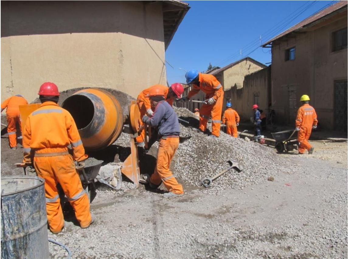
Fotografía 3. Preparación de la mezcla de concreto.
