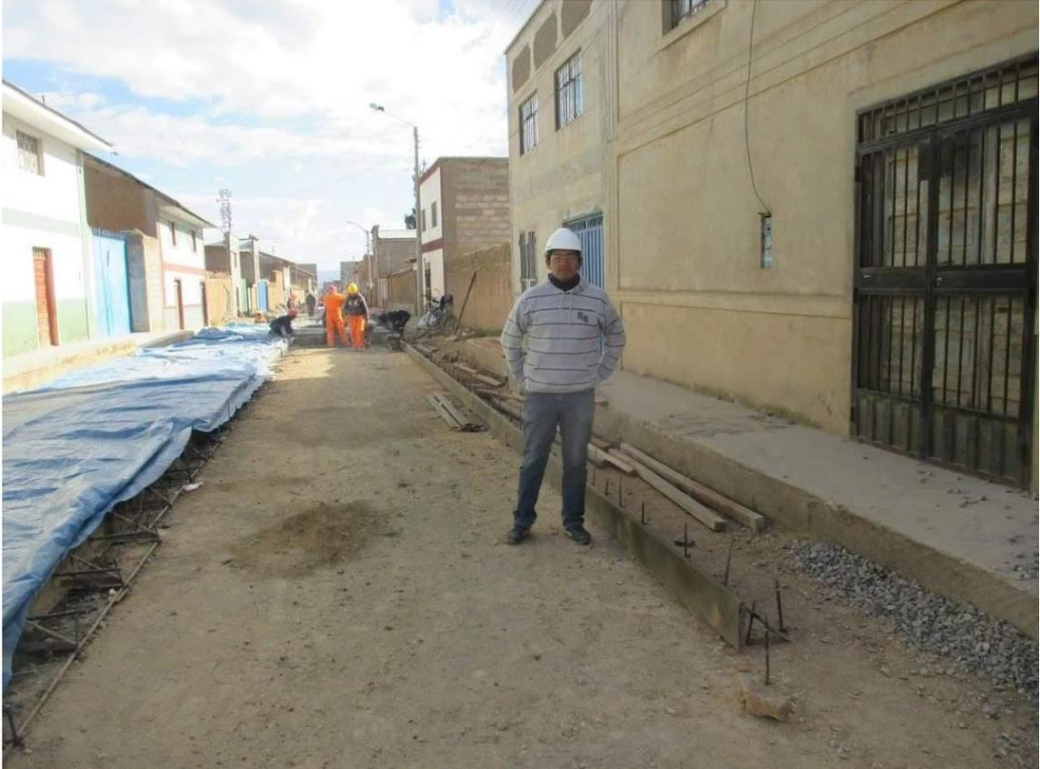
Fotografía 1. Encofrado para el pavimento rígido.
