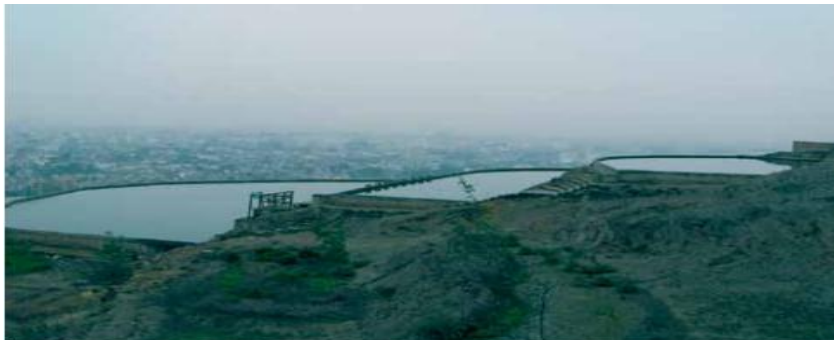
Figura N°16: Sistema de lagunas empleado en el tratamiento de aguas residuales del Colegio La Inmaculada (Lima)
