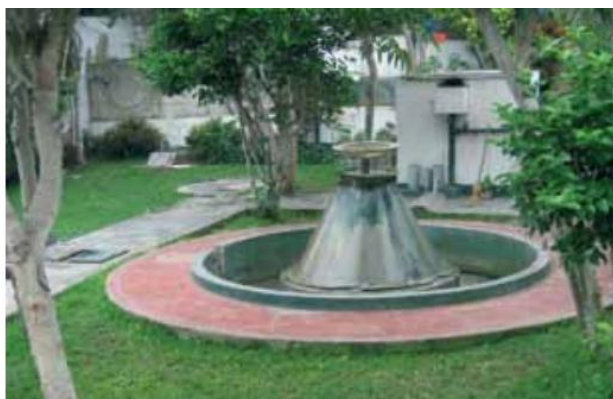
Figura N°21: Filtro percolador modificado ubicado en el parque María Reiche del distrito de Miraflores, Lima.
