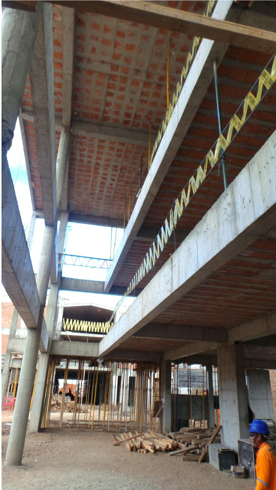
F6. Vista de Columnas circulares.
