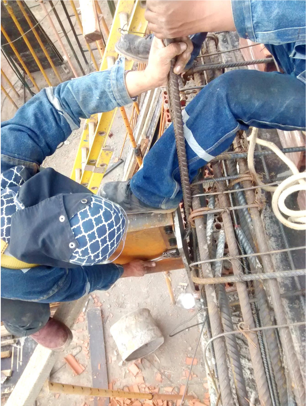
F13. Instalación viga de acero con espárragos embebidos en concreto.
