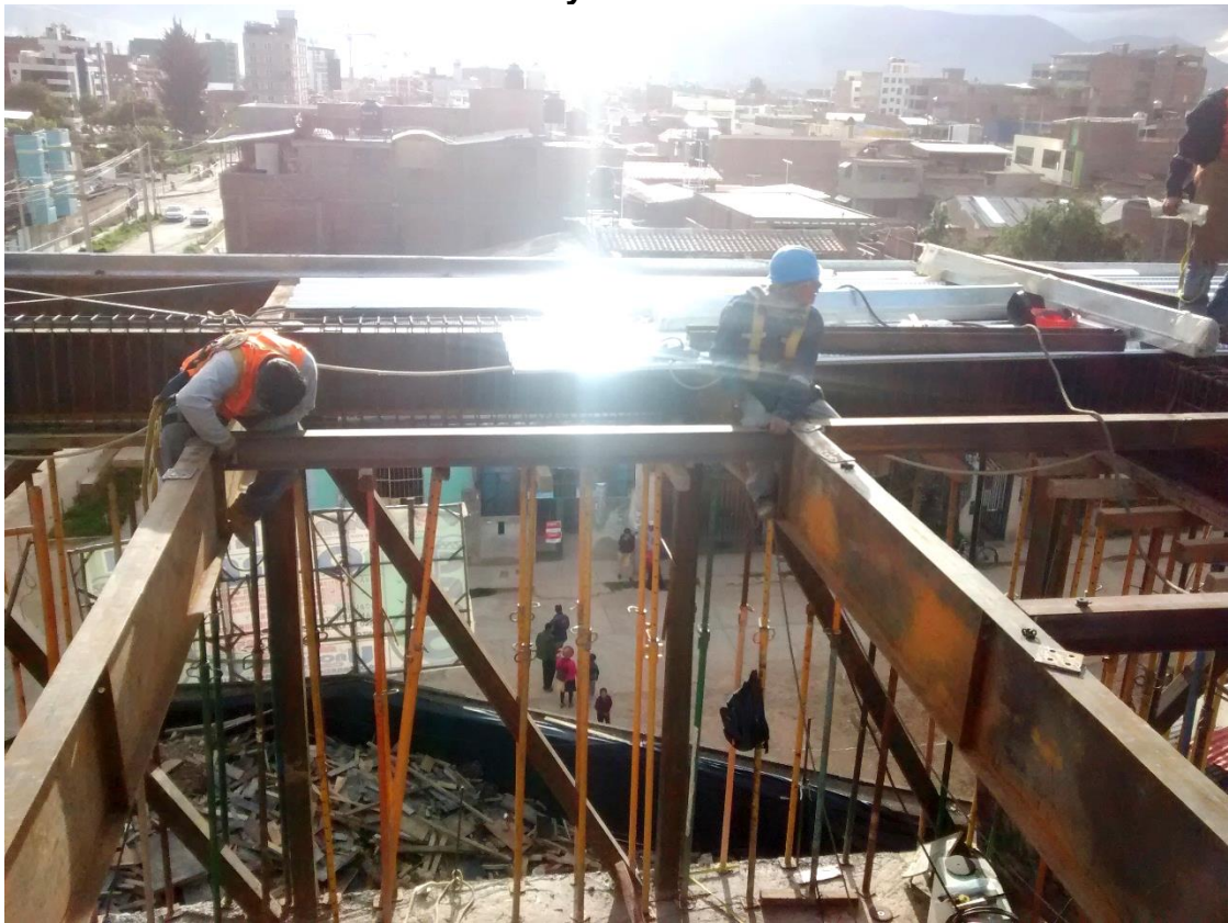
F12. Instalación de vigas secundaria.
