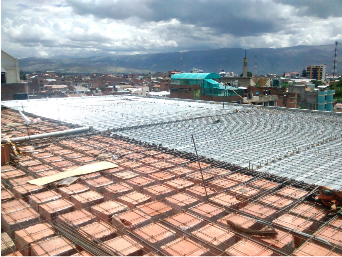
F8. Losa de tercer nivel volado
