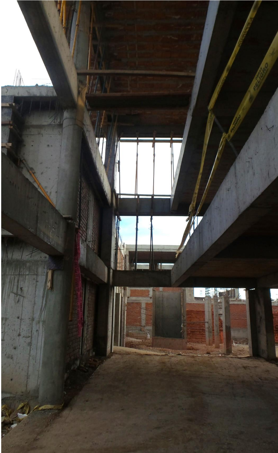
F5. Columnas circulares
