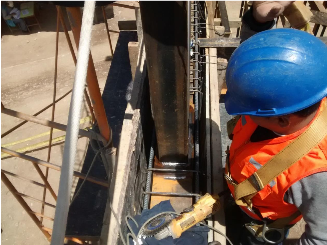
F13. Pabellón A, con pies derechos y sin desencofrar.
