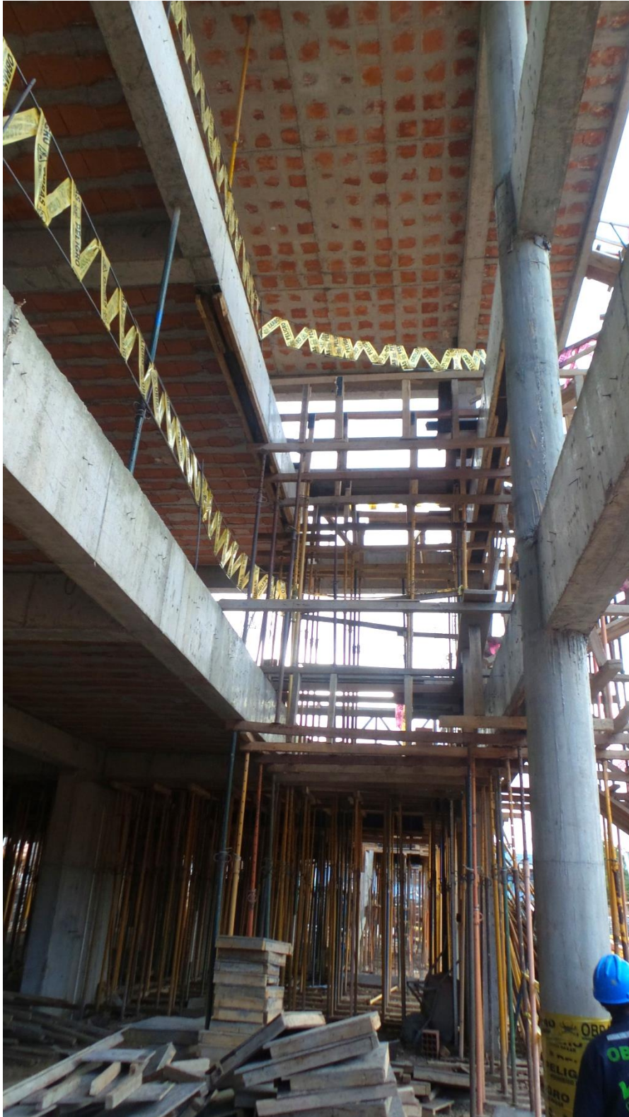
F7. Columnas circulares
