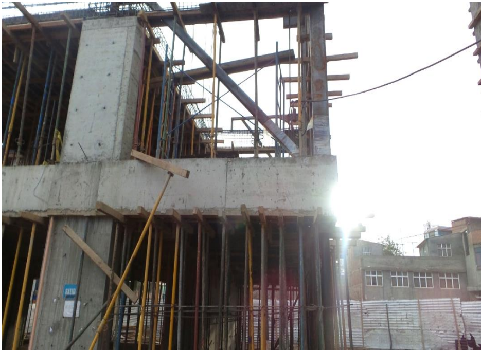
F1. Volado de 6m de la estructura.
