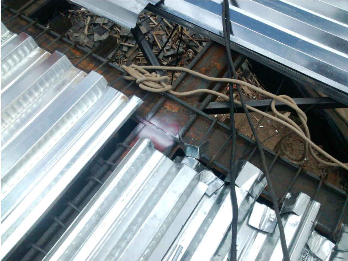
F11. Ensayo de soldadura
