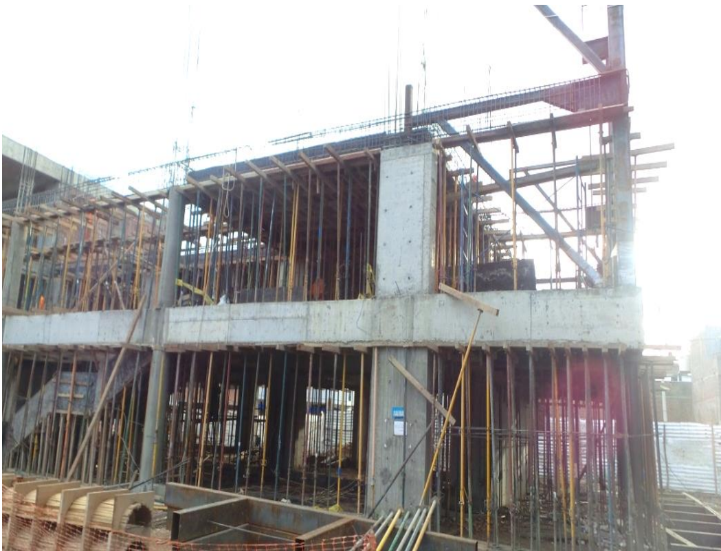
F3. Volado en edificación
