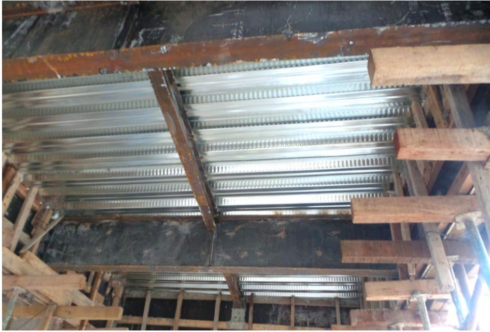
F2. Losa colaborante en edificación
