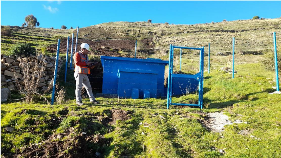
Se muestra el reservorio de Volumen =  $8 \text{ m}^3$  (2.20x2.05x1.80) y el cerco perimétrico
