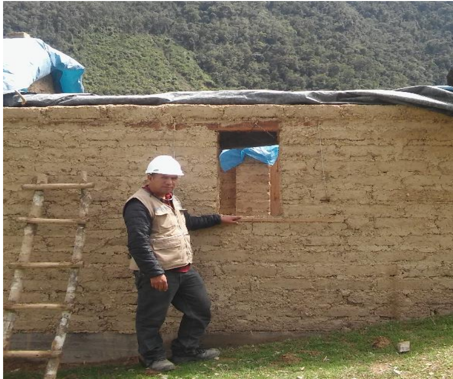
Figura 24: Colocación de dinteles y viga collar de madera copaiba. Fuente: Elaboración propia.
