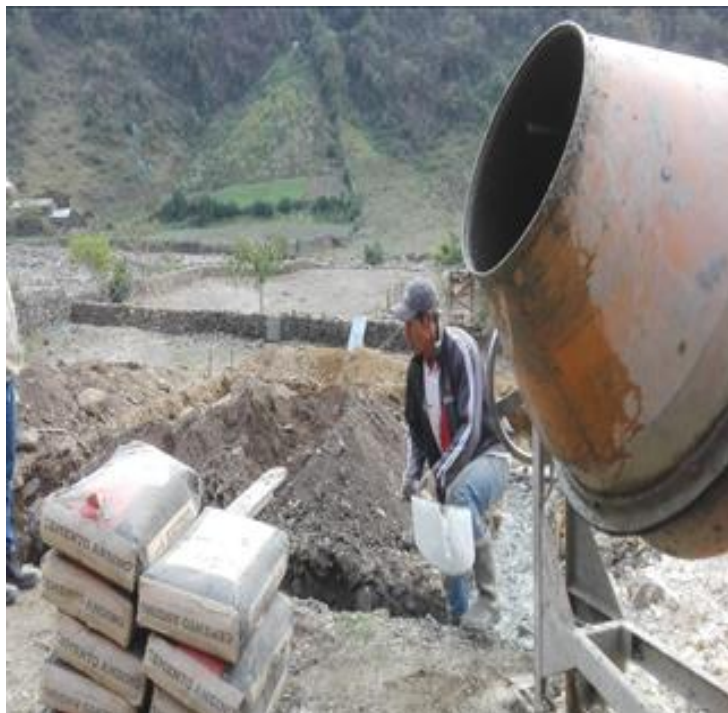
Figura 33: Dosificación del concreto. Fuente: Elaboración propia.
