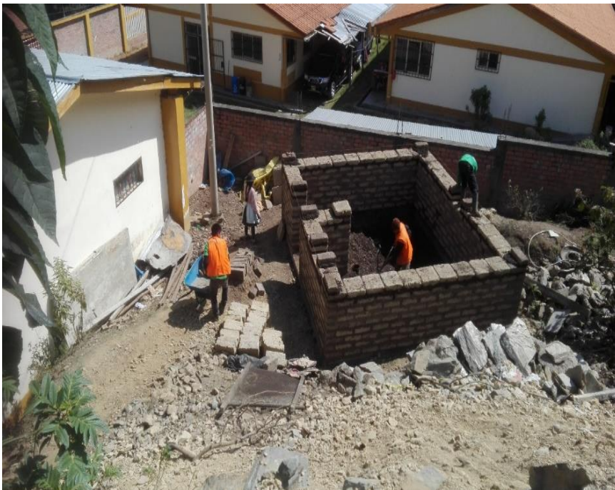
Figura 5: Asentado de muros de adobe. Fuente: Elaboración propia.
