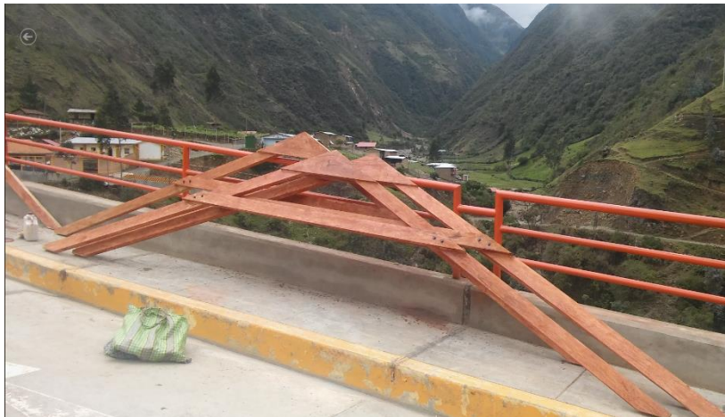
Figura 2: Elaboración de tijerales con las especificaciones técnicas. Fuente: Elaboración propia.
