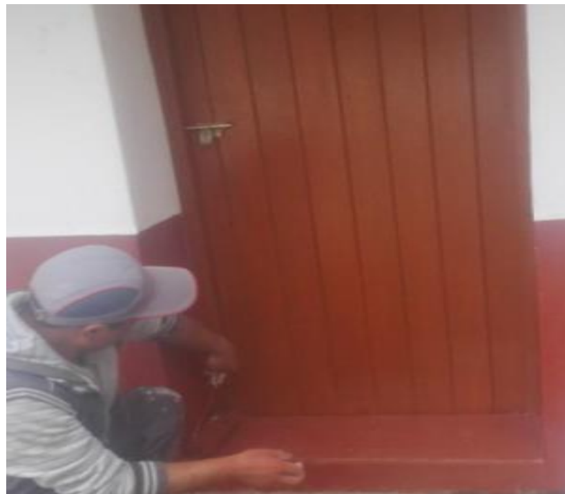
Figura 27: Puerta con acabado de esmalte sintético. Fuente: Elaboración propia
