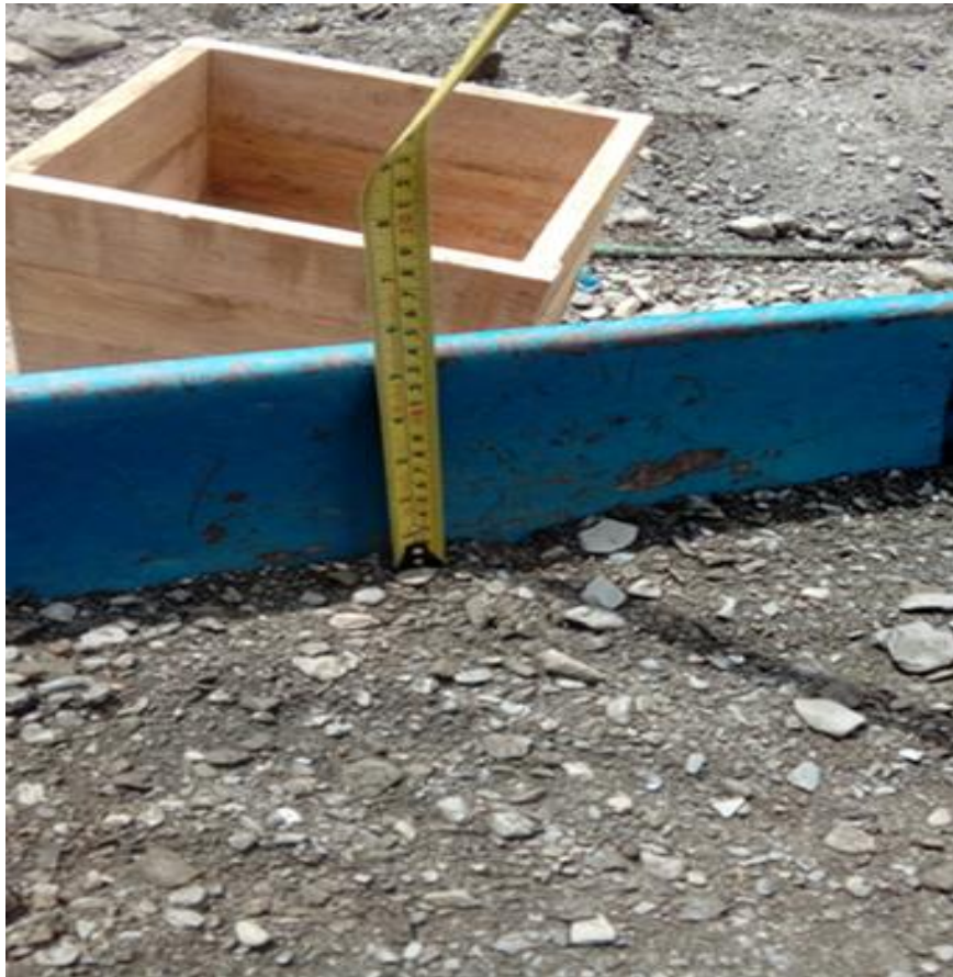
Figura 31: Medición de la gavera de madera. Fuente: Elaboración propia.
