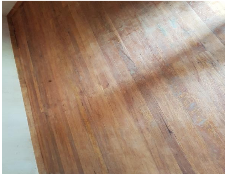
Figura 22: Piso machihembrado de madera tipo tornillo de 4"x1" de 3.0 metros y de 1.20 metros de acabado lijado. Fuente: Elaboración propia.
