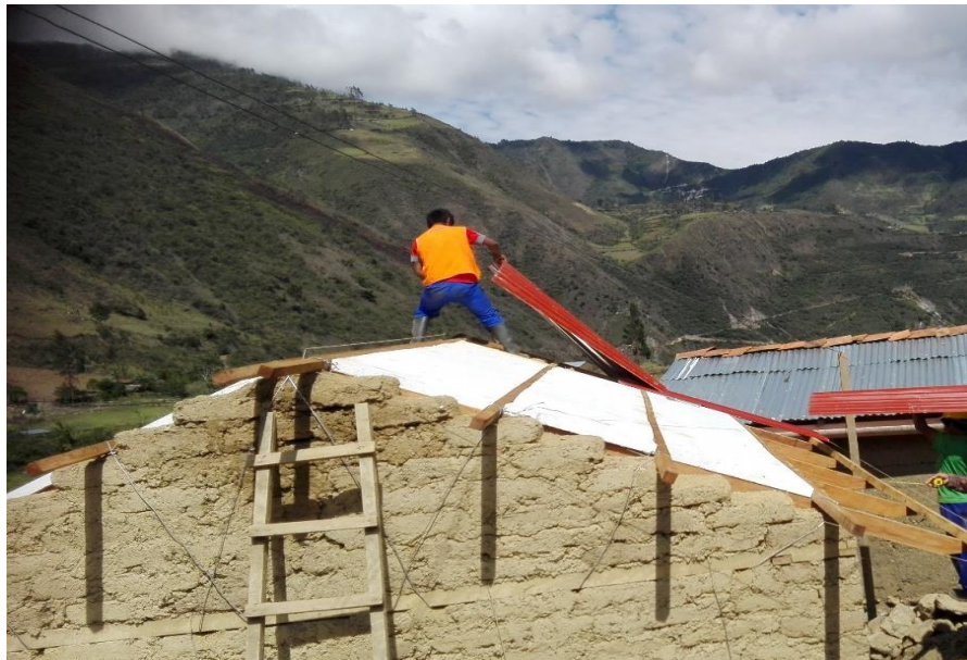
Figura 4: Verificando el proceso constructivo. Fuente: Elaboración propia.
