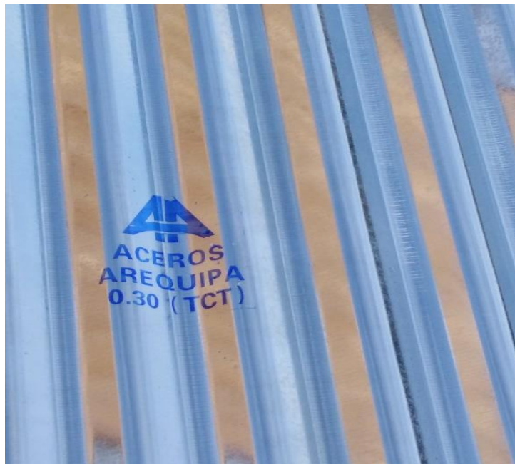
Figura 13: Verificación del sello en la calamina. Fuente: Elaboración propia.
