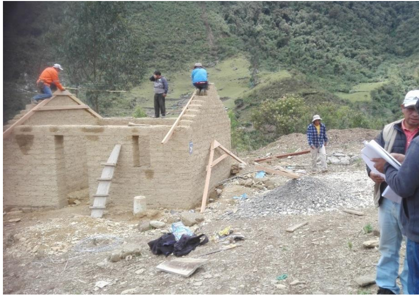
Figura 3: Instalación de tijerales. Fuente: Elaboración propia.
