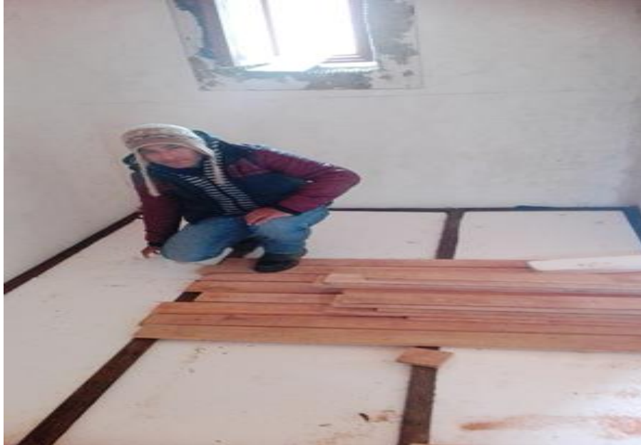
Figura 15: Verificación de las medidas del poliestireno. Fuente: Elaboración propia.
