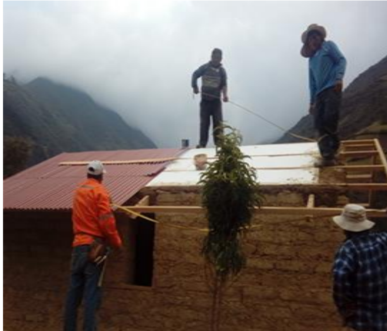
Figura 17: Antes de la colocación del tecknopor se verifico la densidad D=20\text{kg/m}^3 . Fuente: Elaboración propia.
