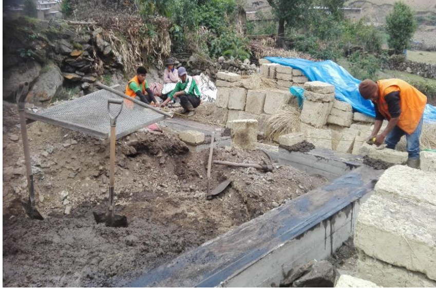
Figura 6: Colocado del aislante para evitar la capilaridad. Fuente: Elaboración propia.
