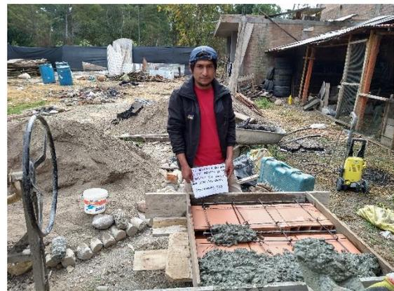
Fotografía 25. Vaciado del concreto en losas aligeradas.
