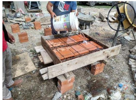
Fotografía 24. Encofrado de losas aligeradas.
