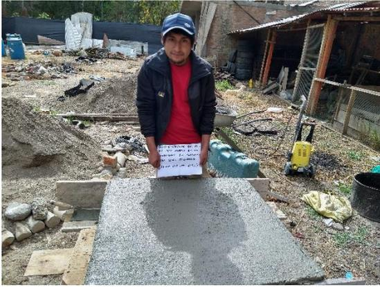
Fotografía 26. Acabado final del concreto en losas aligeradas.
