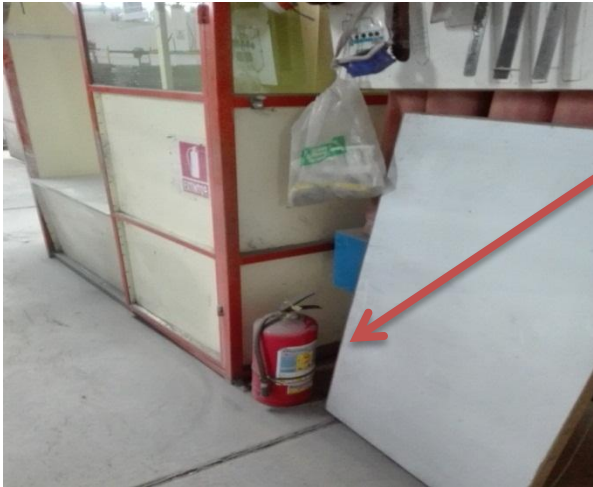
Ilustración 6: Extintores mal Ubicados
