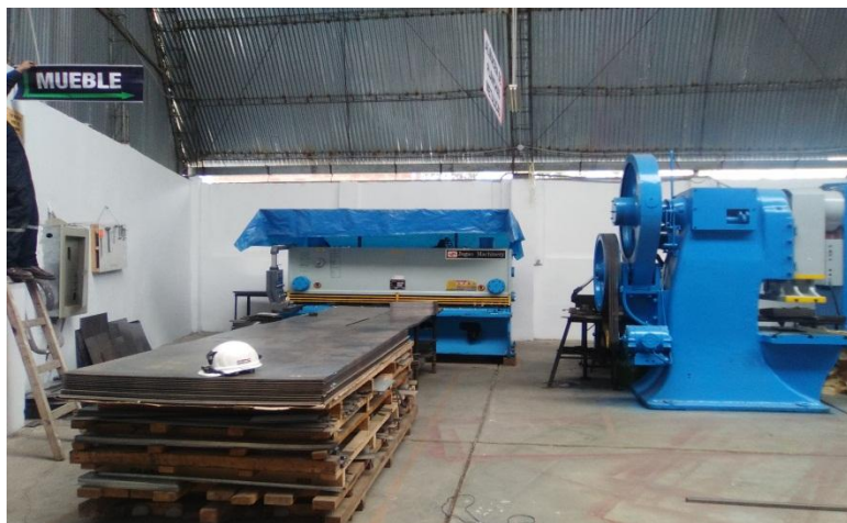
Ilustración 15: Falta de señalización
