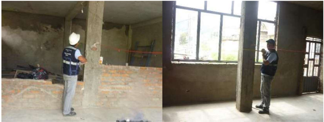
Replanteo de dimensiones en campo
