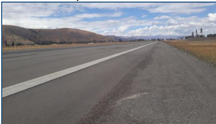
Fotografía 2. Pista de aterrizaje del Aeropuerto Francisco Carlé de Jauja
