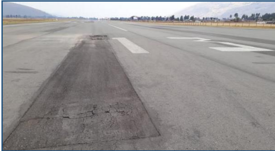
Fotografía 3. Designación de la pista de Aterrizaje
