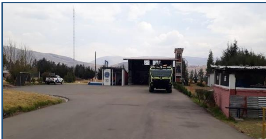
Fotografía 21. Instalaciones de los Bomberos aeronáuticos en el aeropuerto Francisco Carlé de Jauja
