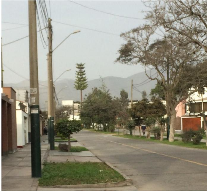
*Figura 2. Antena mimetizada con el entorno*
