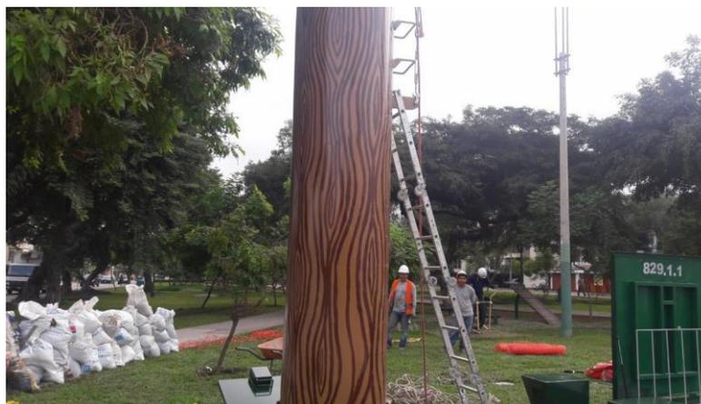
*Figura 1.* Estructura Antena diseñado como un árbol
