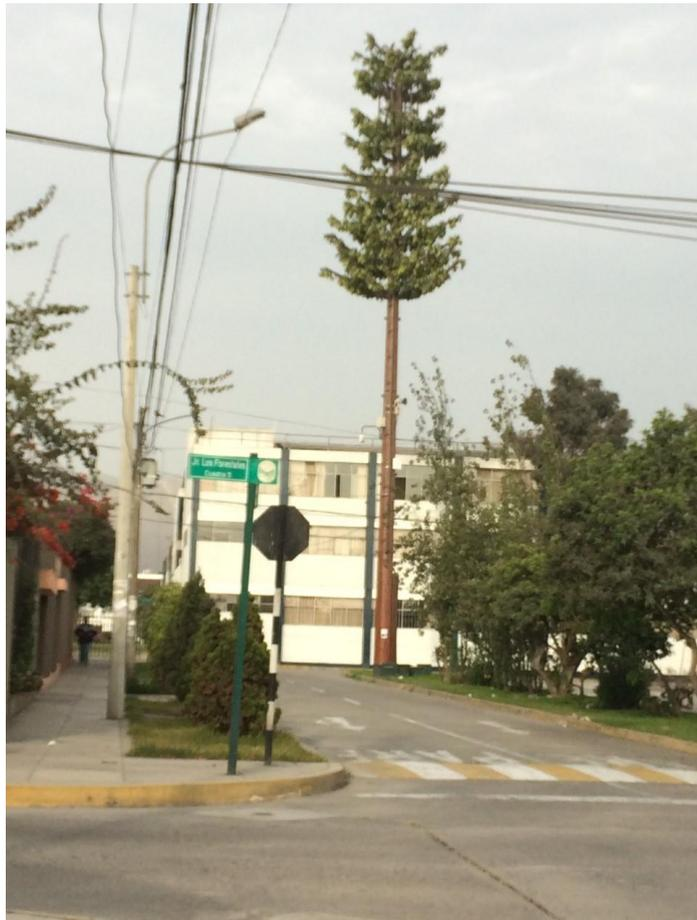
*Figura 3. Antena de telecomunicación en forma de árbol*
