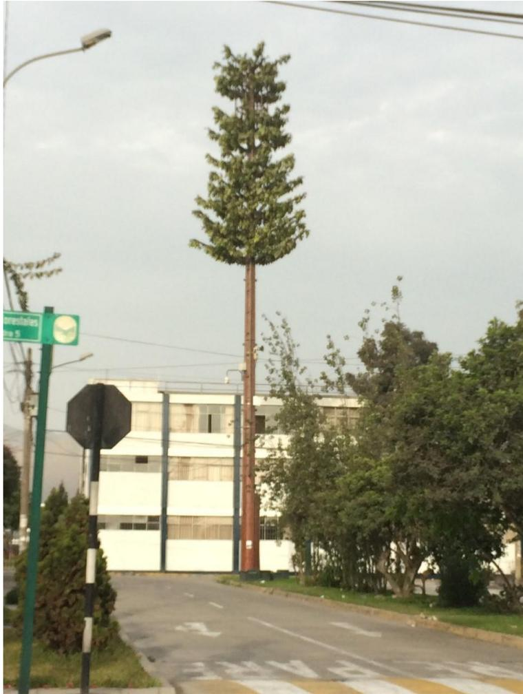
*Figura 4. Antena de telecomunicación en forma de árbol*
