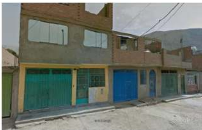
Figura 3 Viviendas de albañilería confinada en la urbanización La Floresta.
