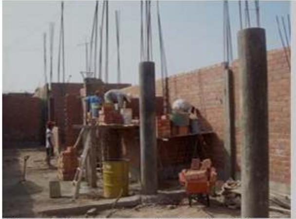
Figura 2 Proceso constructivo de vivienda de albañilería confinada en Huancayo.
