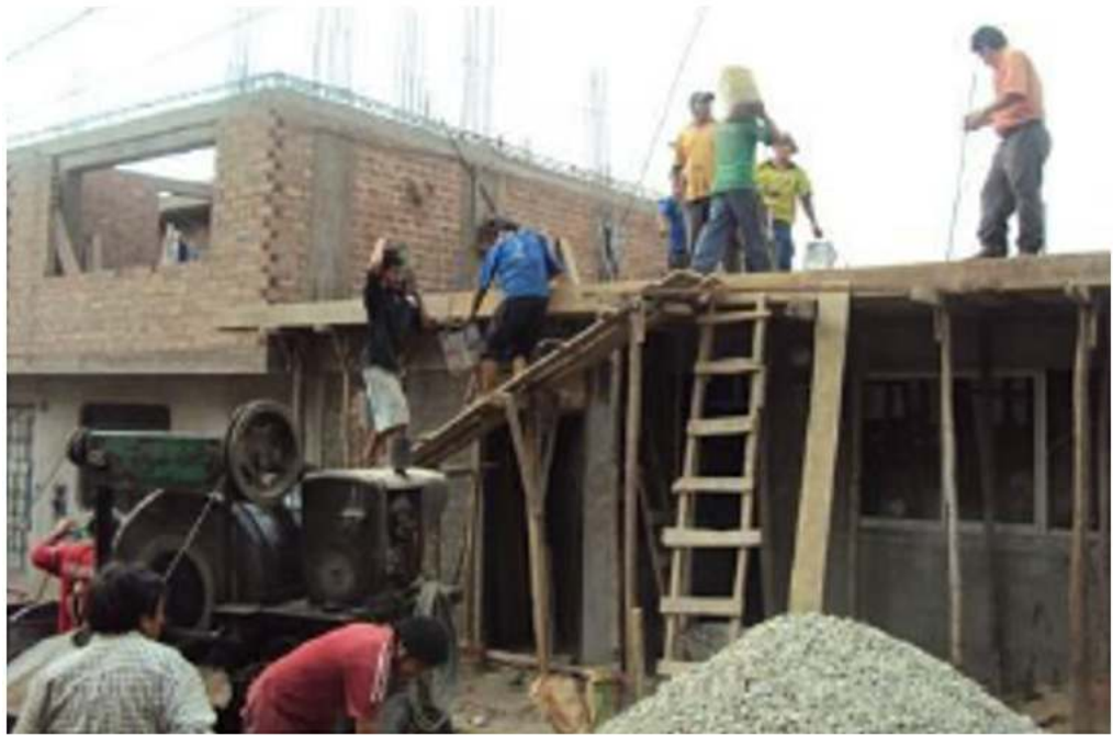
Figura 9 Preparado de concreto y vaciado de losa. Fuente: Elaboración propia.
