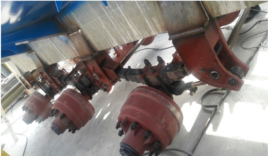
Fotografía: C-12 Instalación de ejes, suspensiones y sistema eléctrico.
