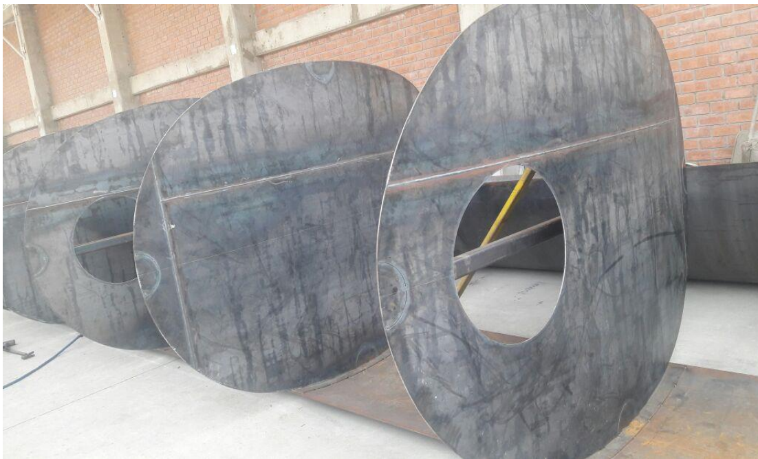
Fotografía: C-6 Armado de rompeolas.
