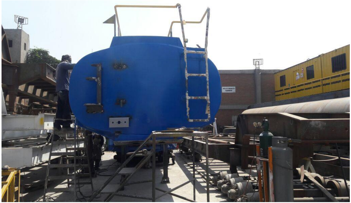
Fotografía: C- 11 Pintado general de la cisterna.
