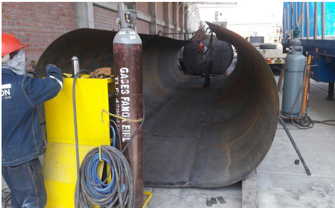
Fotografía:C-4 Armado de cuerpo de cisterna.
