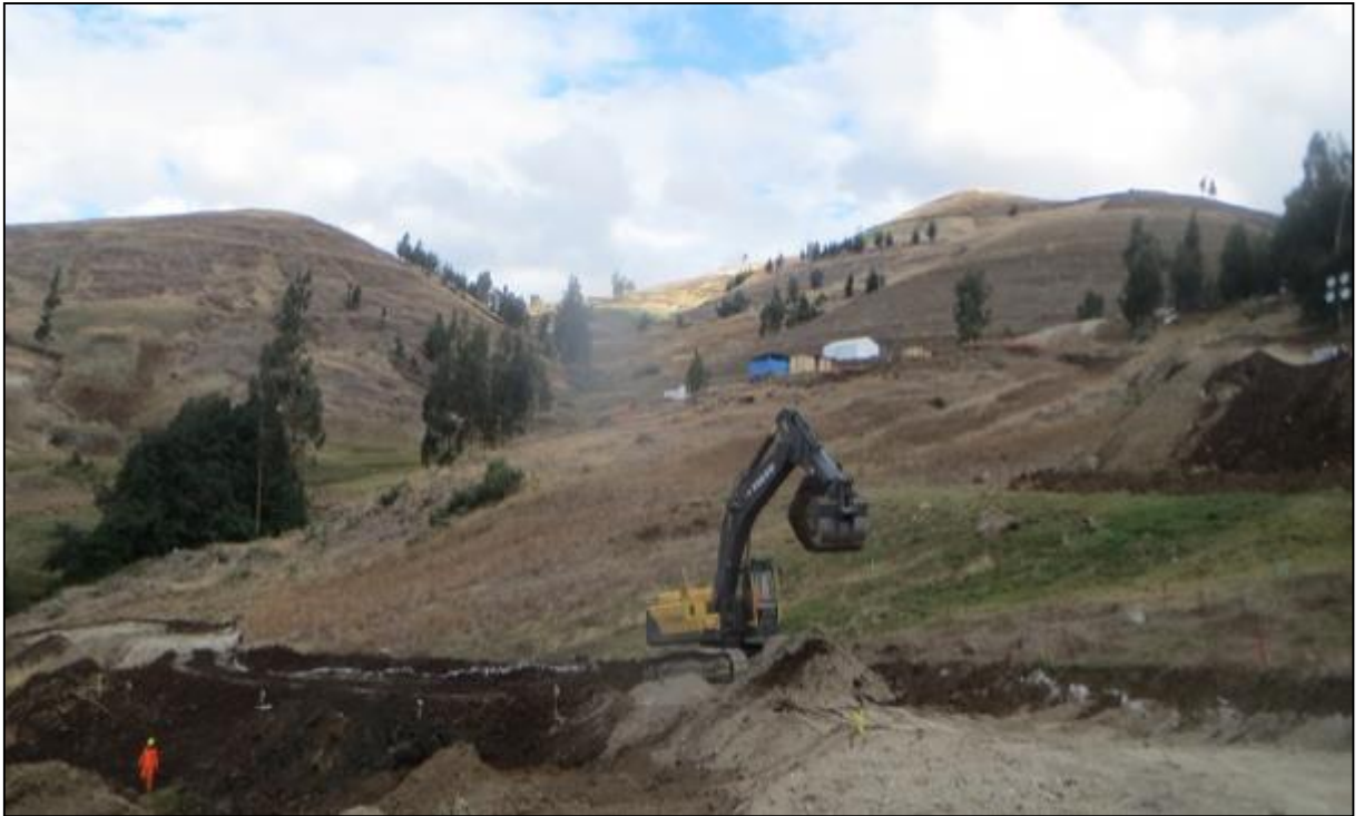
Figura 34, Vista del corte del terreno para la habilitación de las 04 plataformas
