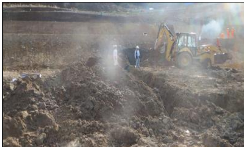
Figura 19, Vista de la excavación de subdrenes en la terraza N°03
