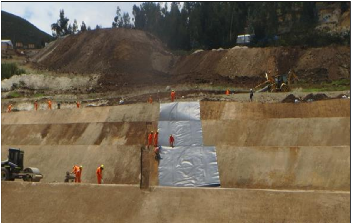
Figura 45, Vista frontal de las 04 terrazas sin presencia de humedad y listas para la instalación de las geomembranas.
