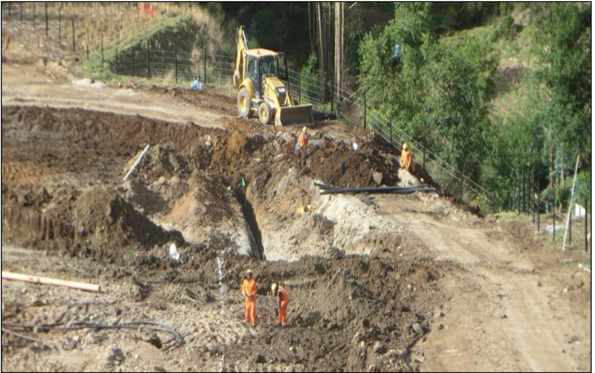
Figura 36, se observa la zanja excavada para la instalación de los subdrenes del lado derecho de las plataformas.
