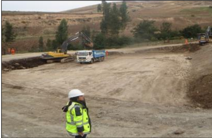
Figura 23, Vista de las terrazas 01 sin presencia de humedad.
