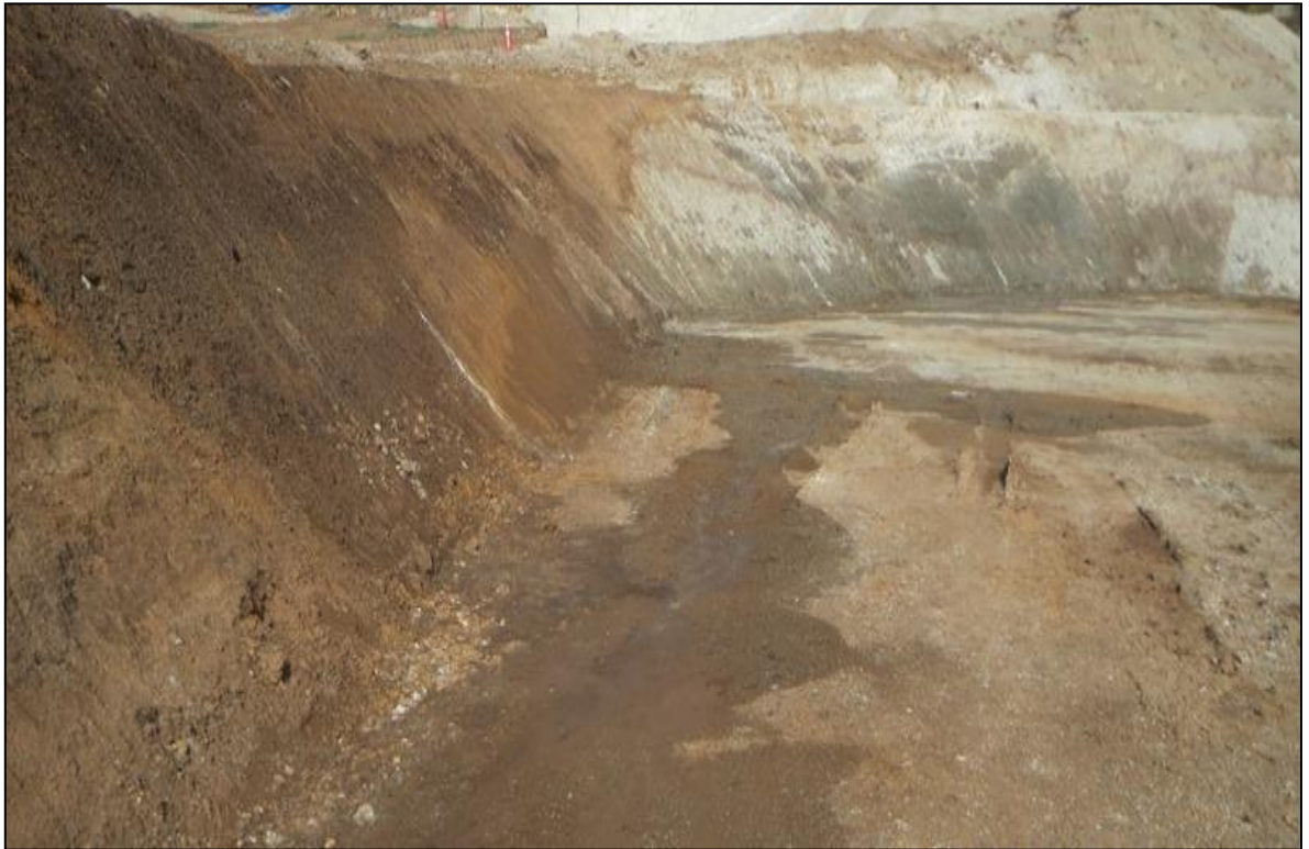
Figura 42, vista de la conformación y perfilado del suelo después de la instalación de los subdrenes
