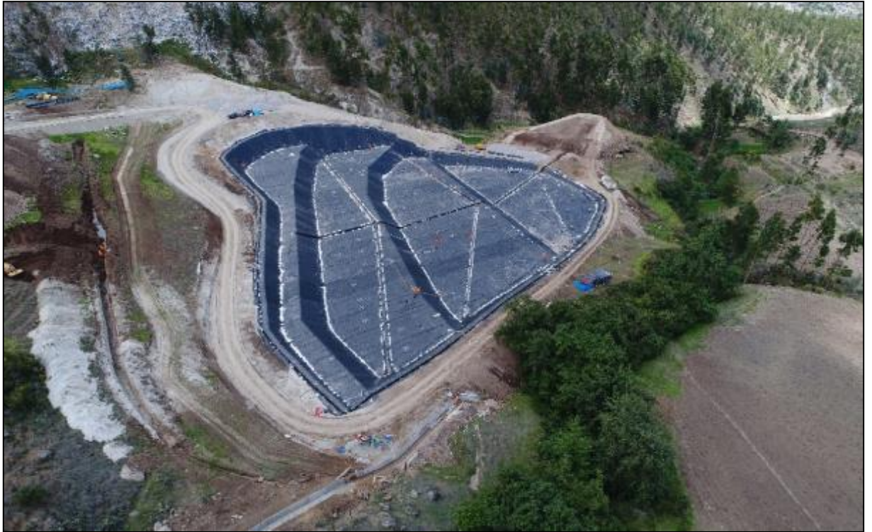
Figura 48, Vista vertical de la construcción del relleno sanitario de Andahuaylas
