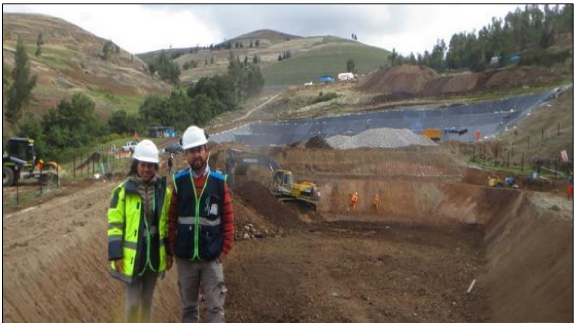
Figura 47, vista del proceso constructivo de la poza de lixiviado
