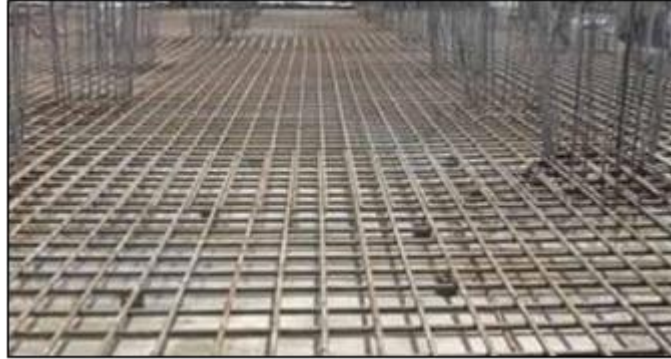
Figura 14: Losas y emparrillados
