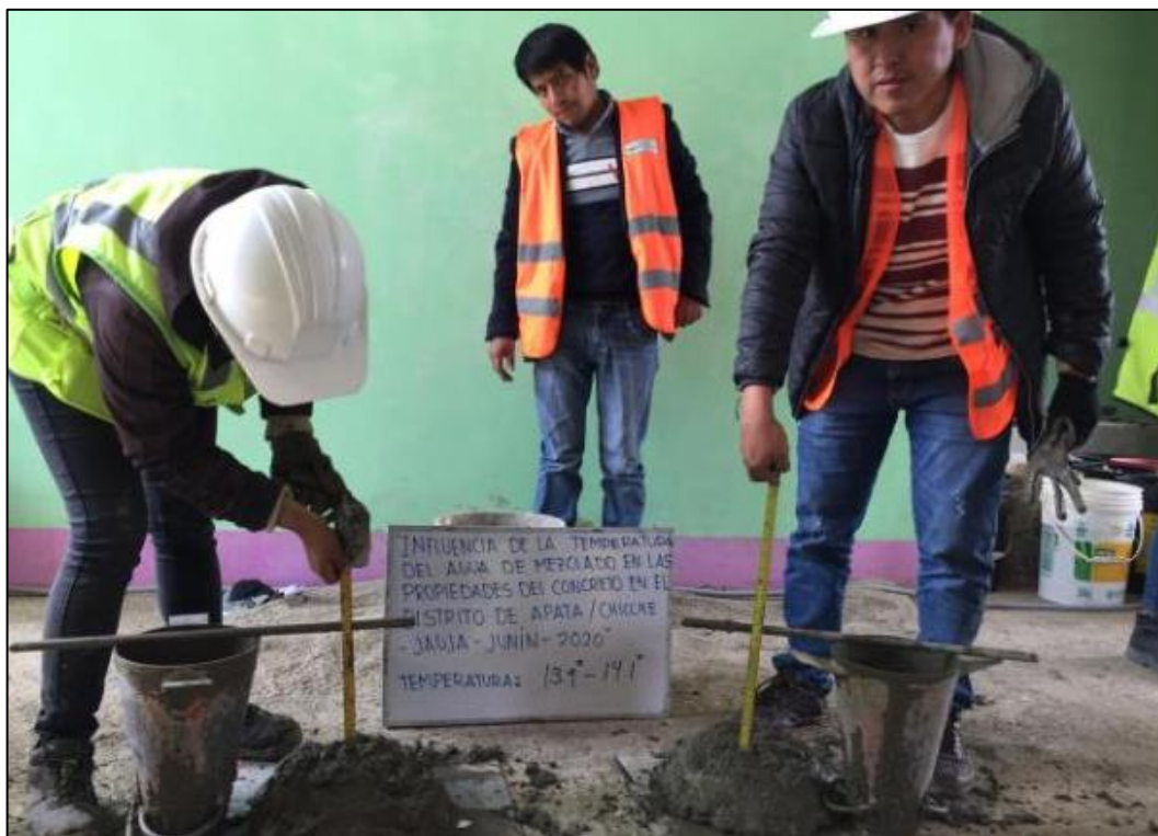
Fotografía 18. Medición del slump con el cono de Abrams para la mezcla de concreto con agua a 14 °C.
