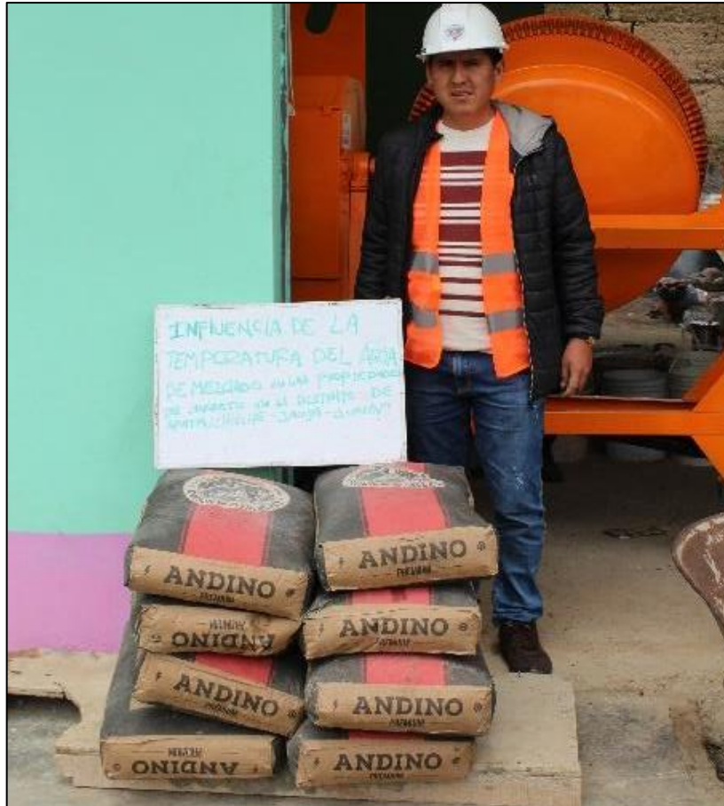
Fotografía 7. Control de calidad en el cemento, para evitar cualquier infiltración de humedad.
