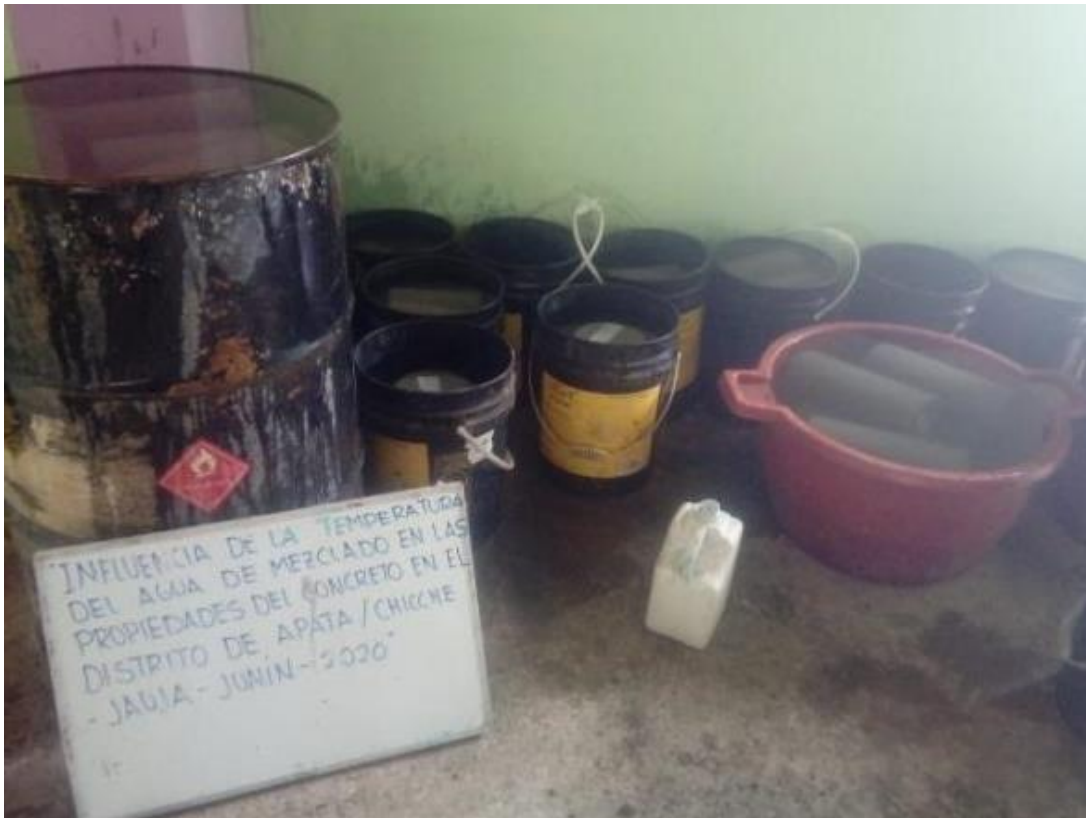
Fotografía 34. Curado del concreto con agua y cal a fin de evitar problemas químicos en concreto producto al agua.
