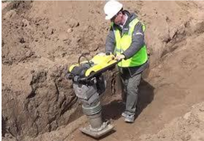
Figura 2.2-5 Utilización de la compactadora
