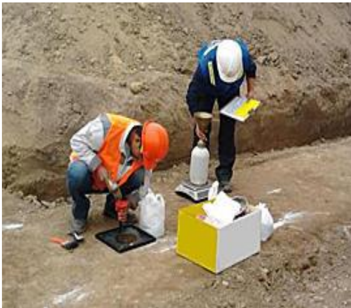
Figura 4.6-2 Extracción de los estratos rocosos en calicatas
