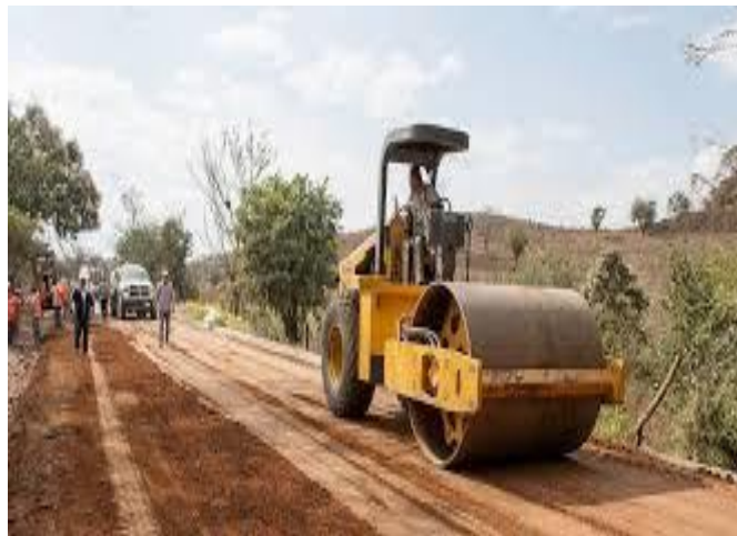
Figura 2.2-6 Utilización de un rodillo para compactación del terreno
