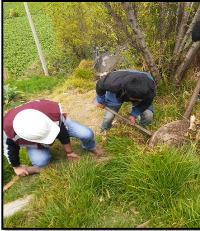
Fotografía 5 y Fotografía 6: Destapando el pozo de percolación donde discurre las aguas tratadas del biodigestor para su posterior recepción y almacenamiento.
