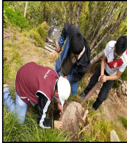
Fotografía 5 y Fotografía 6: Destapando el pozo de percolación donde discurre las aguas tratadas del biodigestor para su posterior recepción y almacenamiento.
