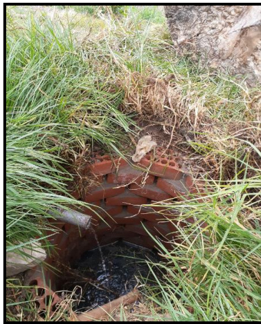
Fotografía 7 y Fotografía 8: Nos muestra el flujo de agua tratada de biodigestor que desciende al pozo de percolación y su recepción para el almacenamiento.
