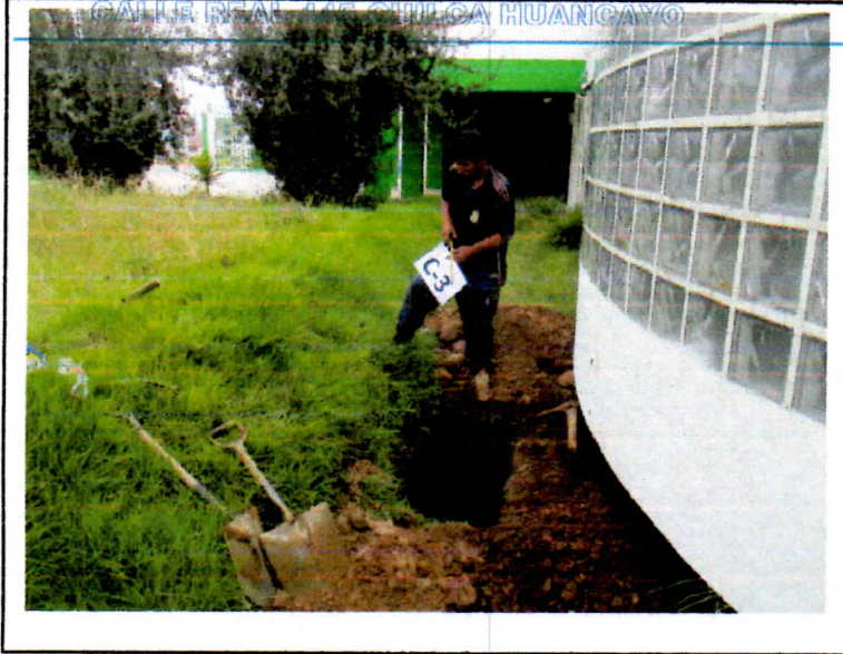
FOTO 07.- EXCAVACIÓN DE LA C-3
