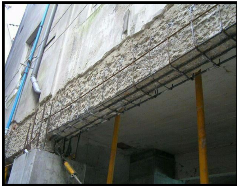
Figura N° 19. Encamisado de Viga
