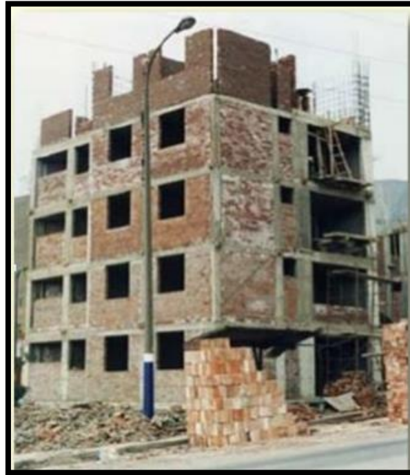
Figura N°11. Muros y pórticos (mixta)
