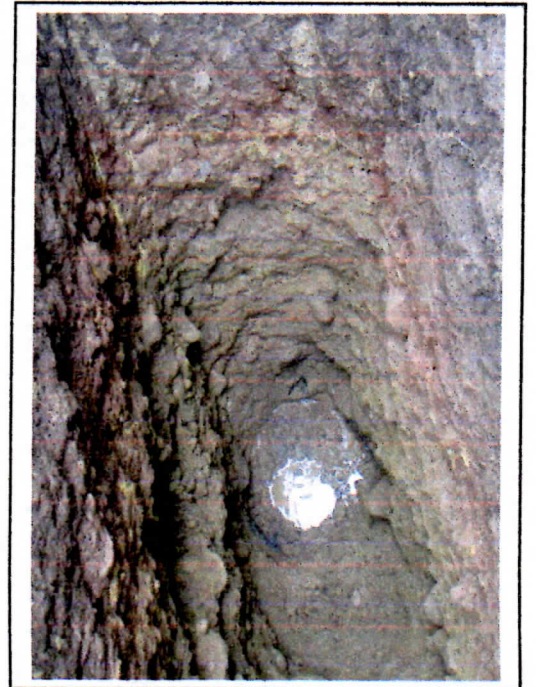
FOTO 08.- SE OBSERVA EL PERFIL DE LA CALICATA C-3
