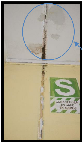
PROBLEMAS DE FILTRACIÓN ENTRE LAS VIGAS.
