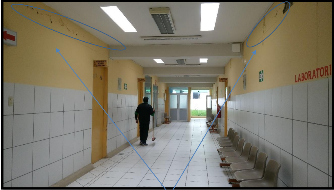
En ambas vigas secundarias se observa las fisuras ocasionando esto que la estructura falle.
