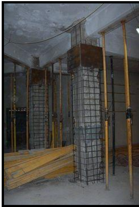
Figura N° 18. Encamisado de Columna
