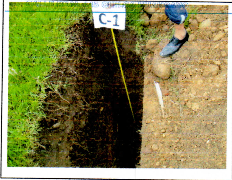
FOTO 03.- PROFUNDIDAD EXCAVADA DE LA C-1 A 2.70 mt
