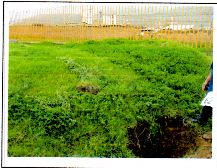
FOTO 04.- EXCAVACIÓN DE LA C-2
