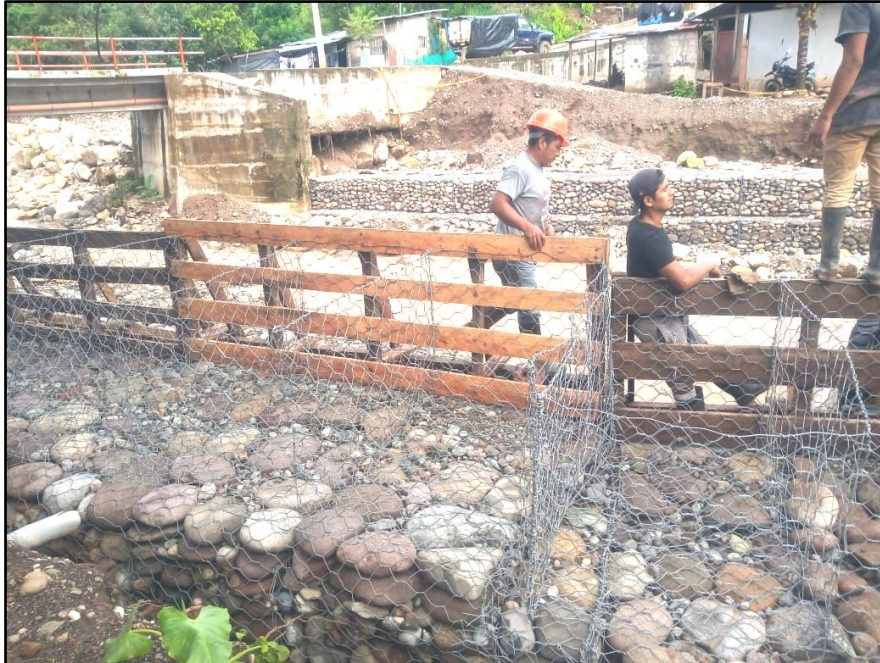
Fotografía 12. Armado de los gaviones de 1X 1.5 X 5 m.
