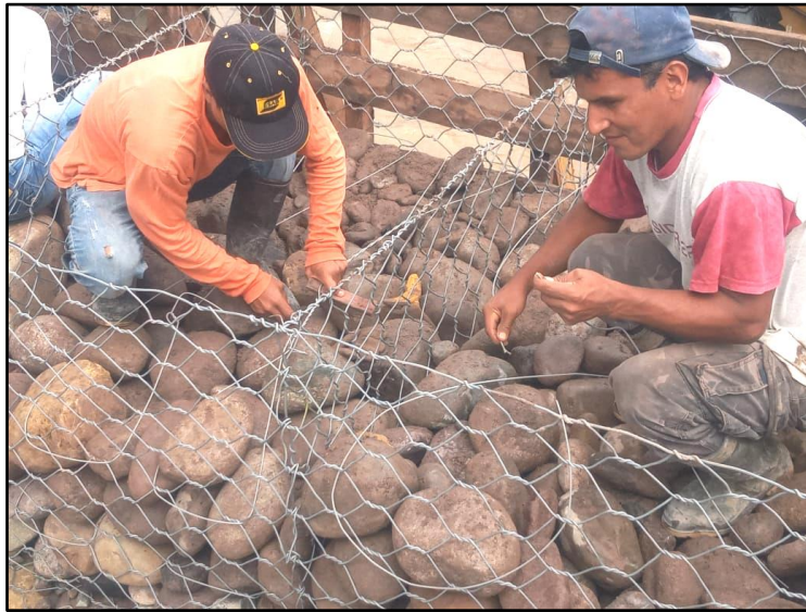
Fotografía 14. Colocación de los tensores en los gaviones
