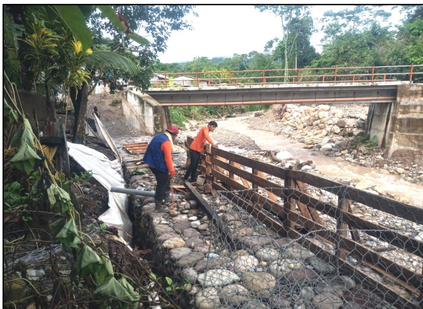
Fotografía 11. Armado de canastas
