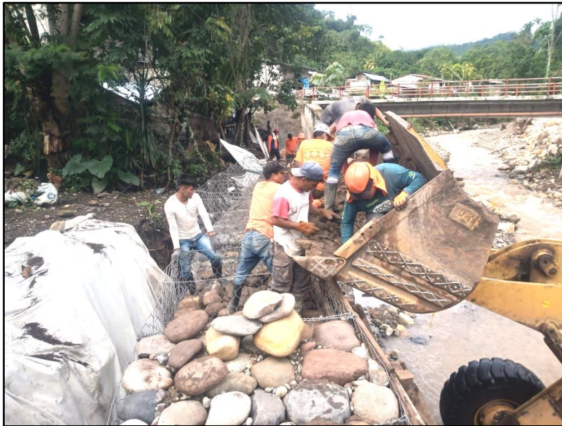
Fotografía 13. Llenado de gaviones de con ayuda del cargador frontal.
