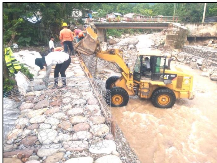
Fotografía 15. Colocación de las tapas en los gaviones de 1 x 1.5 x 5 m
