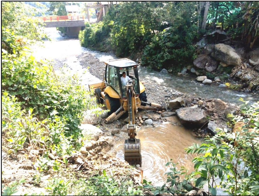
Fotografía 9. Descolmatación del Rio Shuaro.
