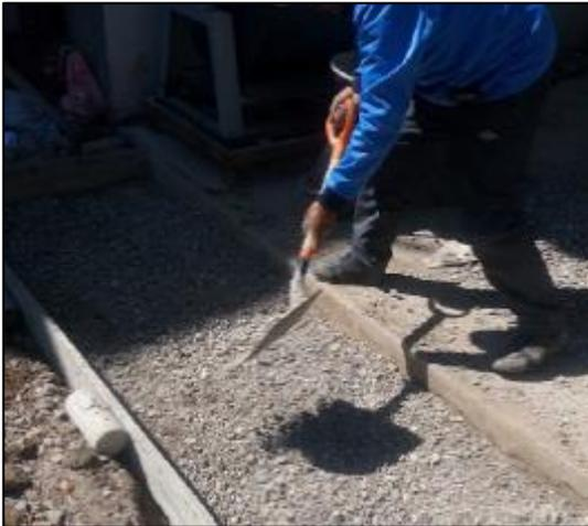
Fotografía 41. Material granular base para el vaciado del concreto permeable óptimo.
