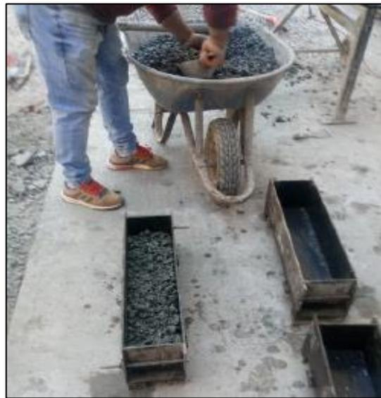
Fotografía 34. Preparado de vigas de concreto permeable.
