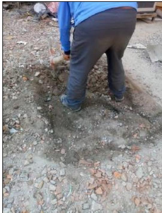
Fotografía 39. Excavación para el vaciado de concreto permeable.
