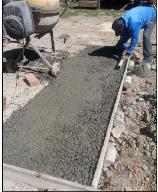
Fotografía 43. Vista del concreto permeable óptimo vaciado.
