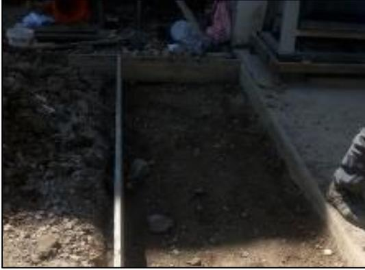
Fotografía 40. Encofrado para el vaciado de concreto permeable.
