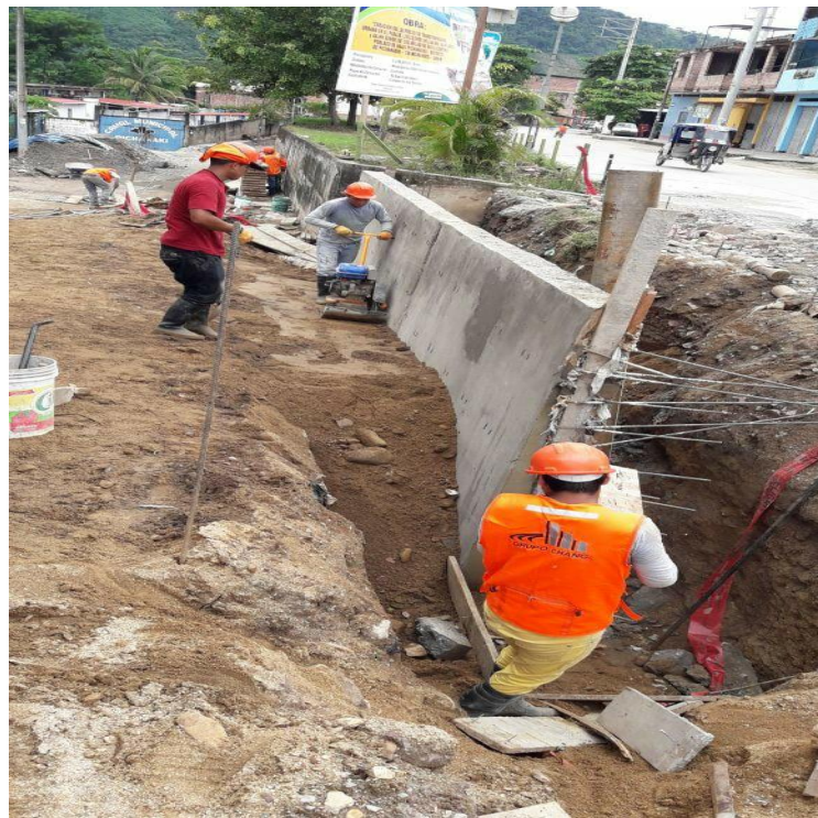
Fotografía N° 26: Desencofrado del Muro de Contención.
