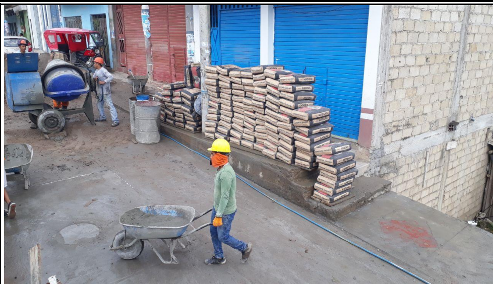
Fotografía N° 37: Vaceado de concreto para pavimento con F'C=250 kg/cm 2
