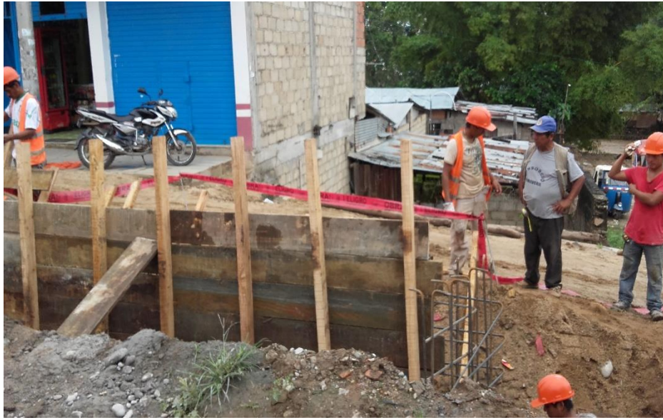
Fotografía N° 25: vaceado del Muro de Contencion
