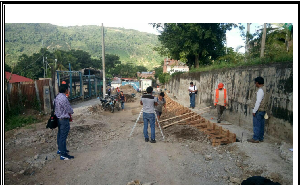
Fotografía N° 10: trabajos topográficos, realizando la nivelación de las veredas.
