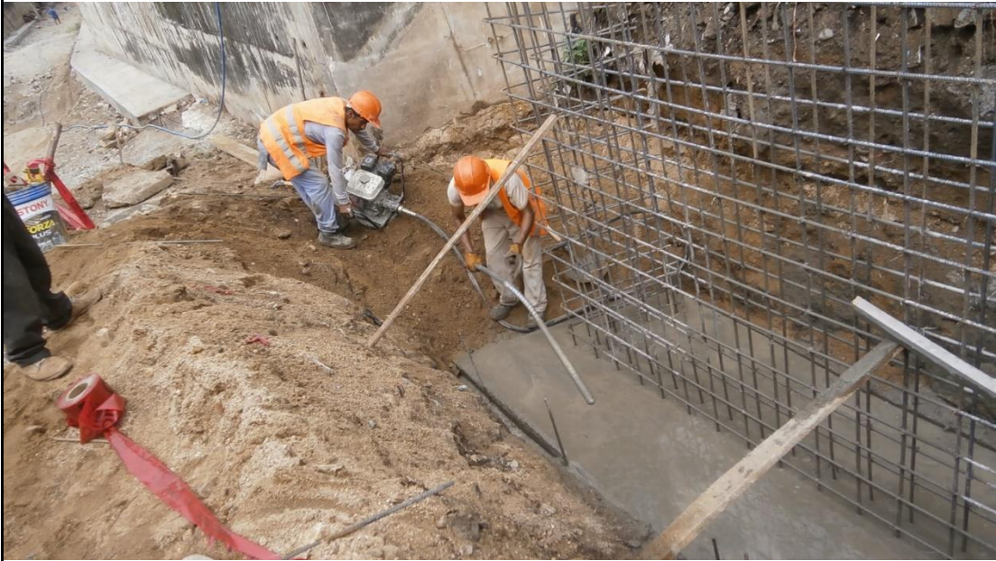
Fotografía N° 21: Vibrado en zapatas
