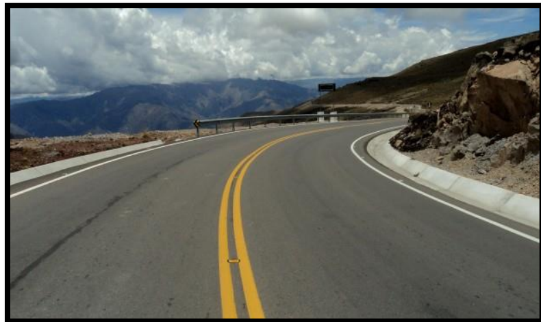
Figura 3: Vía departamental Ayacucho – Abancay
