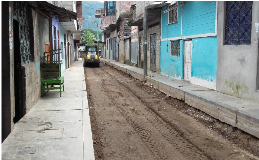
Fotografía N° 02: compactación de Sub Rasante en la entrada del pasaje los cedros AA.HH. La Playa.
