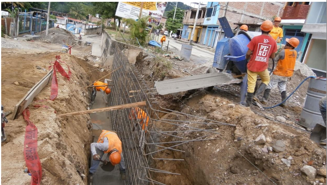
Fotografía N° 22: Vacado en zapatas de Muro de Contención
