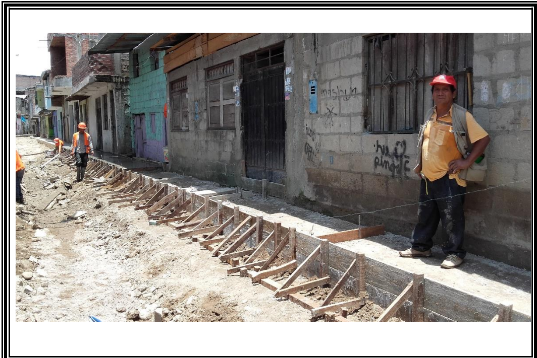
Fotografía N° 15: Encofrado y nivelación de veredas en el pasaje Los Cedros-AA.HH. La Playa.
