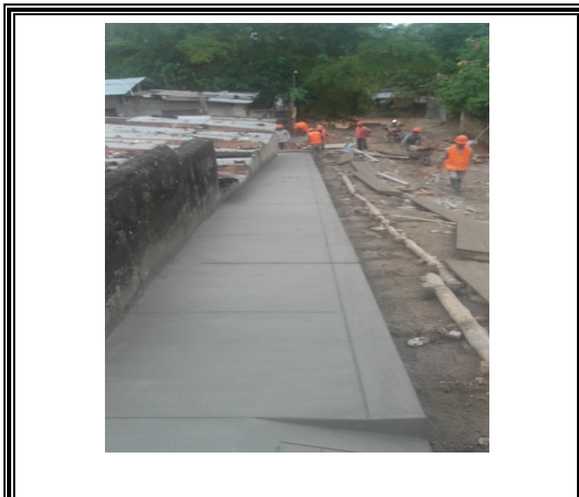
Fotografía N° 16: Acabado y Bruñado de Veredas en pasaje 04
