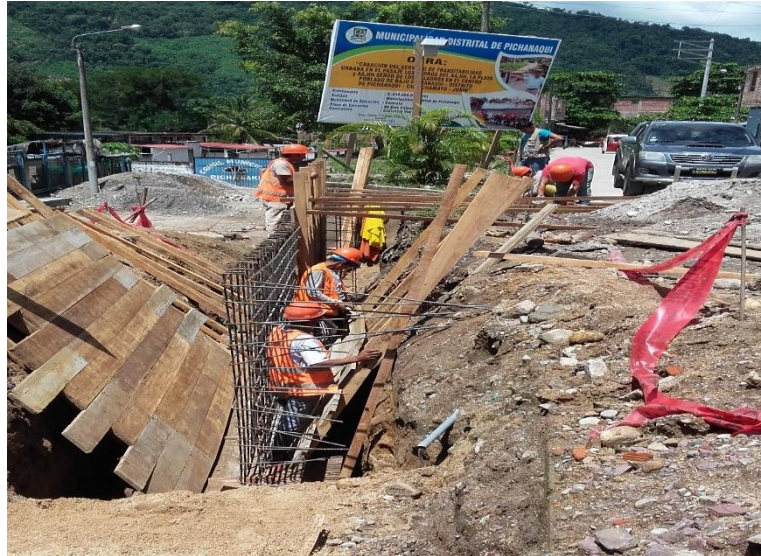
Fotografía N° 23: Encofrado del muro de contencion
