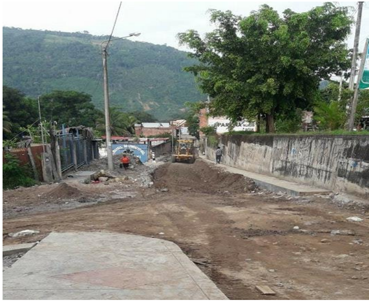
Fotografía N° 05: Conformación de base H=0.20m en el AA.HH. Señor de Los Milagros
