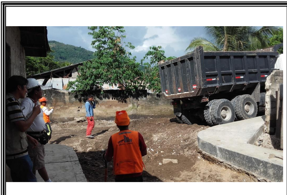
Fotografía N° 03: Abastecimiento de material de préstamo para la conformación de la Base – pavimento en el Pasaje Los Cedros, AA.HH. La Playa.
