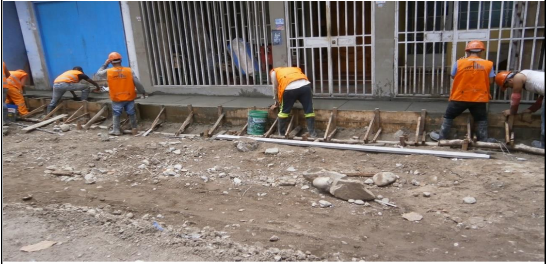
Fotografía N° 13: Acabado y Bruñado de Veredas en el AA.HH. Señor de Los Milagros Margen Derecha
