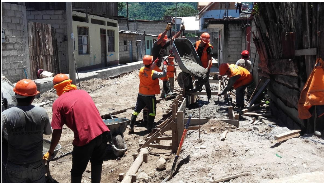
Fotografía N° 12: vaceado de concreto en veredas f'c=175 en el AA.HH. Señor de Los Milagros
