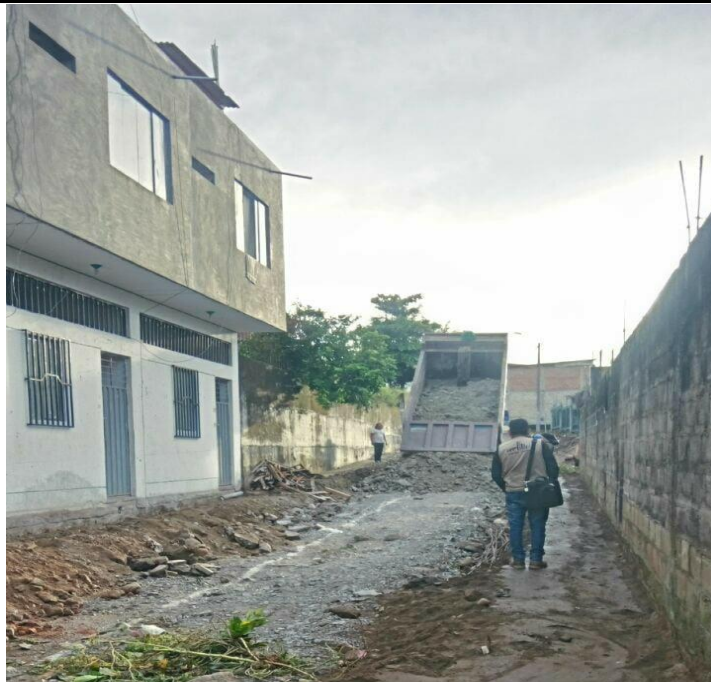
Fotografía N° 08: trabajos con maquinarias de corte.
