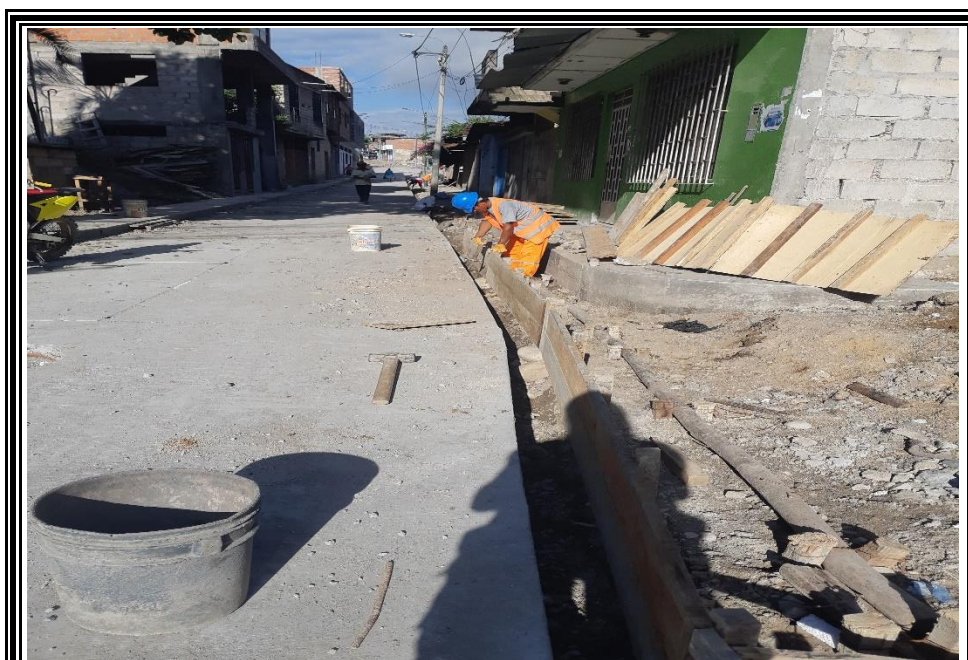
Fotografía N° 30: En imágenes se observa el encofrado cunetas y de sardineles.
