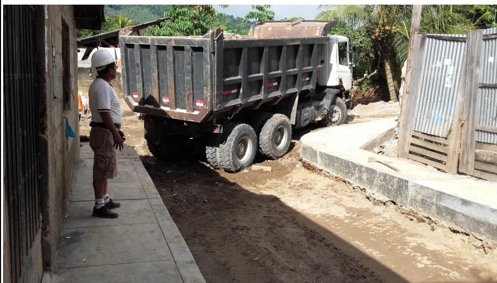
Fotografía N° 04: Colocación de material de préstamo para conformación de base H=0.20 m del pavimento en el Pasaje Los Cedros AA.HH. La Playa.
