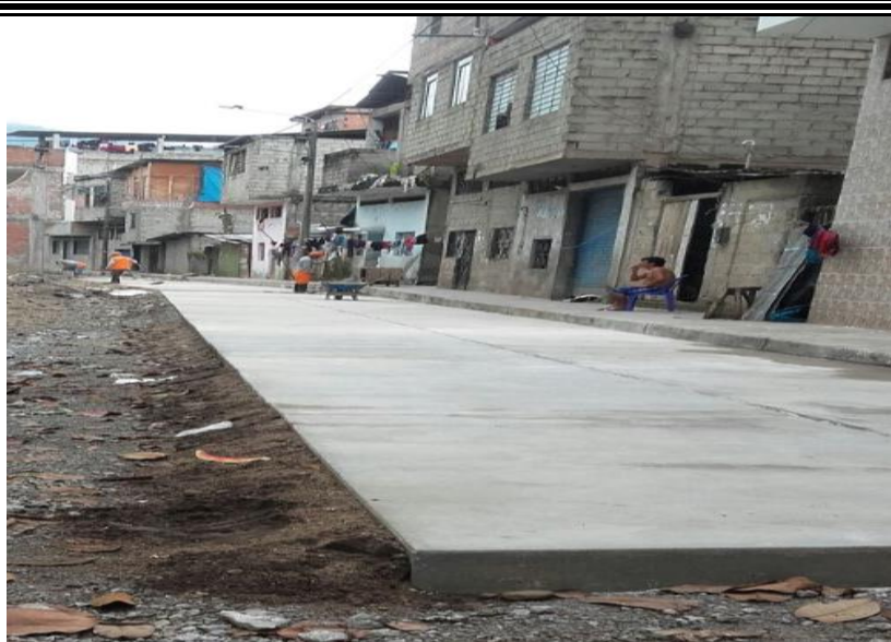
Fotografía N° 36: limpieza del pavimento.
