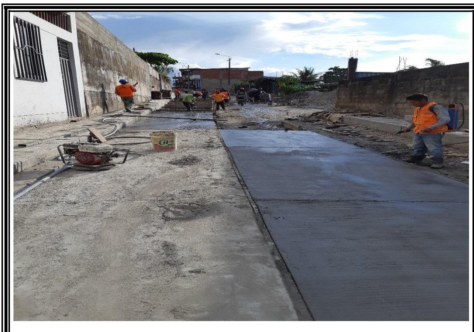
Fotografía N° 29: En imágenes se observa el colocado de aditivo anti-sol en el pavimento - curado de pavimento.
