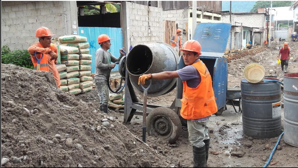
Fotografía N° 11: Habilitación de material y equipos para el vaceado de veredas
