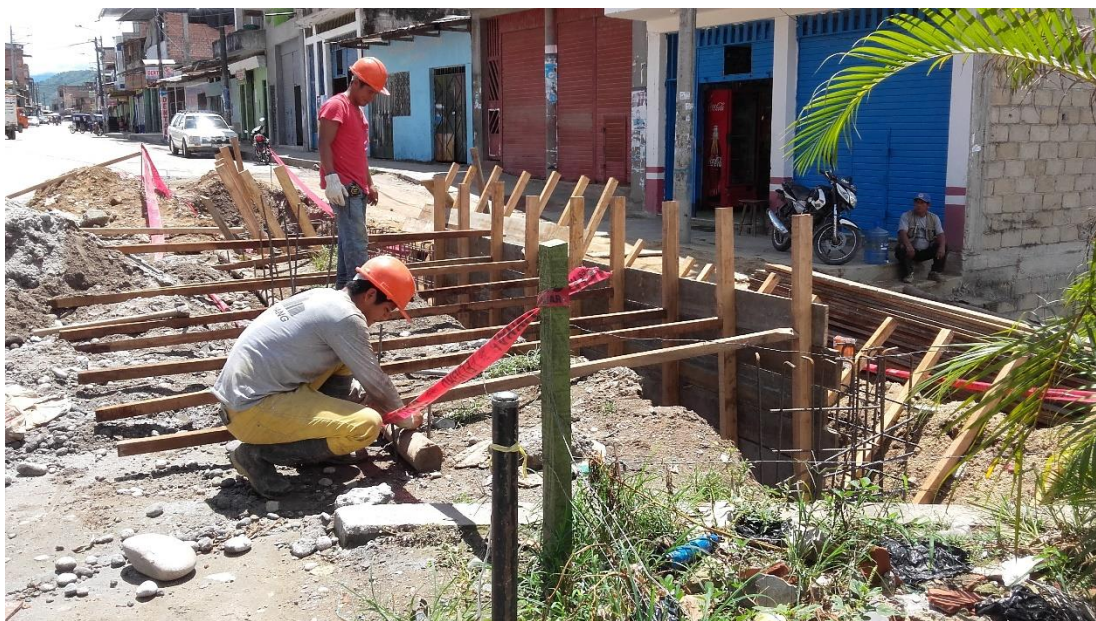
Fotografía N° 24: Encofrado del muro de contencion
