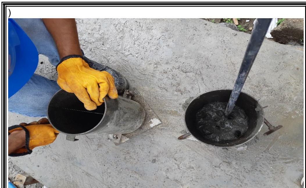
Fotografía N° 28: Se observa las muestras de concreto (probetas-testigos) para poder realizar los ensayos correspondientes.
