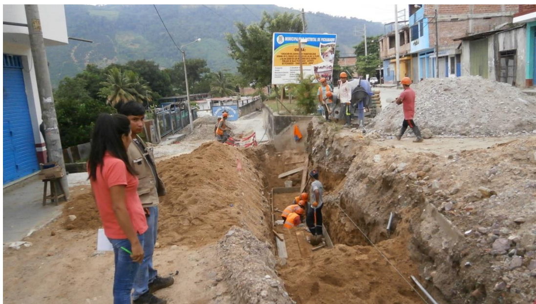
Fotografía N° 18: Conformación del solado del muro de contención.
