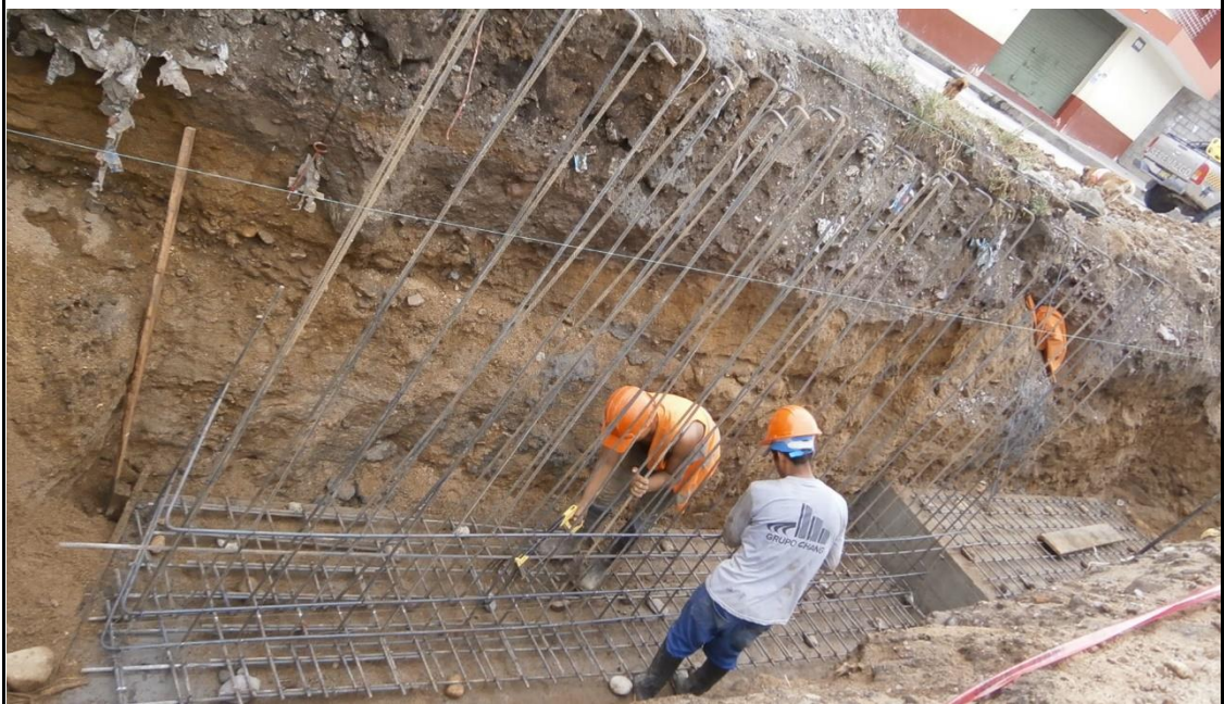
Fotografía N° 20: Colocación de las malla de acero para la zapata y muro de contención .
