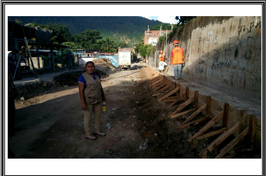
Fotografía N° 09: Conformación y compactación y encofrado de veredas
