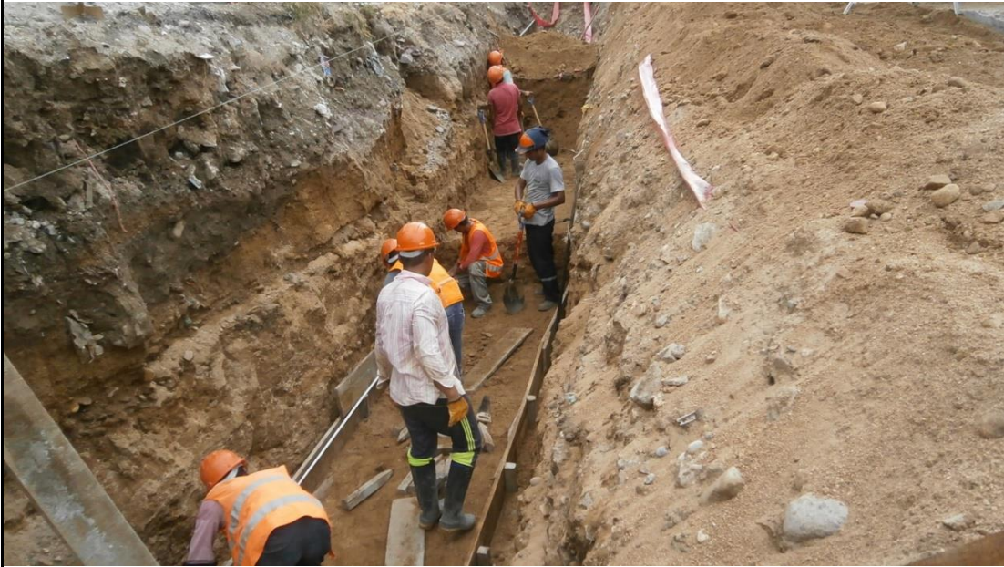
Fotografía N° 17: Excavación de Zanjas para la conformación del solado del muro de contención
