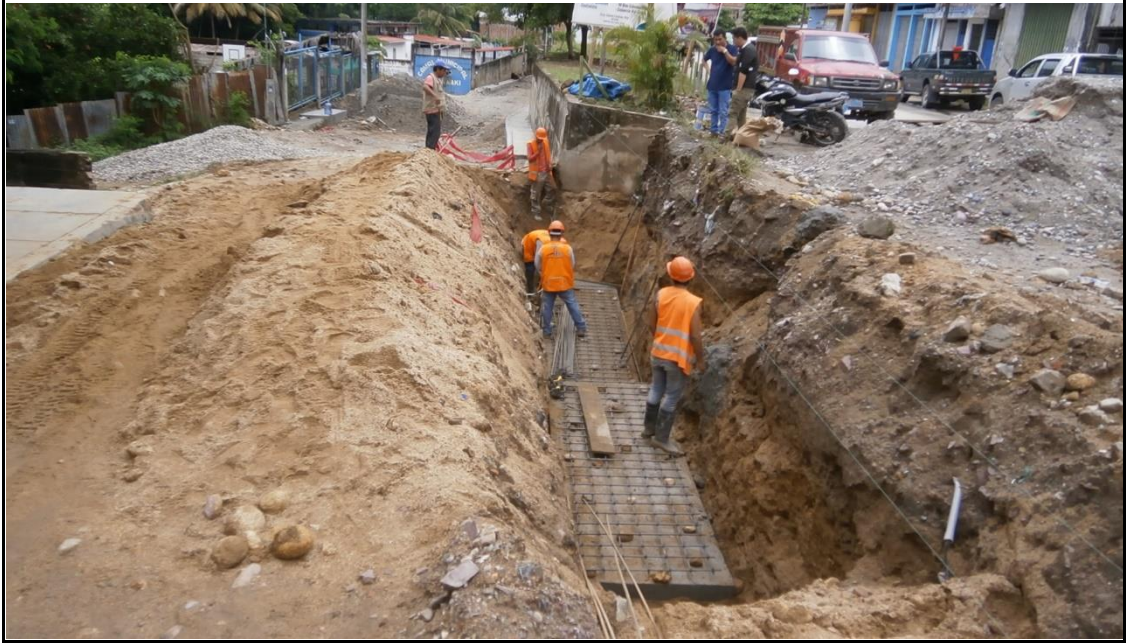
Fotografía N° 19: conformación de la zapata del muro de contención
