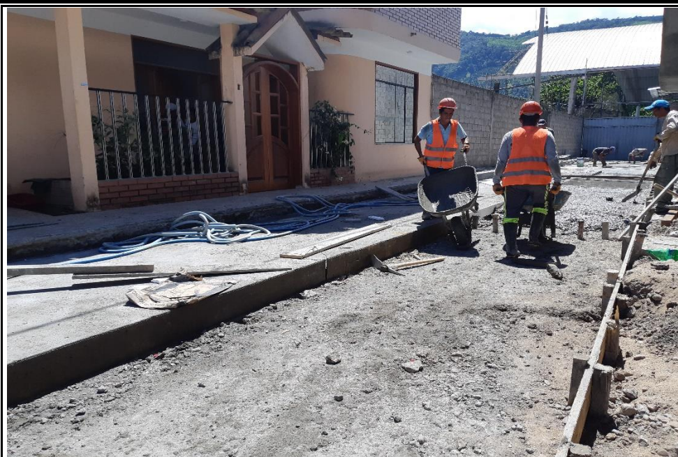
Fotografía N° 31: Se observa el vaciado de pavimento F'C= 210 kg/cm 2
