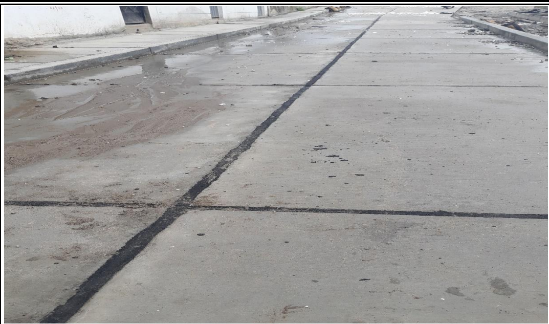
Fotografía N° 38: Sellado de juntas con asfalto RC=250 en juntas de dilatacion
