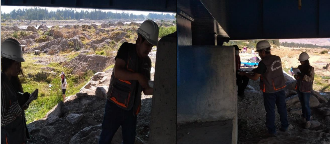
Toma de datos del esclerómetro en el estribo de la margen izquierda.
