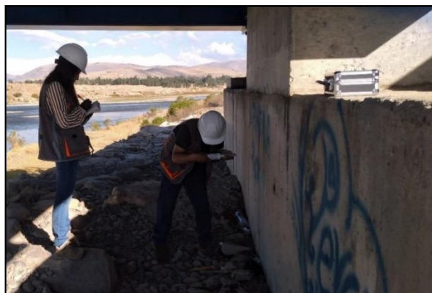
Fotografía de la Esclerometría en el Estribo
