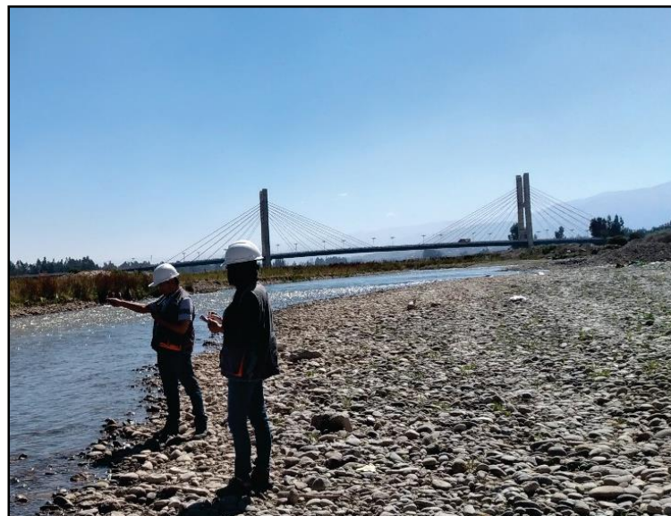
Fotografía Panorámica del Puente Comunero I
