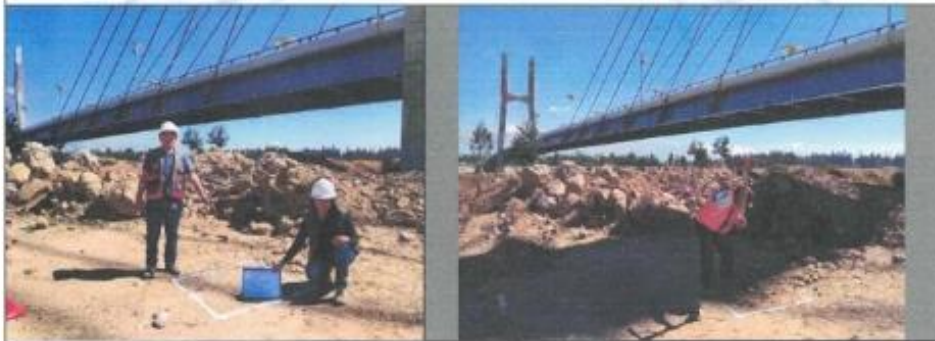
Calicata N°01 margen izquierda, de 1.00 metro por 1.00 metro, excavación de 1.50m.
