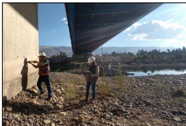
Fotografía de la Esclerometría en el Pilón - Inferior
