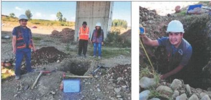
Calicata N°01 margen izquierda, de 1.00 metro por 1.00 metro, excavación de 1.50m.
