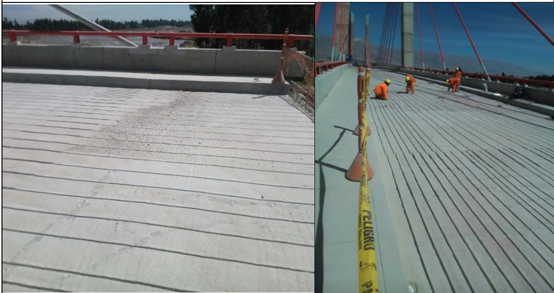
Colocación de la barra de fibra de carbono en la ranura de losa del puente
