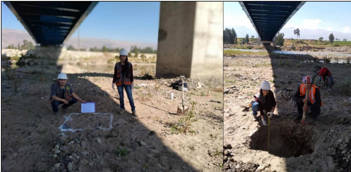
Calicata N°05 margen derecha, de 1.00 metro por 1.00 metro, excavación de 1.50m.
