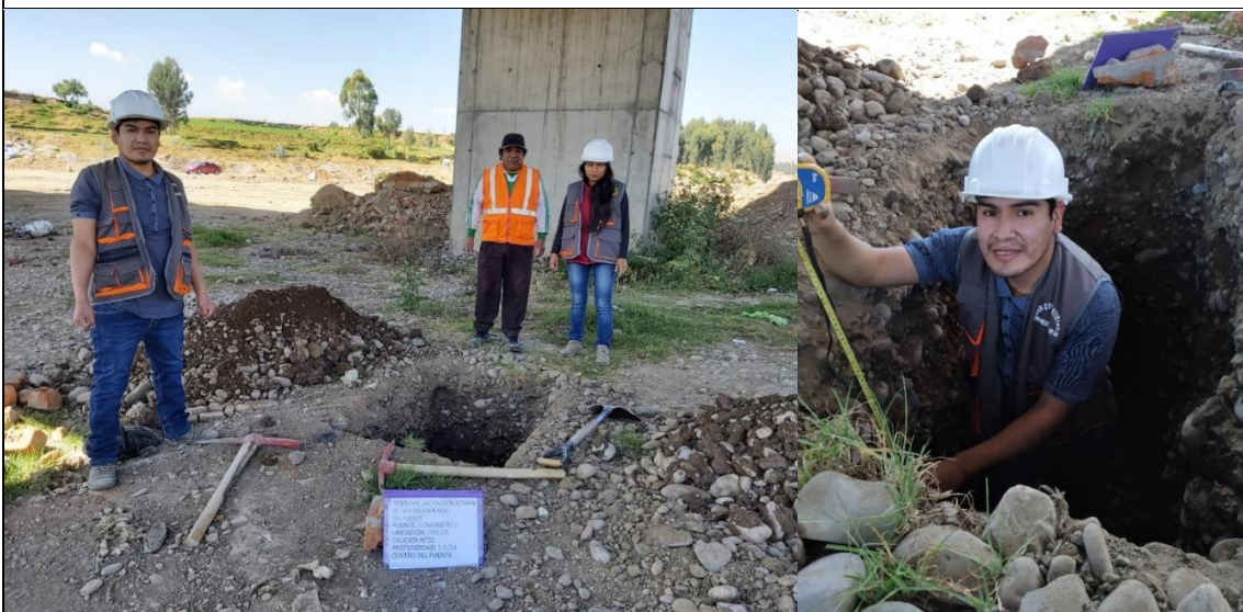
Calicata N°02 margen izquierda, de 1.00 metro por 1.00 metro, excavación de 1.50m.
