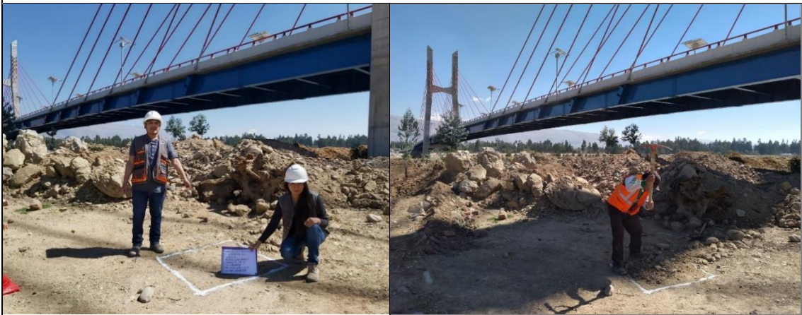
Calicata N°01 margen izquierda, de 1.00 metro por 1.00 metro, excavación de 1.50m.
