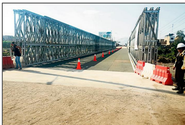
Fotografía del Nuevo Puente Virú
