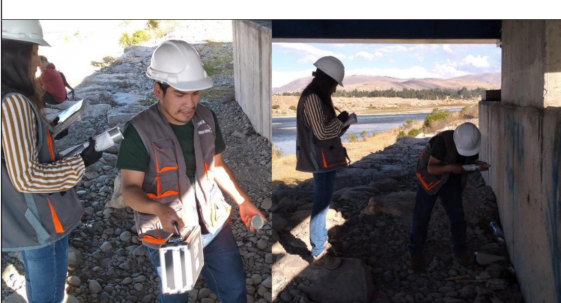
Limpeza en el área y toma de dato del esclerómetro en el estribo de la margen derecha.
