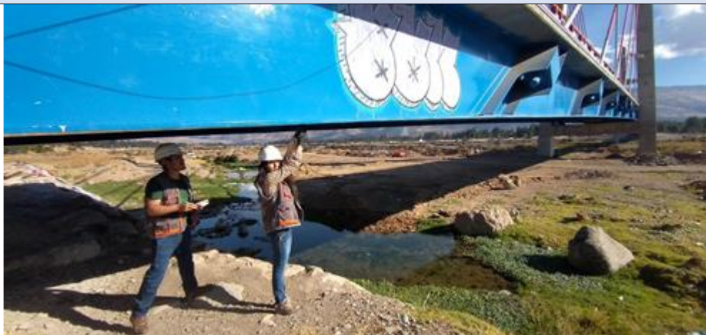
La medición de espesores de pintura con el equipo de inspección POSITECTOR 6000, se realizó en las vigas transversal y longitudinales del puente Comunero I.
