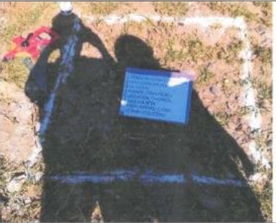
Calicata N°04 margen derecha, de 1.00 metro por 1.00 metro, excavación de 1.50m.
