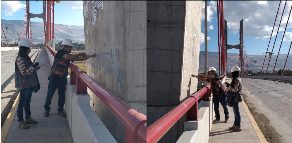
Toma de datos del esclerómetro en los pilones en la parte superior de la losa
