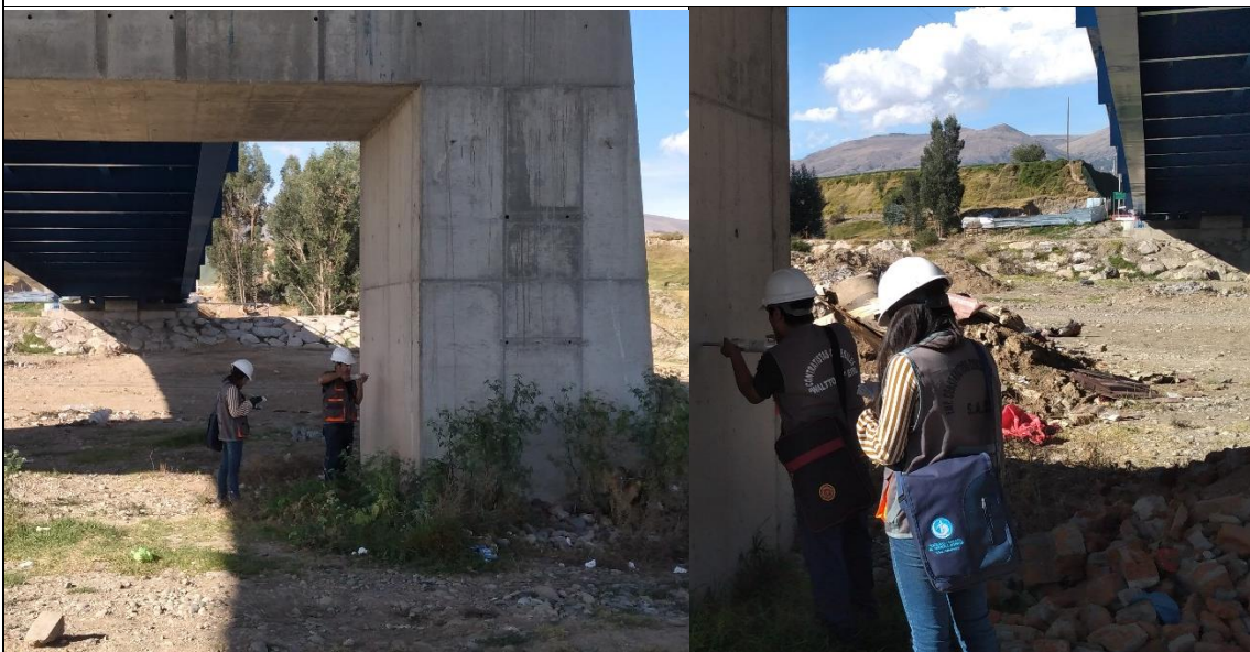
Toma de datos del esclerómetro en el pilón de la margen izquierda.
