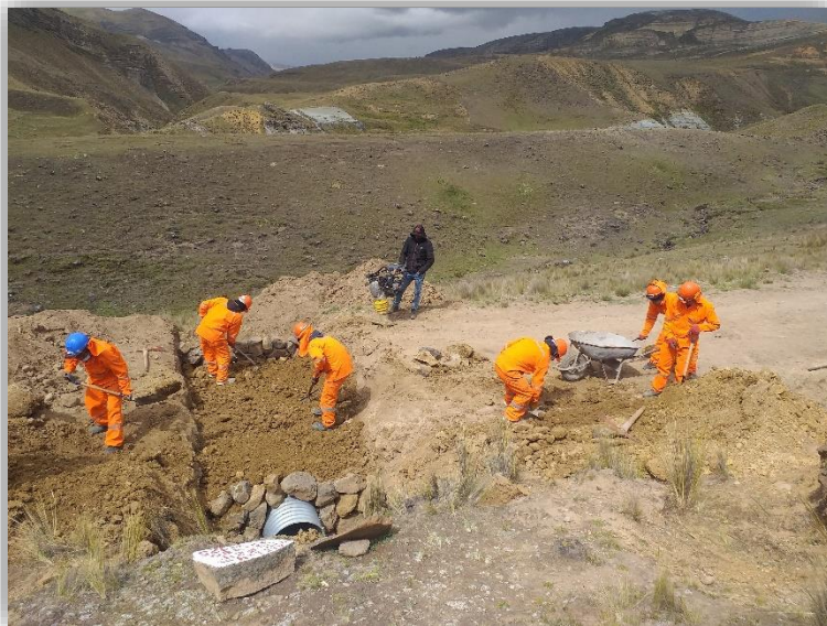
Imagen 08: en la imagen se observa la cuadrilla mejorada en la partida de relleno y compactado con material propio, los cuales cada uno tiene una determinada función de esta manera eliminado en gran proporción los tiempos no contributivos, mejorando los tiempos contributivos y optimizando los trabajos productivos para esta partida.
