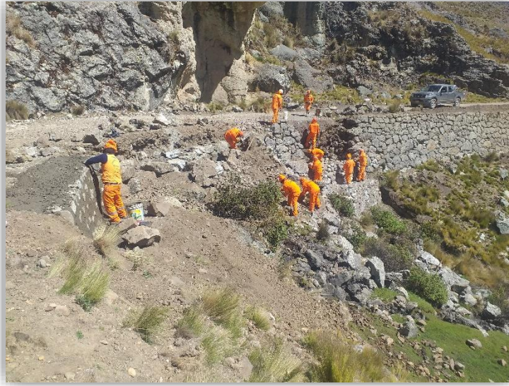
Imagen 09: en la imagen se observa la cuadrilla real de la partida de reparación de muros de mampostería de piedra el cual está conformado de 10 obreros entre operarios, oficiales y peones, los cuales fueron observados durante 02 horas y así poder obtener información real sobre la velocidad de producción en obra.
