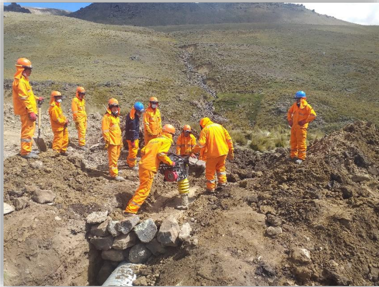
Imagen 07: en la imagen se observa como el personal está en espera de que el operador use correctamente la compactadora y termine de compactar el relleno para poder realizar las demás actividades, el cual genera una deficiencia en la productividad de mano de obra por tener una cuadrilla de gran proporción.
