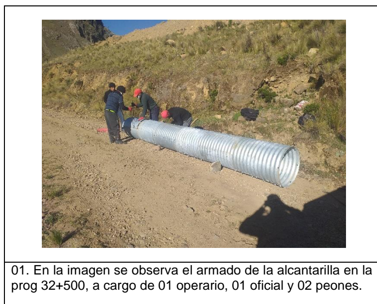
Figura 4.52: cuadrilla real mejorada – armado y colocado de TMC
