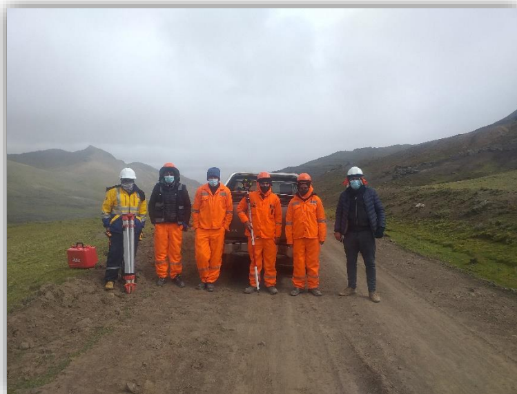
Imagen 02: en la imagen se observa la cuadrilla de replanteo, trazo y nivelación conformado por 02 operarios (topógrafo y conductor), 01 oficial (ayudante del topógrafo) y 02 peones. Los cuales fueron evaluados por la herramienta carta balance.
