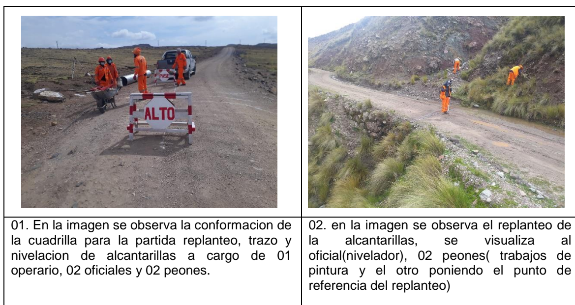
Figura 4.47: cuadrilla real mejorada – replanteo y trazo
