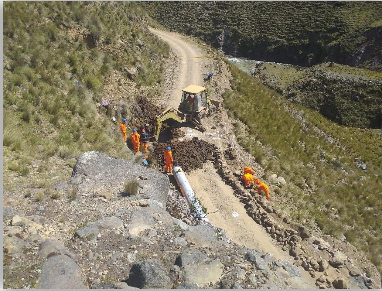
Imagen 05: en la imagen se observa el lugar estratégico para la visualización de las actividades hechas por los obreros en las partidas de excavación de estructura con maquinaria y reposición de muros de mampostería de piedra.
