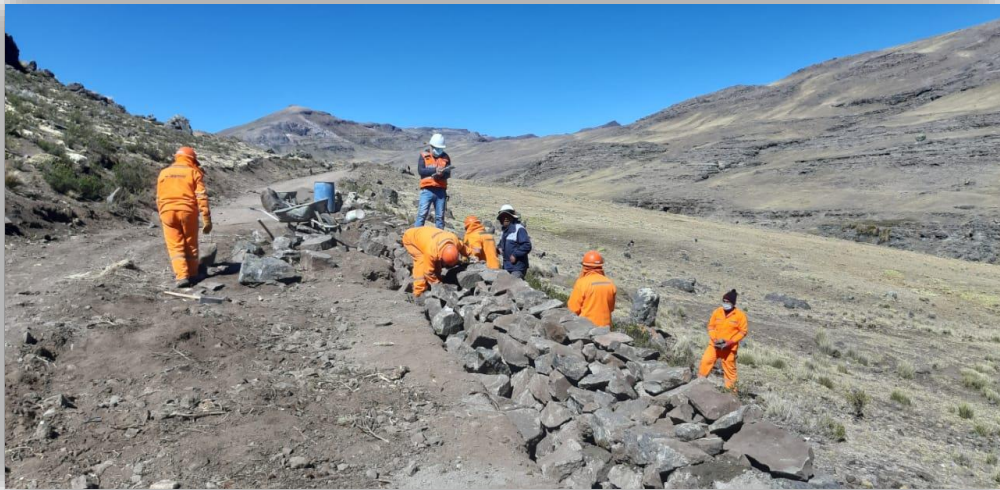
Imagen 10: en la imagen se observa la cuadrilla real balanceada de muros de mampostería de piedra que está conformado por 07 obreros, 01 operario, 01 oficial y 05 peones en el cual los trabajos no contributarios se redujeron y los trabajos productivos aumentaron y así mejoro la productividad de mano de obra.
