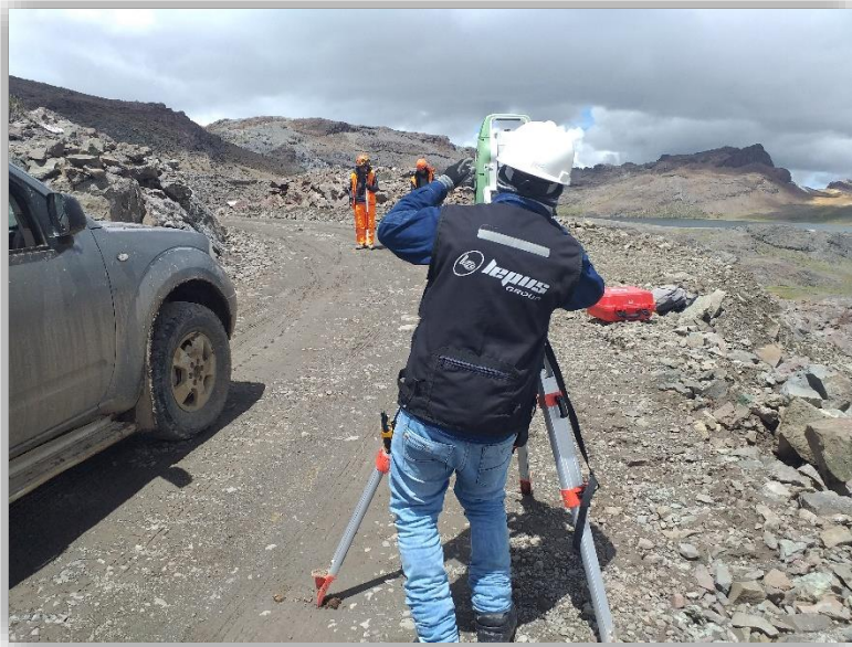
Imagen 03: en la imagen se observa los trabajos de replanteo topográfico el cual está a cargo del topógrafo, el ayudante y el peón quien se encarga de marcar el punto eje y la referencia para su trazo posterior.
