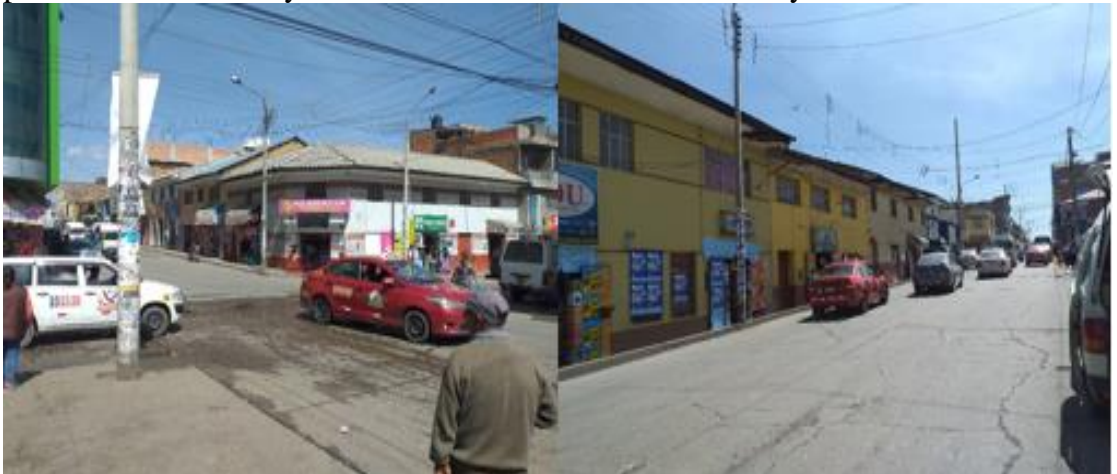
Vista de la intersección V entre el Jr. Antonio Lobato y el Jr. Santa Isabel, la cual no presenta señalización y el tramo V entre el Jr. Antonio Lobato y el Jr. Sebastián Lorente.
