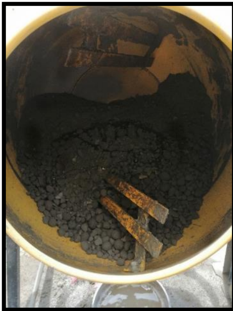
Fotografía 50 y Fotografía 51: Elaboración de concreto antideslave con aditivos – materiales en el trompo para su mezclado.
