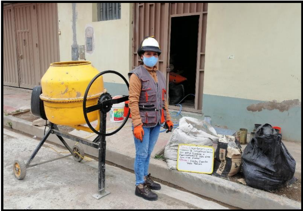
Fotografía 31: Materiales listos para empezar con el mezclado de concreto antideslave patrón
