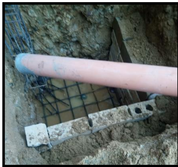
Fotografía 1, Fotografía 2 y Fotografía 3.: Zapatas aisladas en vivienda en el distrito de Azapampa - Huancayo
