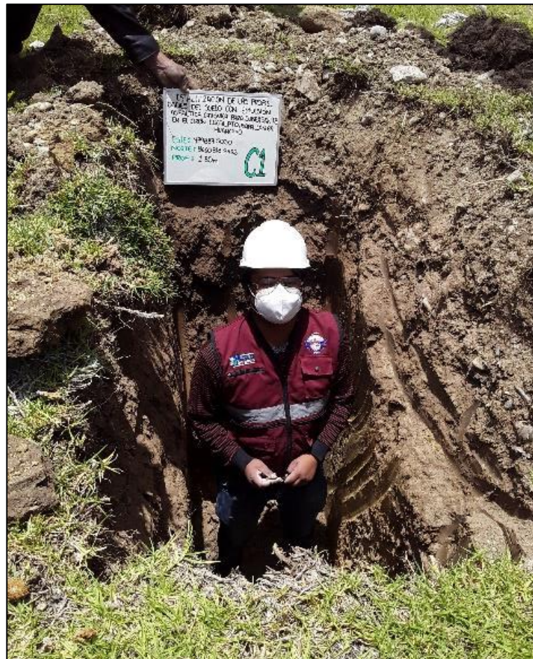
Fotografía 22. Vista de la calicata.
