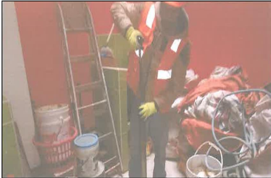
Imagen 5: Compactación de material de calicata.
