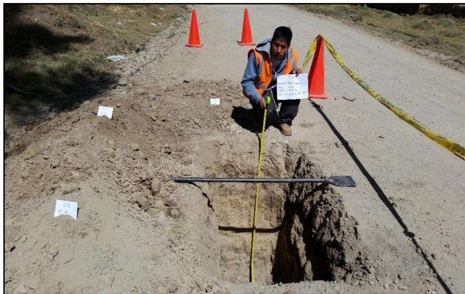
Imagen 12: Vista de la calicata C-3
