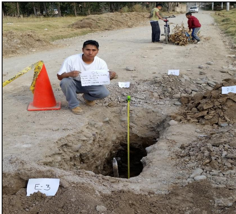
Imagen 10: Vista de la calicata C-1.
