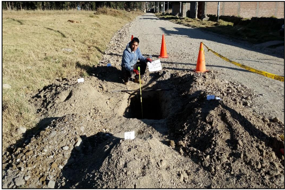
Imagen 11: Vista de la calicata C-2.
