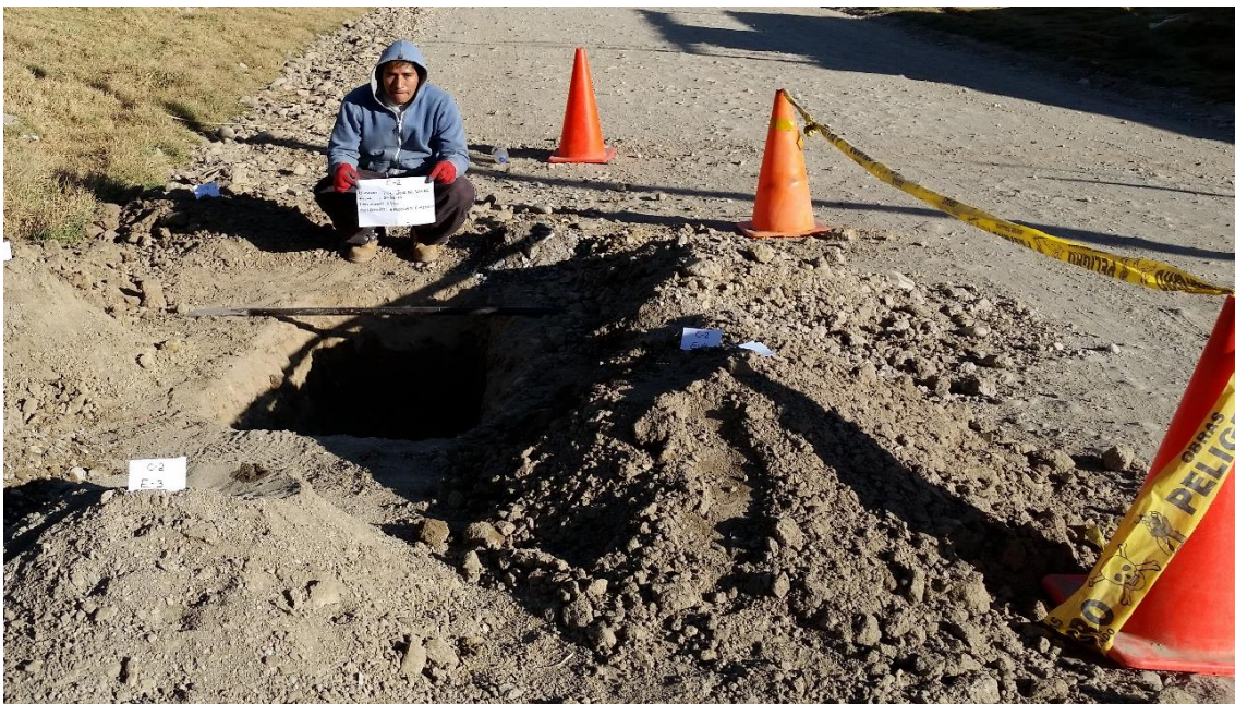
Registro de Excavación calicata 2
