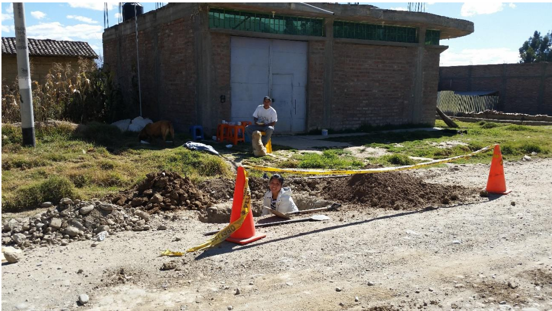
Registro de Excavación calicata 1
