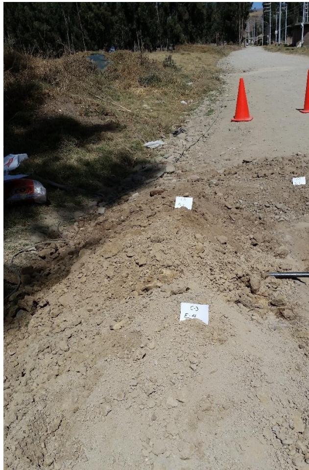
Registro de Excavación calicata 3
