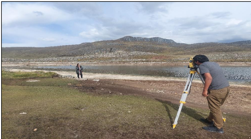
FOTO N° 07: CAMBIO DE PUNTO DE ESTACIÓN PARA FINALIZACIÓN DEL LEVANTAMIENTO TOPOGRAFICO.
