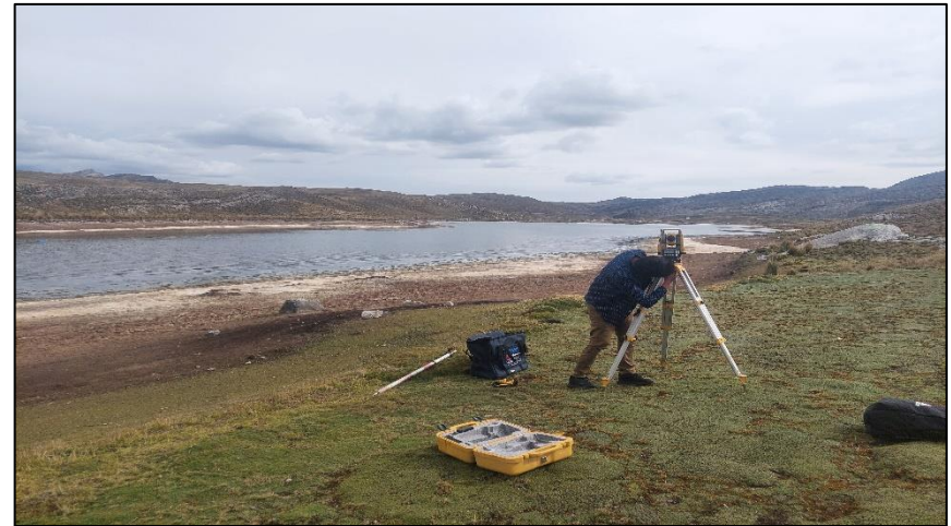
FOTO N° 02: INSTALACION DEL EQUIPO TOPOGRAFICO.
