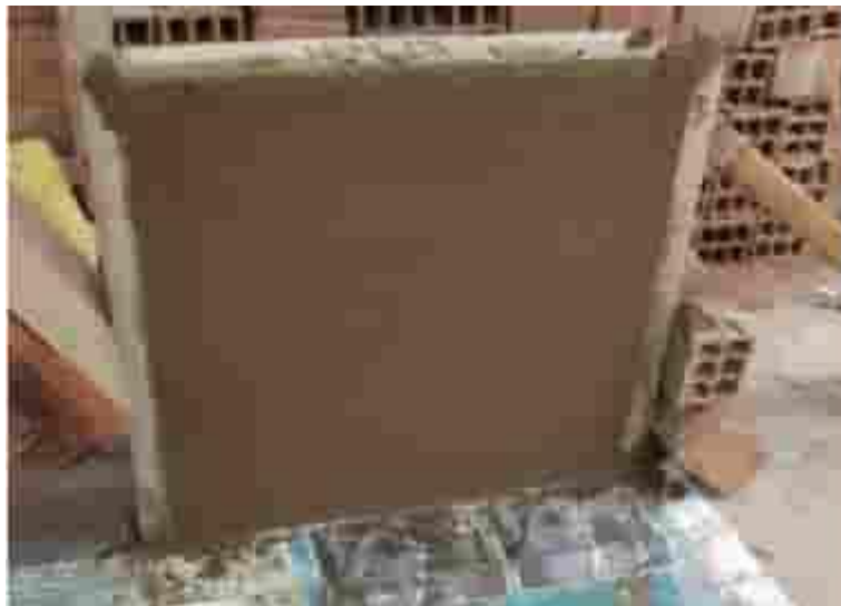
Figura 250 Presentación de muro tarrajado
