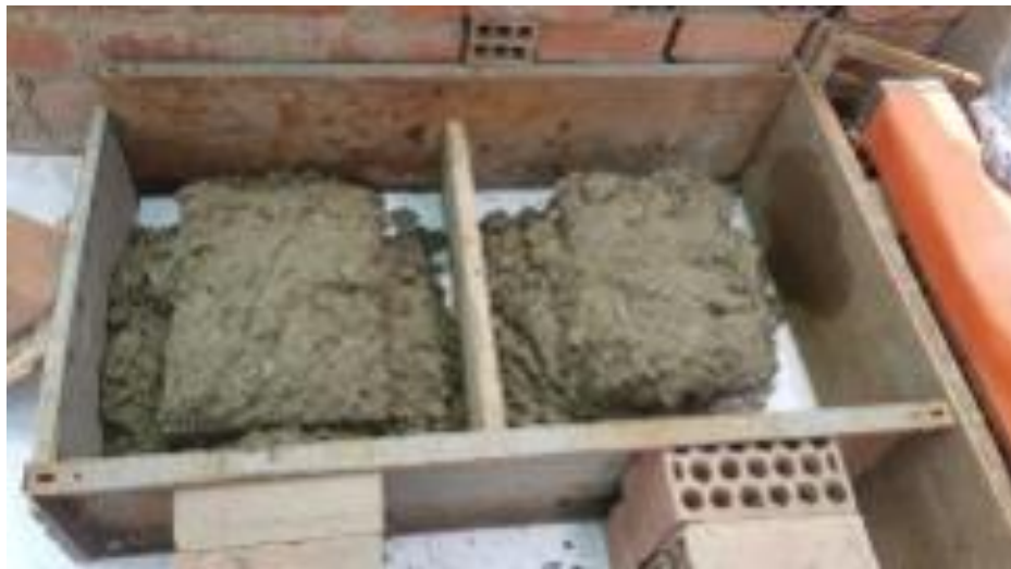
Figura 183. Vaciado de espécimen de losa aligerada con eco bloque.
