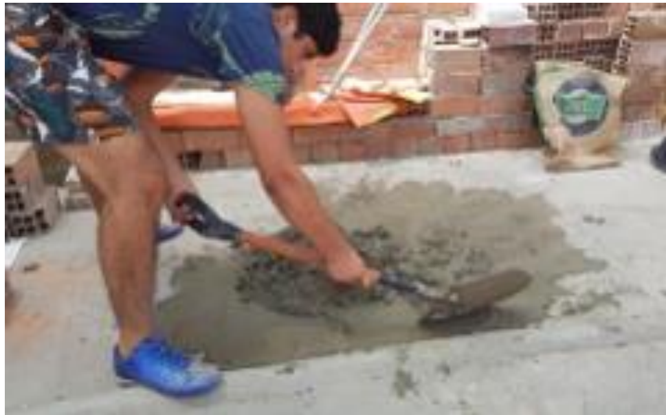
Figura 178. Batido de Mezcla para vaciar espécimen de losa aligerada.
