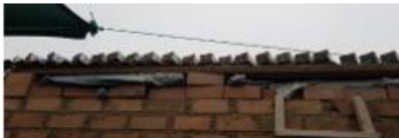
Figura 148. Secado de ladrillos a la intemperie en techo.
