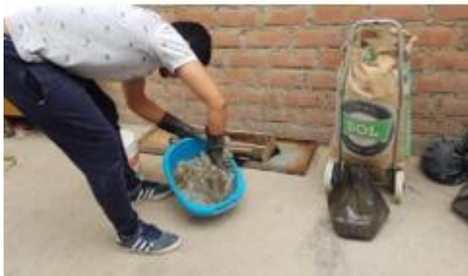
Figura 164. Preparación de la mezcla para el sobrecimiento.
