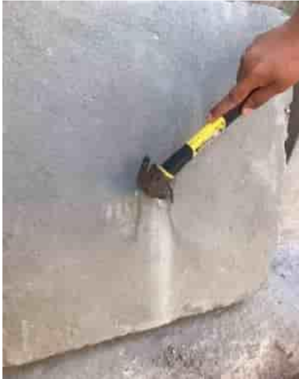
Figura 252. Golpeamos el tarrajeo para verificar la adherencia del tarrajeo en los eco ladrillos
