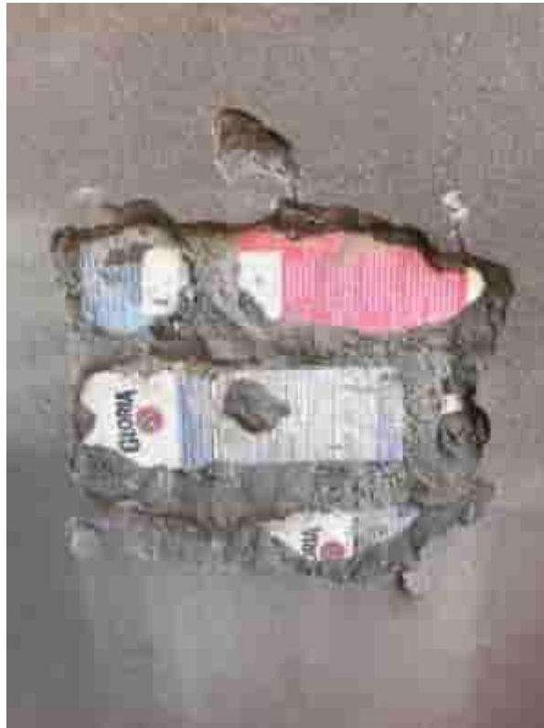
Figura 254. Desgaste de tarrajeo hasta llegar a los eco ladrillos
