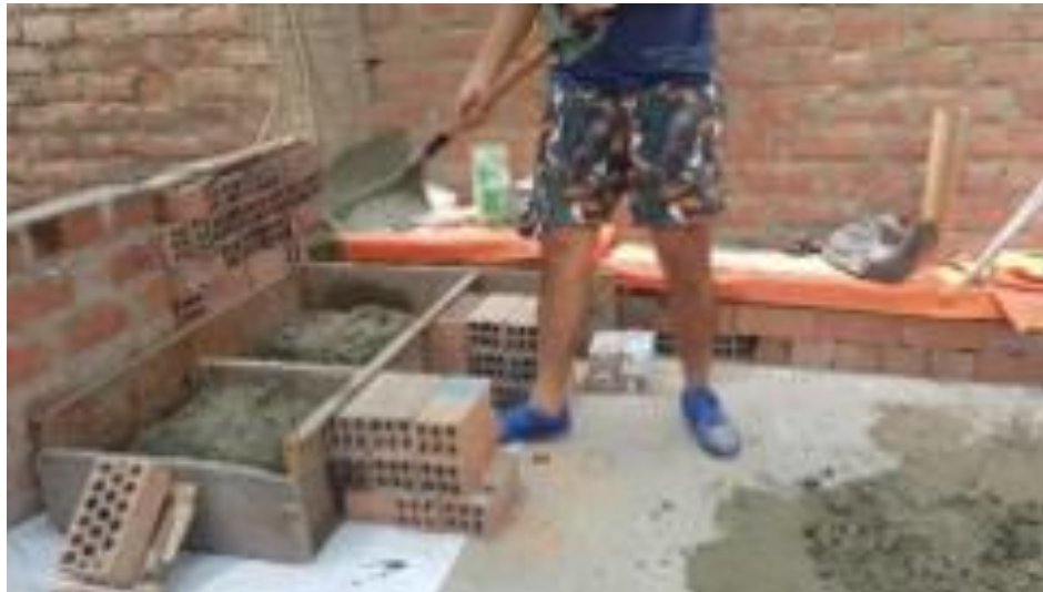
Figura 179. Vaciado de espécimen de losa aligerada.
