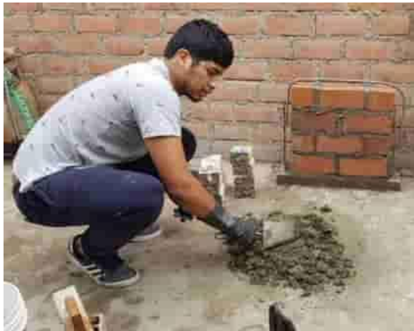
Figura 239. Preparación de mortero del tipo no portante.
