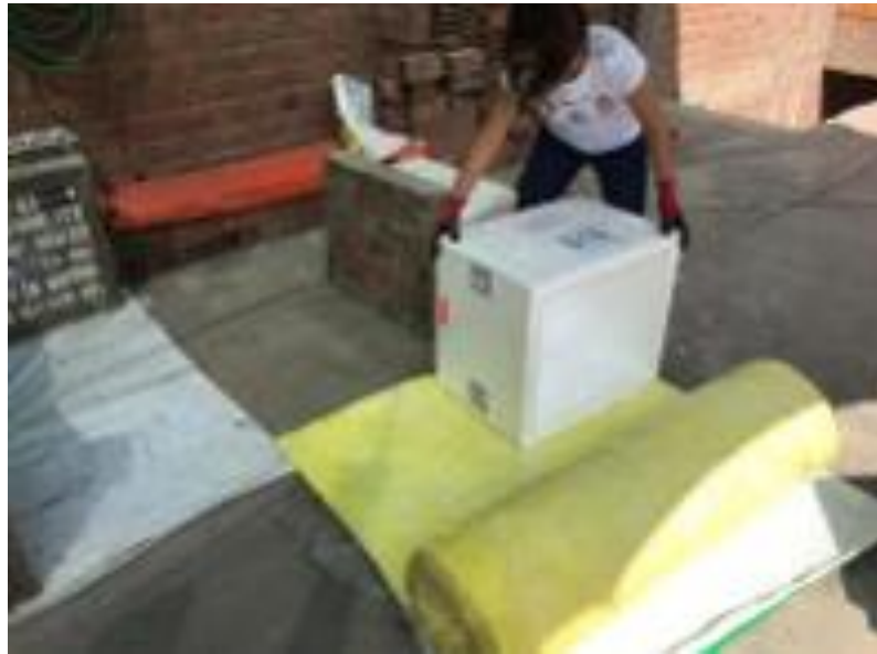
Figura 186. Forrado de caja con Lana de Vidrio.
