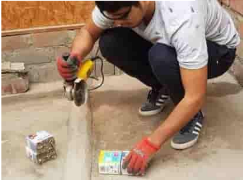
Figura 240. Corte de eco ladrillo con amoladora.
