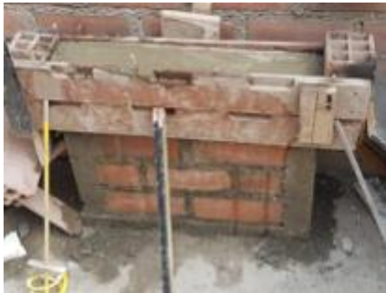
Figura 168. Vaciado de confinamiento de murete.
