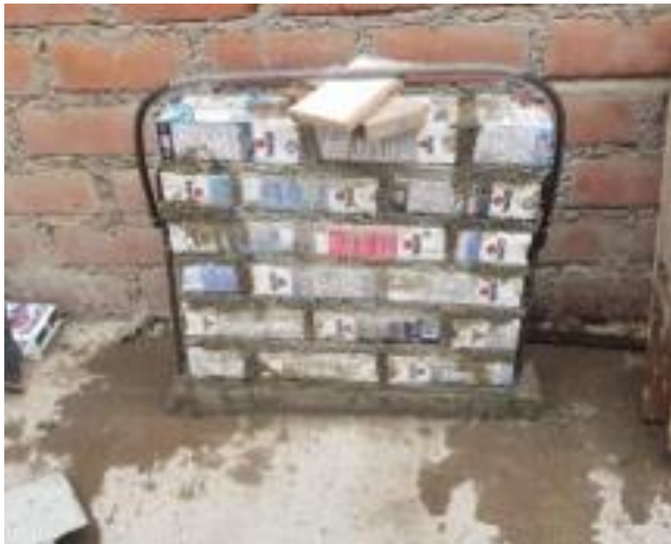
Figura 171. Eco murete listo para confinamiento.
