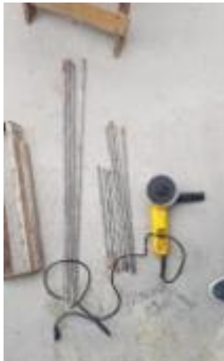
Figura 162. Habilitación de acero para el refuerzo del confinamiento.
