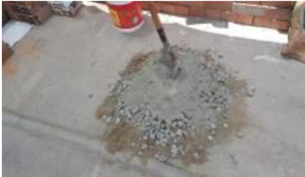
Figura 177. Mezcla para vaciado de espécimen de losa aligerada.
