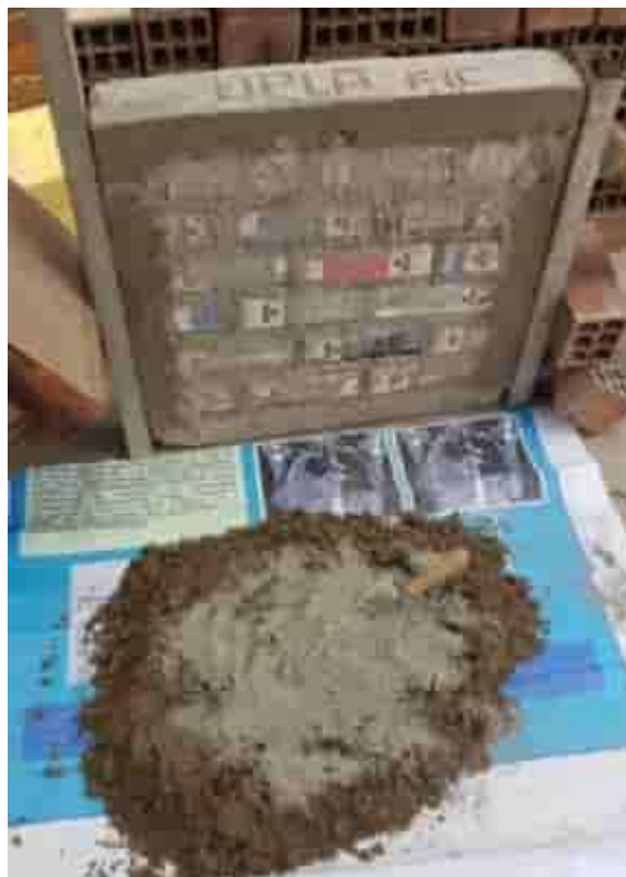
Figura 246. Preparación de mezcla para tarrajeo.
