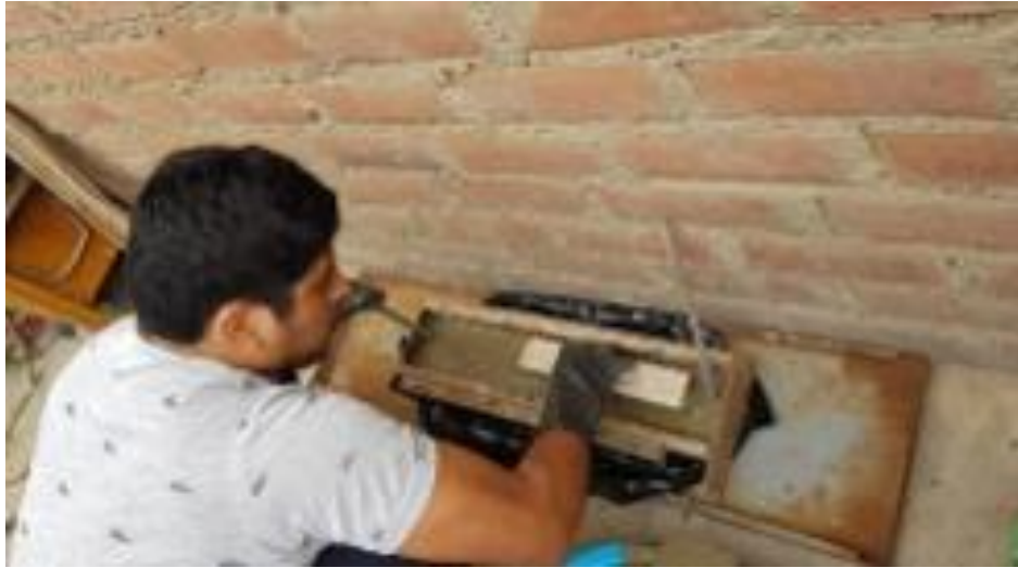
Figura 165. Vaciado del sobrecimiento.
