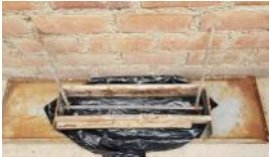
Figura 163. Encofrado y refuerzos listos para el vaciado.
