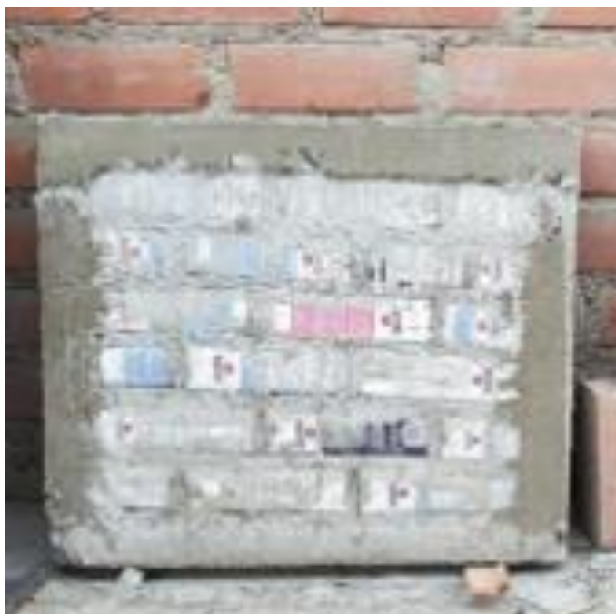
Figura 174. Eco muro desencofrado.
