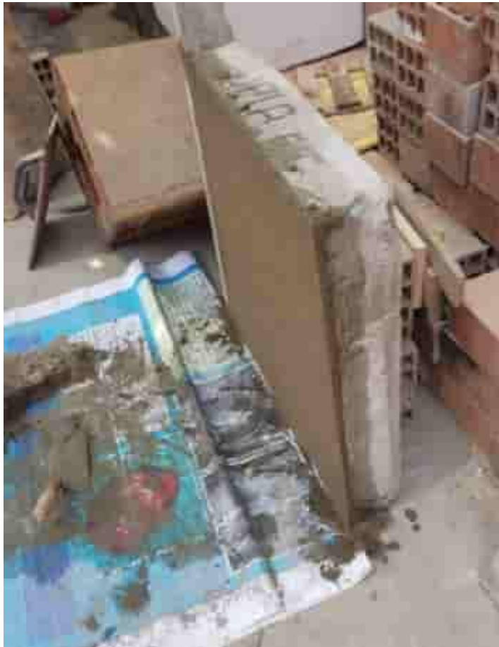
Figura 251. Canto de eco muro tarrajado y perfilado.
