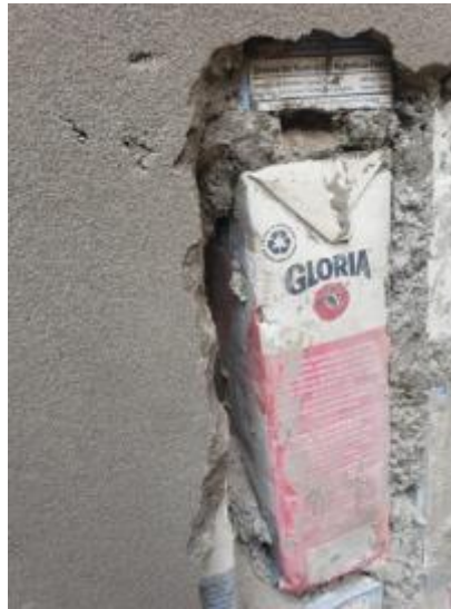
Figura 255. Prueba de desprendimiento de eco ladrillo con golpes.
