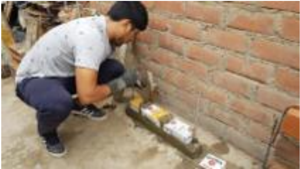
Figura 170. Asentado de eco ladrillos.
