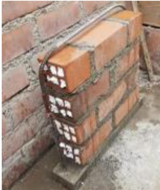
Figura 167. Murete listo para confinar.
