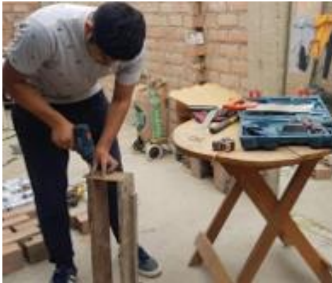
Figura 161. Construcción del encofrado para el sobrecimiento.
