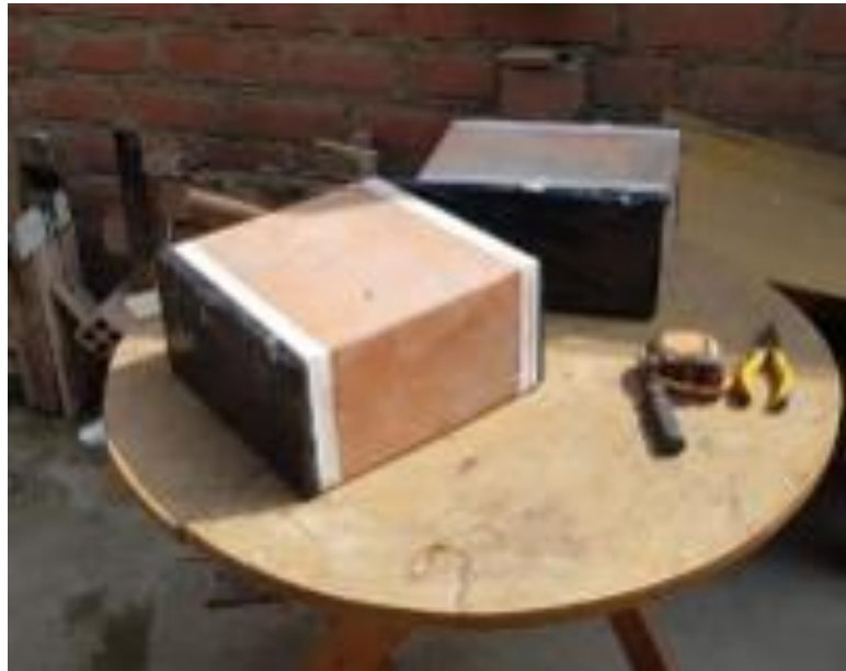
Figura 175. Forrado de alveolos de ladrillos que van en inicio y final de filas.
