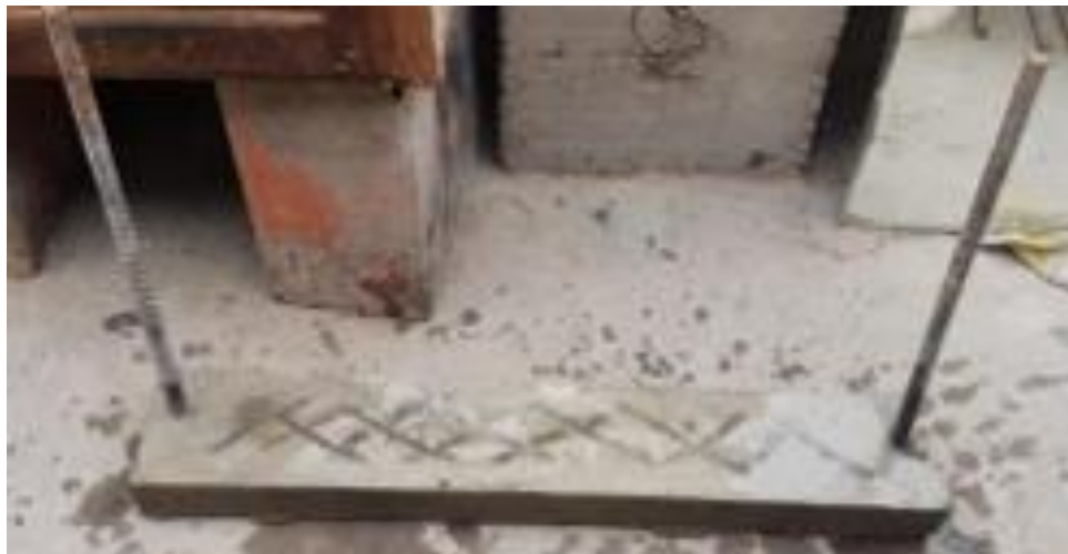
Figura 166. Desencofrado del sobrecimiento.
