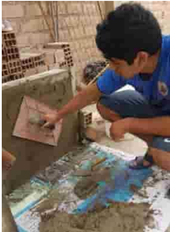
Figura 249. Paleteo para identificar puntos a llenar.
