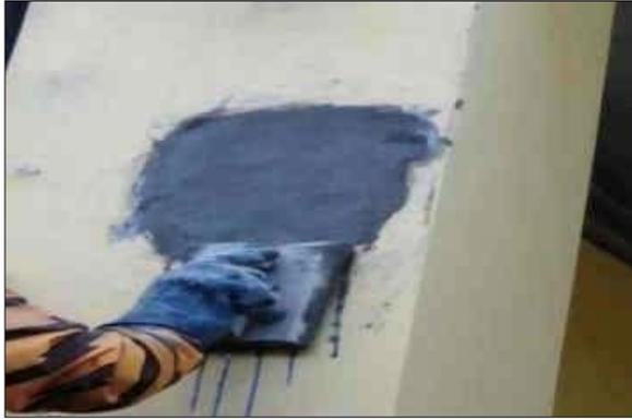
se representa la colocación de la mezcla y nivelado con plancha de mano hasta que sea uniforme con la mezcla antigua
