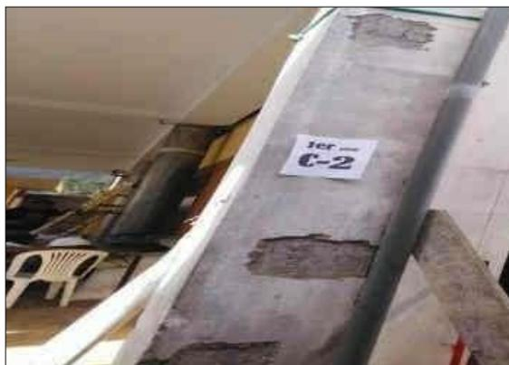
columna esquinada C-2 se observa las tres 3 ubicaciones de 25x25 cm sin revestimiento para empezar con el ensayo
