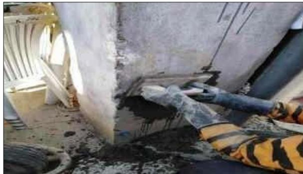
colocación de mezcla al nivel del concreto endurecido despues de hechar el pegamento epoxico
