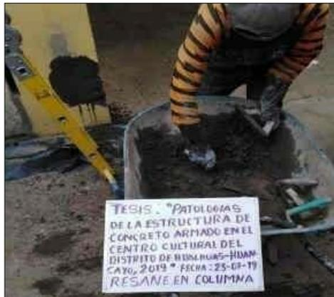
preparado de mezcla de arena fina mas cemento portland seco, luego se agrega el agua para que la mezacla sea homogneo para la colocacion de la mezcla
