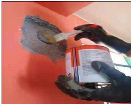
esparcido de pegamento epoxico para adheriri concreto nuevo a concreto antiguo una vez terminado del ensayo de esclerometria, para luego poner el revestimiento.
