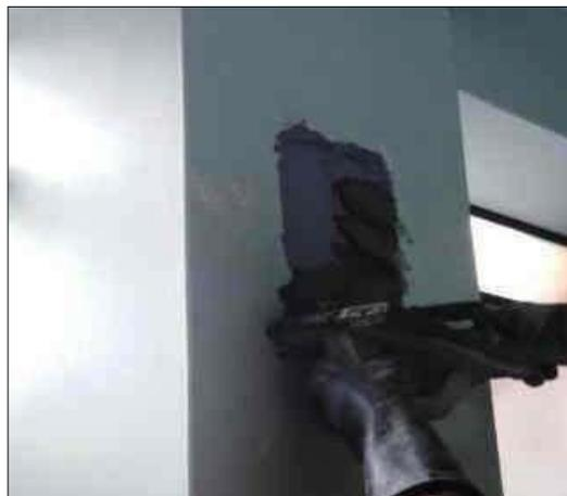
colocación de mezcla despues del pegamento epóxico
