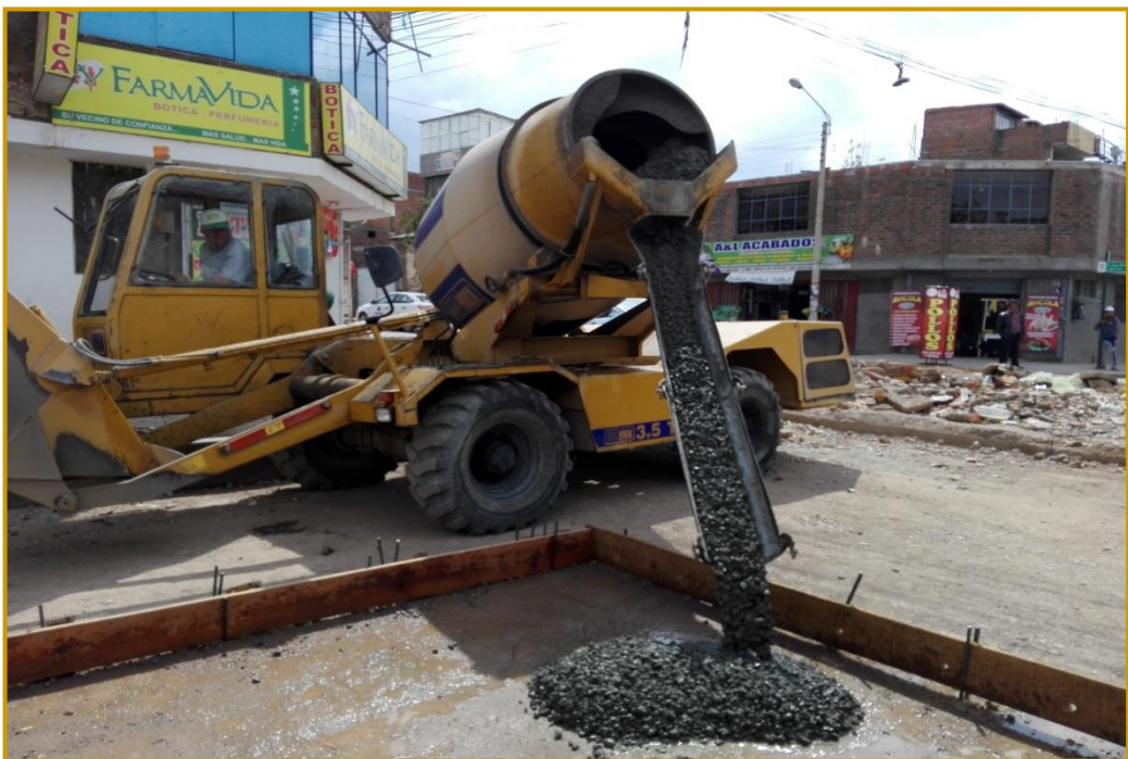
Trabajos de vaciado de concreto en los paños de la losa del pavimento, en la Av. Osvaldo Barreto y Av. Jorge Chávez
