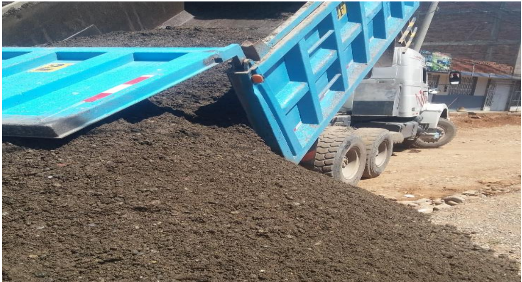
Descarga de material de préstamo para conformación de base en el Jr. Oswaldo Barreto
