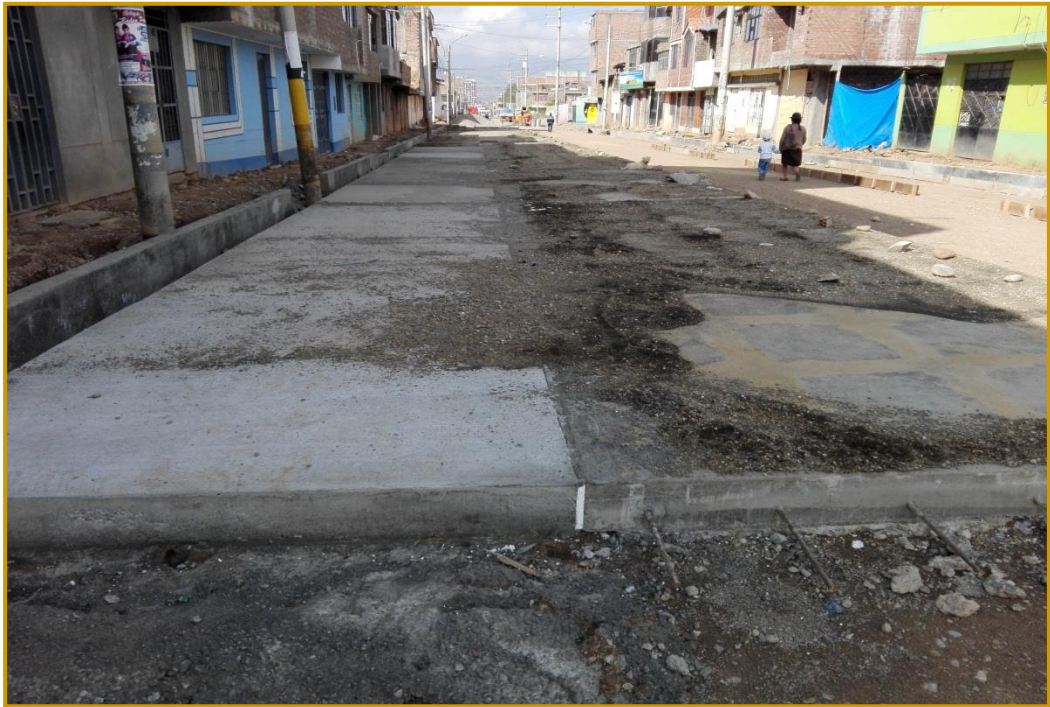
Vista de paños de la losa del pavimento terminado, en la Av. San Isidro (De la Inca Ripac a la Av. Osvaldo Barreto)
