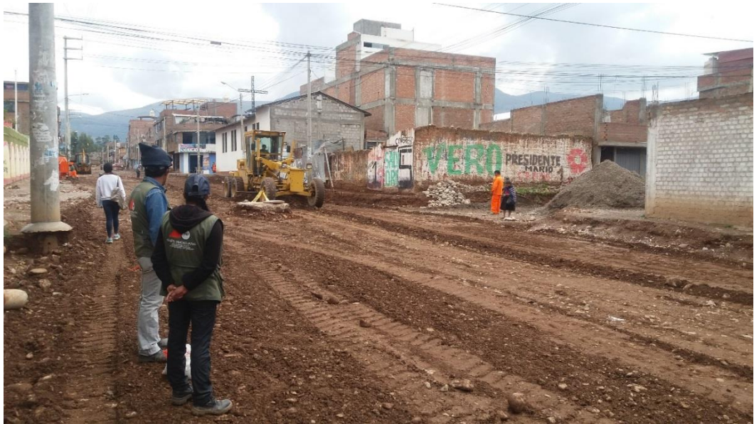
Descarificación de la Sub rasante en la Av. San Isidro (frontis del Polideportivo Juan Parra del Riego)
