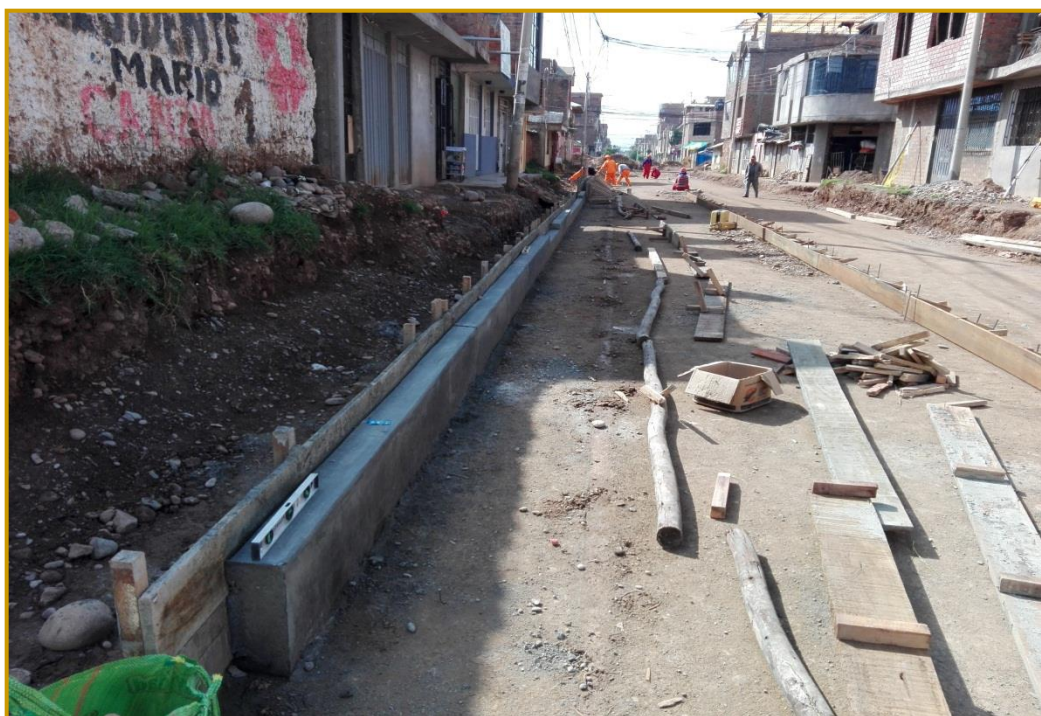
Vista de sardinel terminado y encofrado para los paños de la losa del pavimento, (Del. Jr. Huayna Capac a Av. Jorge Chávez)
