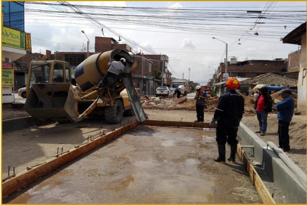
Trabajos de encofrados y desencofrados para los paños de la losa del pavimento, en la Av. Osvaldo Barreto y Av. Jorge Chávez
