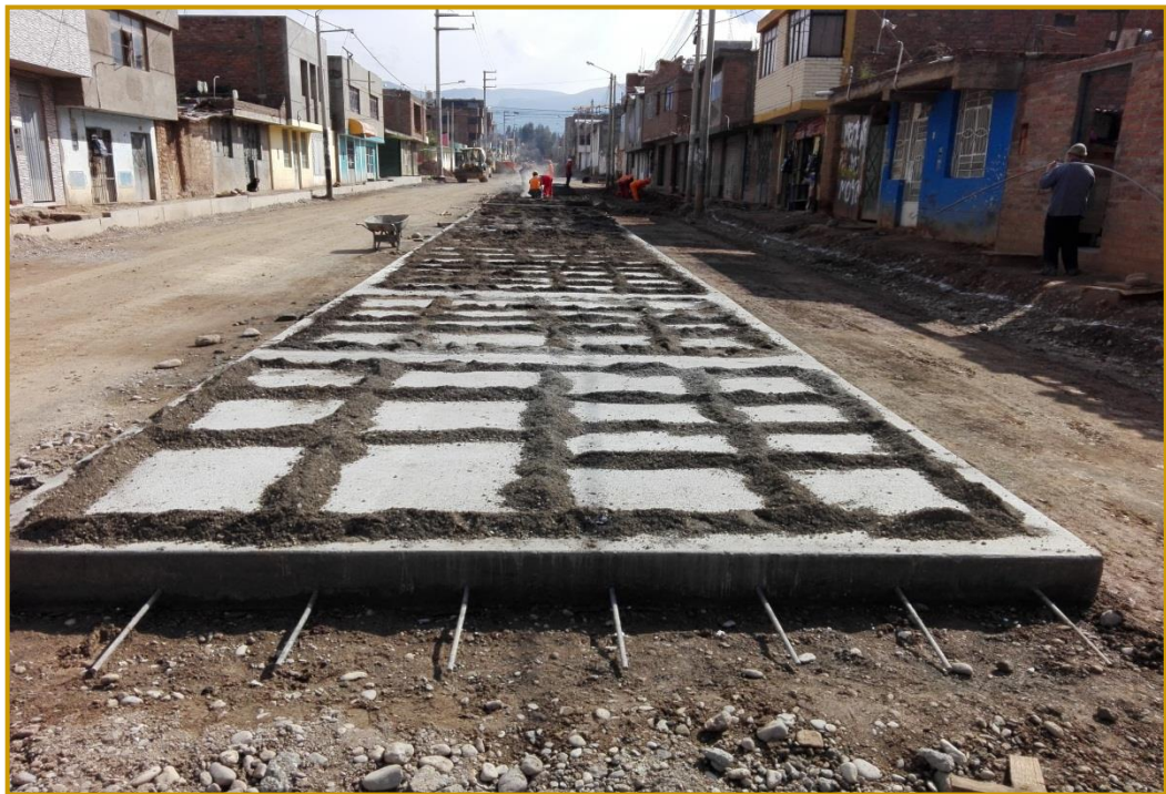
Vista de paños de la losa del pavimento terminado, en la Av. San Isidro (De la Av. FF.CC a la Av. Jr. Huayna Capac)
