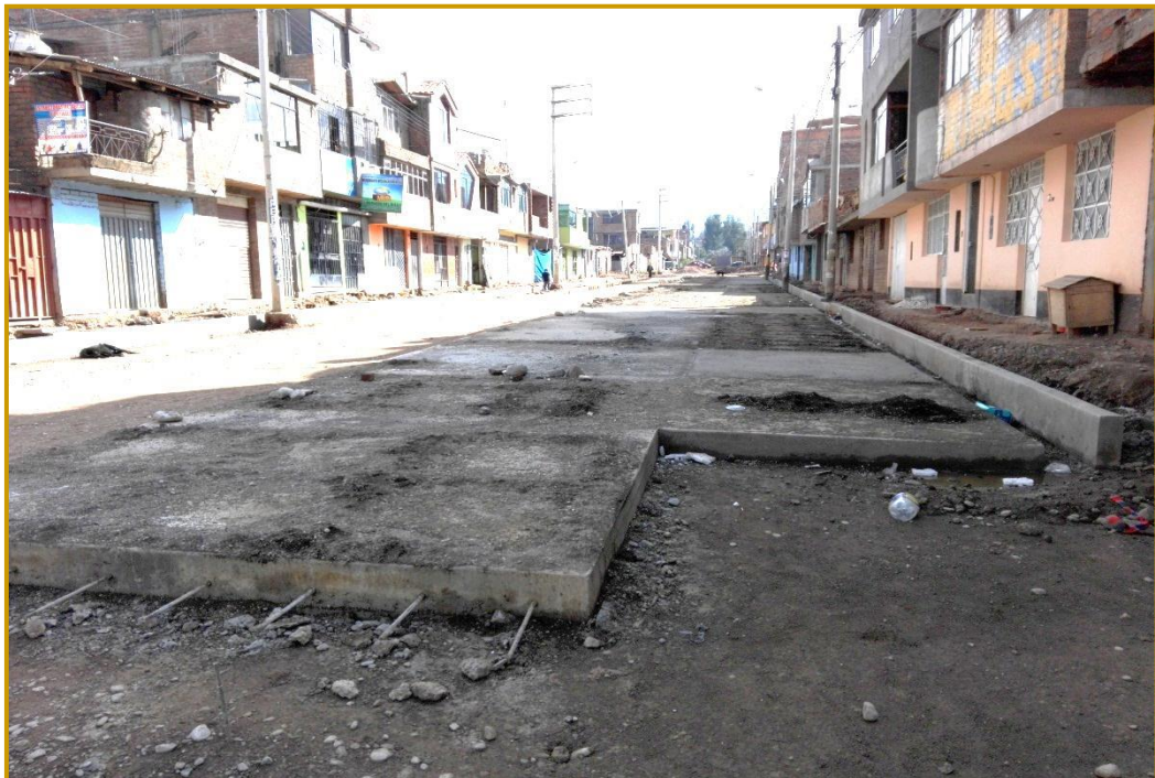
Vista de paños de la losa del pavimento terminado, en la Av. San Isidro (De la Av. Osvaldo Barreto a la Av. Inca Ripac)
