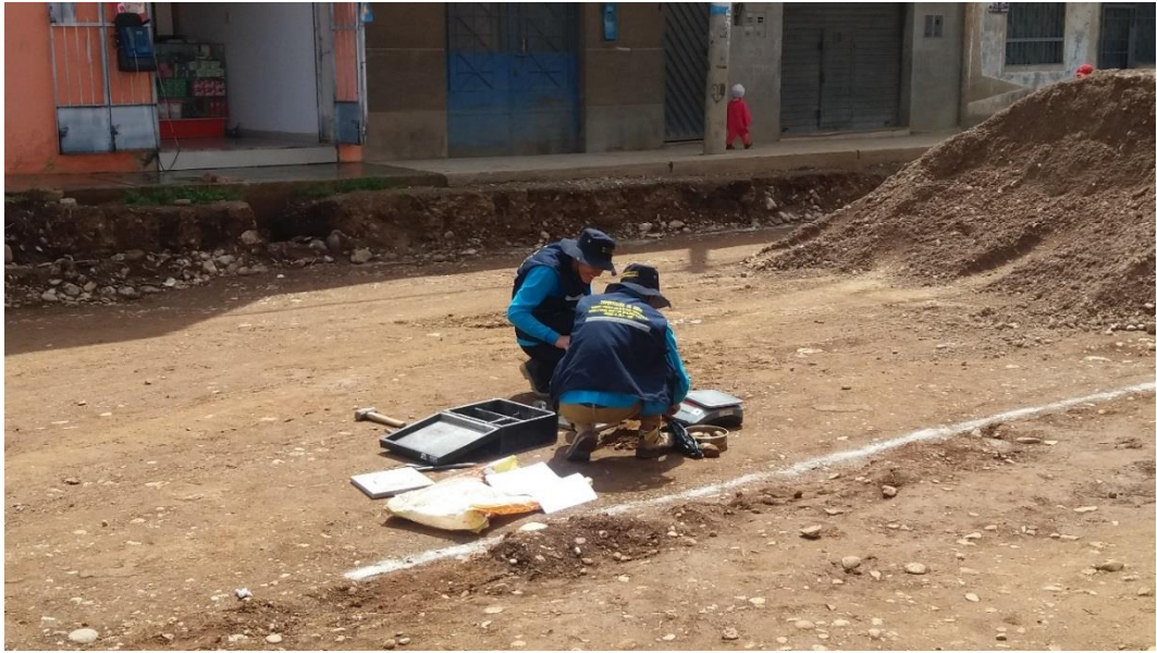
El personal técnico saca las pruebas de compactación en la Sub rasante de la Av. San Isidro (la empresa es Centauro SAC.)
