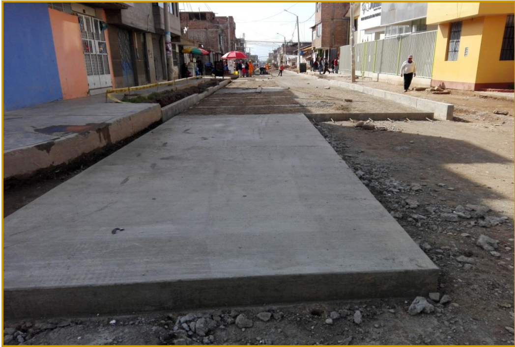
Vista de paños de la losa del pavimento terminado, en la Av. Osvaldo Barreto (De la Av. Osvaldo Barreto a la Av. Jorge Chávez)
