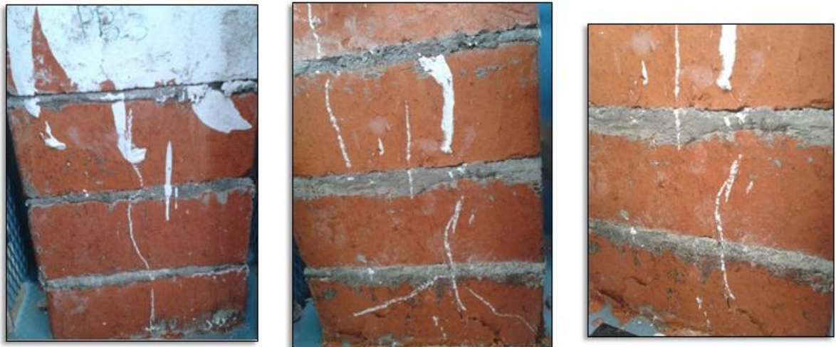
Figura 5. Pilas D, E y F con el curador membranil
