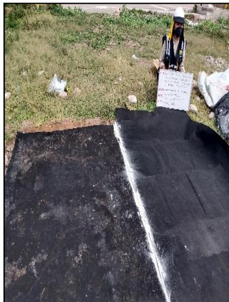
**Fotografía N° 3:** Imprimación con la emulsión catiónica CSS-1H de rotura lenta convencional. En el lado izquierdo.
