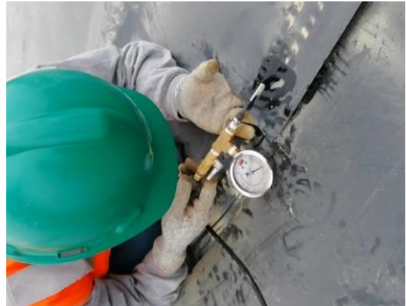
Foto 6: Verificación de la prueba de presión de aire en laguna facultativa
