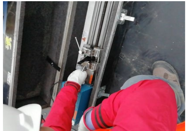
Foto 12: Ensayo destructivo en soldadura por fusión
