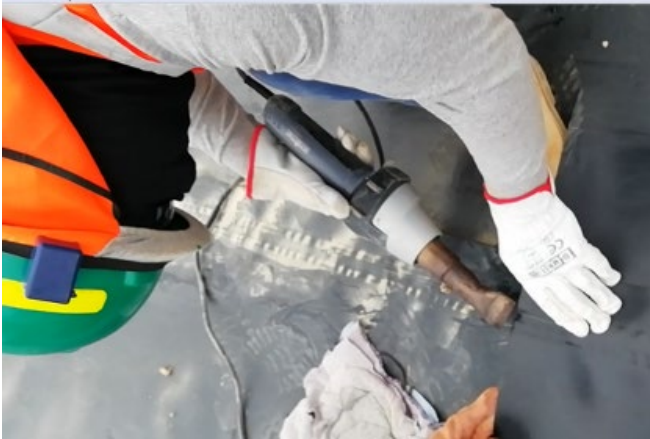
Foto 5: Verificación de la prueba de presión de aire en laguna facultativa
