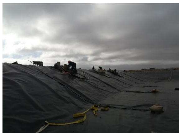
Foto 2: Instalación de geomembrana
