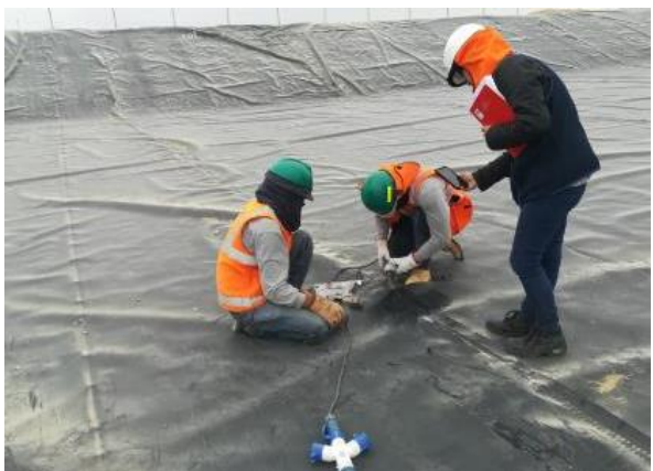
Foto 3: Verificación de la prueba de presión de aire en laguna anaerobia
