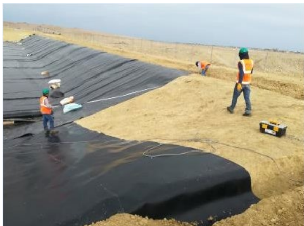
Foto 1: Instalación de geomembrana
