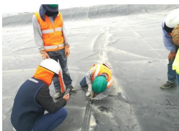
Foto 4: Verificación de la prueba de presión de aire en laguna anaerobia
