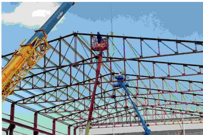
Figura 4. Estructura metálica triangulada.
