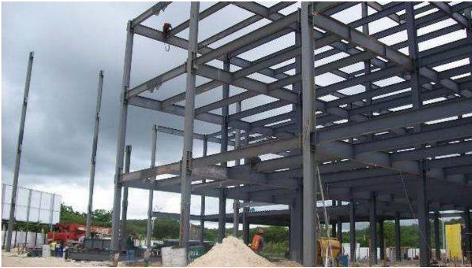
Figura 3. Estructura metálica entramada.
