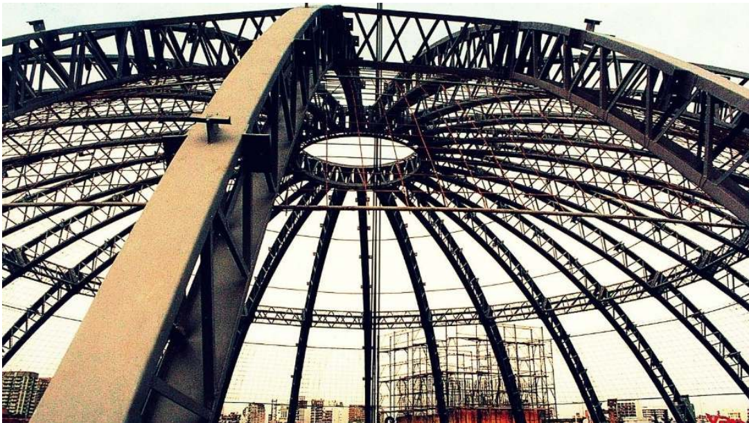
Figura 2. Estructura metálica abovedada.
