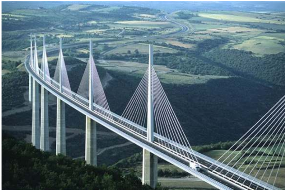
Figura 5. Estructura metálica colgante.
