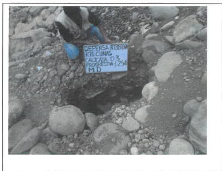
FOTO. 08.- EXCAVACION DE LA CALICATA. C-3, PROG 1 + 250 . INFLUENCIA DE LOS MUROS DE GAVIONES O MUROS DE CONCRETO EN LAS DEFENSAS RIBEREÑAS DEL RIO CUNAS CHUPACA, 2020
