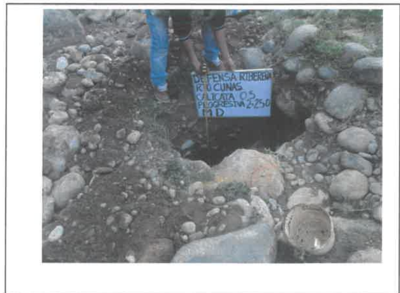
FOTO. 16.-PROFUNDIDAD DE EXCAVACION C- 5 PROG, 2+250, INFLUENCIA DE LOS MUROS DE GAVIONES O MUROS DE CONCRETO EN LAS DEFENSAS RIBEREÑAS DEL RIO CUNAS CHUPACA, 2020
