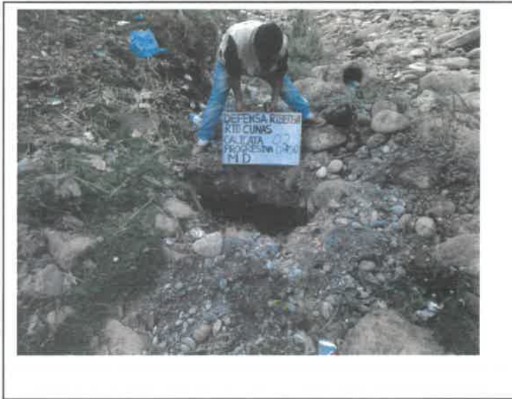
FOTO. 05- EXCAVACION DE CALICATA. C- 2 PROG, 0+ 750 . INFLUENCIA DE LOS MUROS DE GAVIONES O MUROS DE CONCRETO EN LAS DEFENSAS RIBEREÑAS DEL RIO CUNAS CHUPACA, 2020
