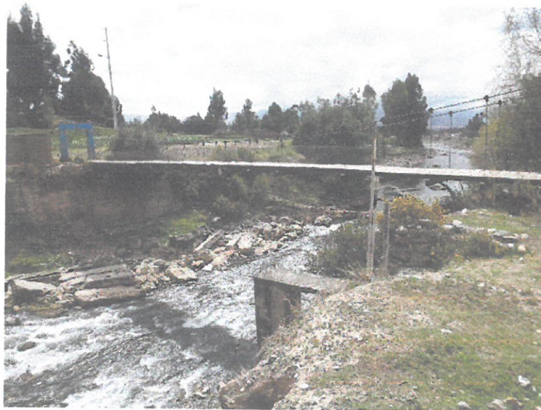
Figura 2-2: Puente Peatonal Muqui e inicio de tramo para muros engavionados
