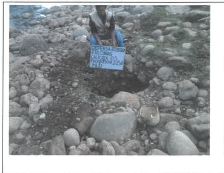
FOTO. 14.-EXCAVACION DE LA CALICATA. C-5 – PROG, 2 + 250 . INFLUENCIA DE LOS MUROS DE GAVIONES O MUROS DE CONCRETO EN LAS DEFENSAS RIBEREÑAS DEL RIO CUNAS CHUPACA, 2020
