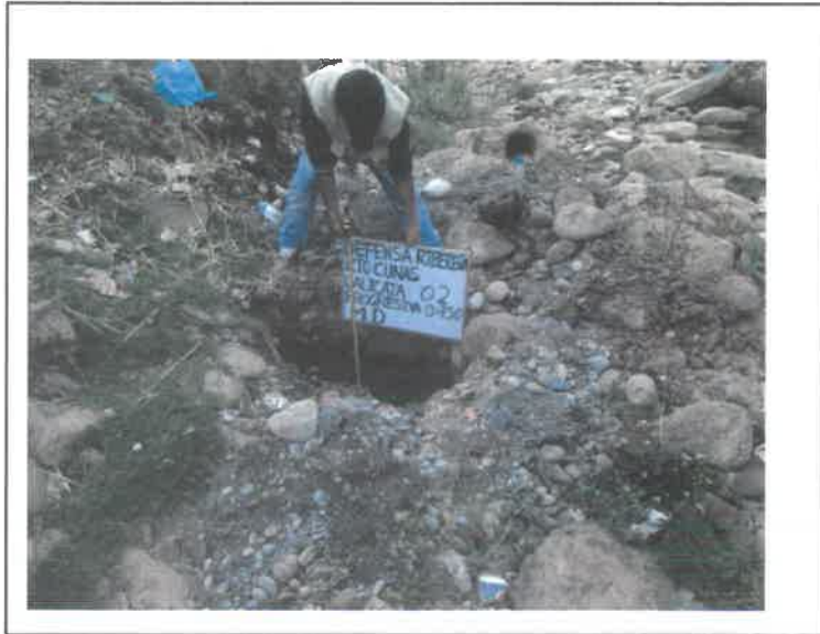
FOTO. 07.- PROFUNDIDAD DE EXCAVACION, C-2, PROG 0 +750 . INFLUENCIA DE LOS MUROS DE GAVIONES O MUROS DE CONCRETO EN LAS DEFENSAS RIBEREÑAS DEL RIO CUNAS CHUPACA, 2020
