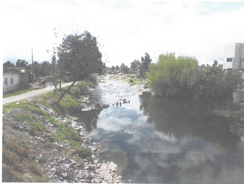
Figura 2-3: Sección aguas abajo del puente Muqui, se puede observar viviendas aledañas al cauce del río que sufren inundaciones en épocas de avenidas
