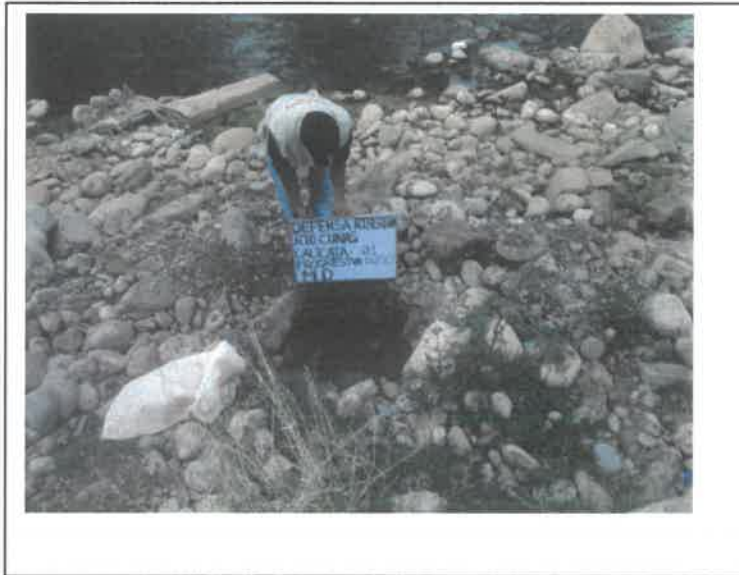
FOTO. 01.- EXCAVACION DE CALICATA. C-1. PROG, O+ 250. INFLUENCIA DE LOS MUROS DE GAVIONES O MUROS DE CONCRETO EN LAS DEFENSAS RIBEREÑAS DEL RIO CUNAS CHUPACA, 2020
