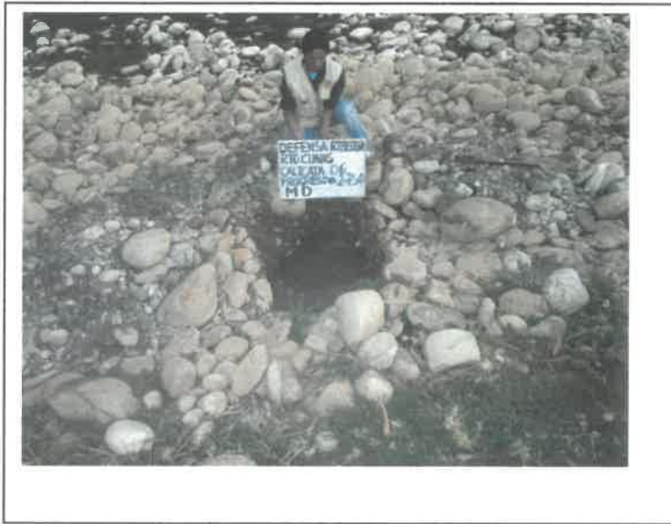
" FOTO. 17.-EXCAVACION DE LA CALICATA C-6 – PROG, 2+750, . INFLUENCIA DE LOS MUROS DE GAVIONES O MUROS DE CONCRETO EN LAS DEFENSAS RIBEREÑAS DEL RIO CUNAS CHUPACA, 2020
