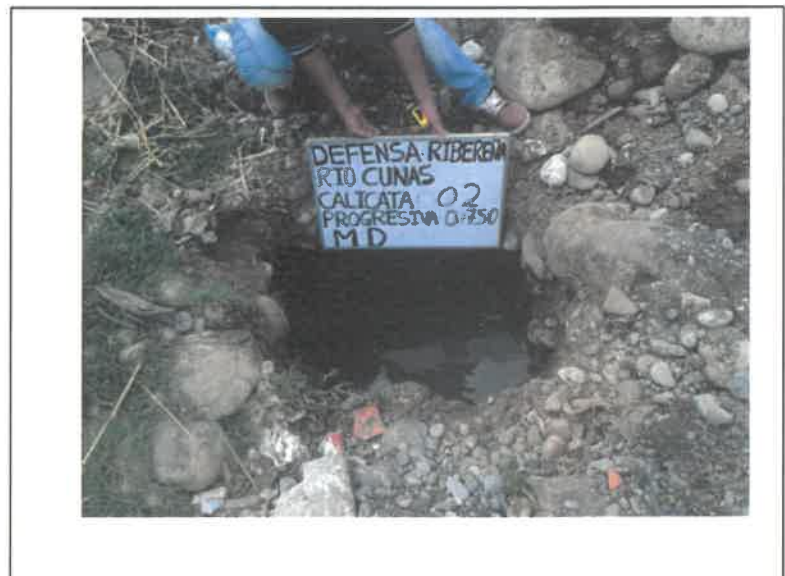
FOTO. 06.- PERFIL ESTRATIGRAFICO DE CALICATA. C-2 PROG, 0+ 750 . INFLUENCIA DE LOS MUROS DE GAVIONES O MUROS DE CONCRETO EN LAS DEFENSAS RIBEREÑAS DEL RIO CUNAS CHUPACA, 2020
