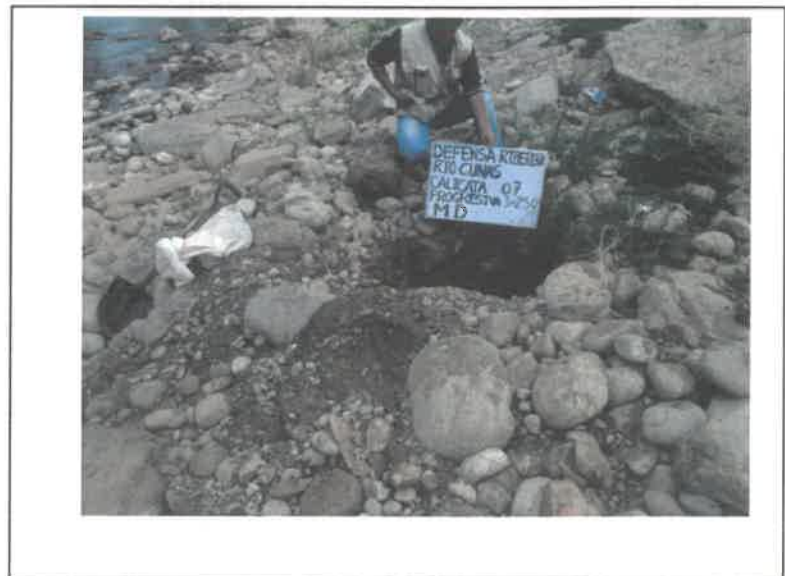
FOTO 20.-EXCAVACION DE CALICATA. C- 7, PROG, 3+250 . INFLUENCIA DE LOS MUROS DE GAVIONES O MUROS DE CONCRETO EN LAS DEFENSAS RIBEREÑAS DEL RIO CUNAS CHUPACA, 2020
