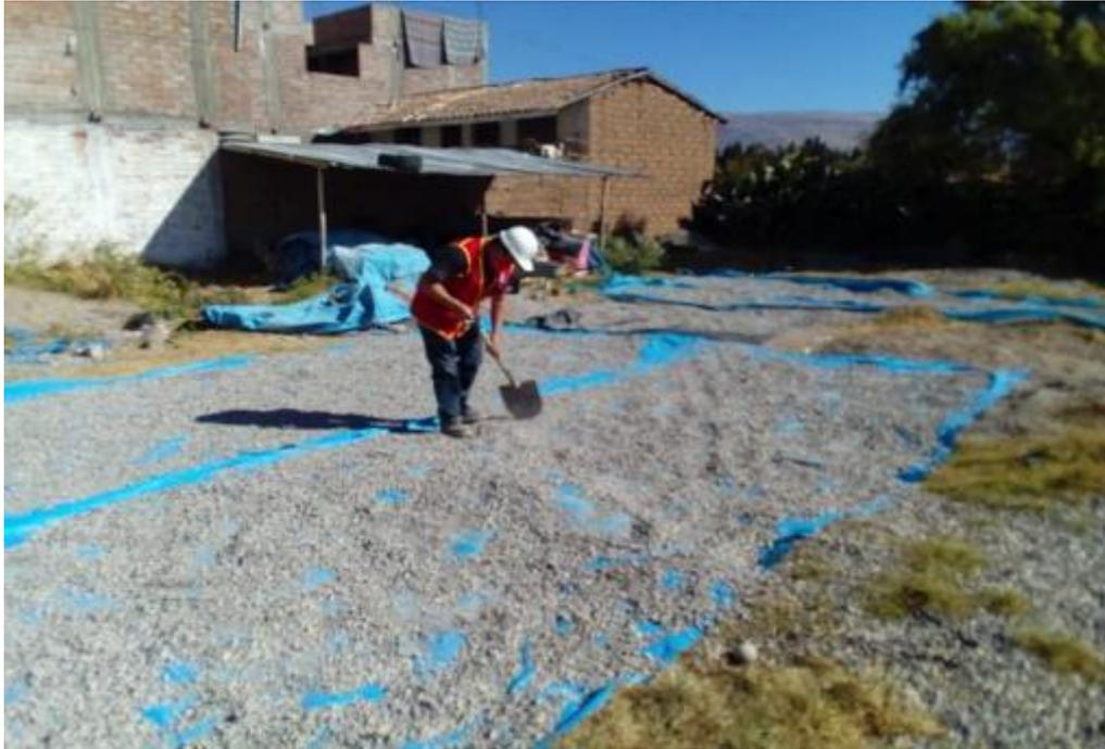
**Fotografía 01:** En la fotografía se ve el proceso de secado de los agregados a temperatura ambiente, ello se realizó con el fin uniformizar el contenido de humedad.
