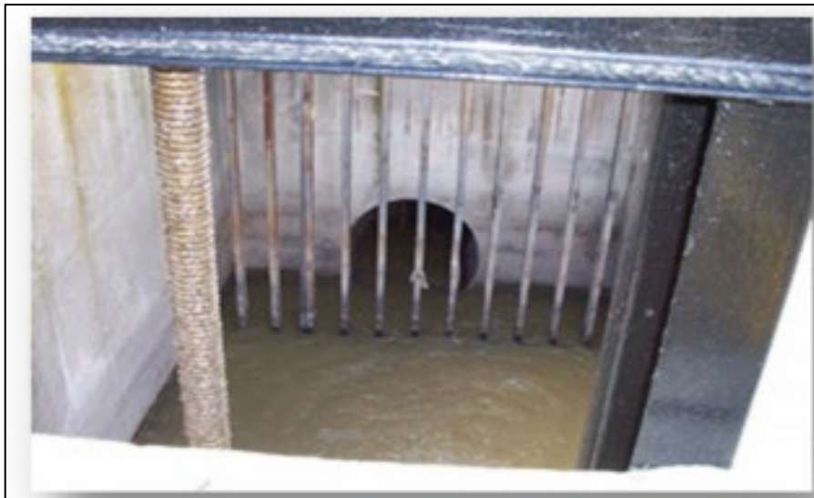
Figura N° 17: Sistema de rejas
