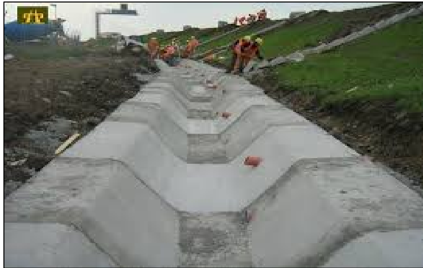
Figura N° 04: Canaleta o cuneta
