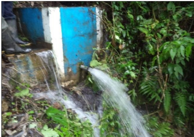
Imagen 1: Captación del manantial “balcon”
