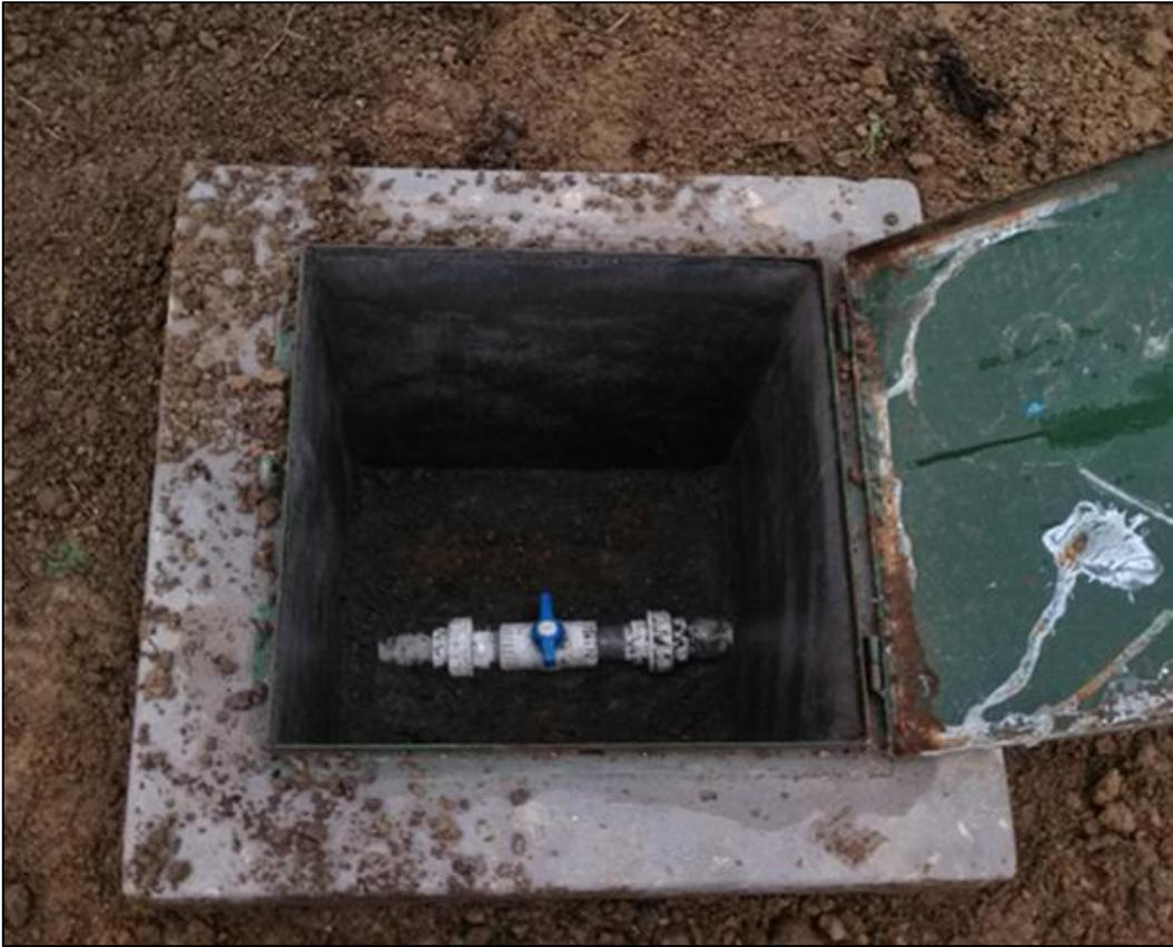
Fotografía 7: Construcción de válvula de control colocados según los planos en la red de distribución de agua potable.
