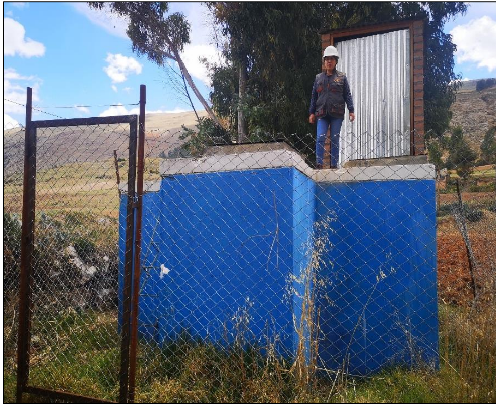
Fotografía 11: Mejoramiento de la captación el cual abastece a la población beneficiaria.
