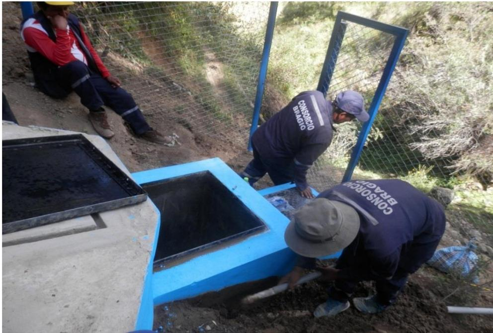
Fotografía N°10 Otra Verificación del cerco perimétrico de la captación en obras similares del proyecto
