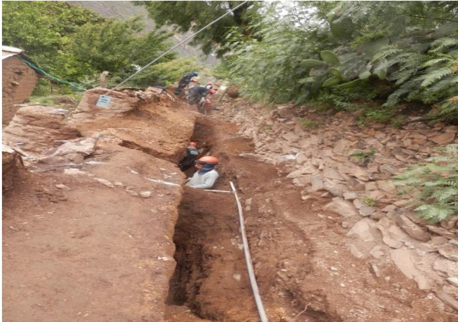
Fotografía N°9 Verificación de la excavación de zanjas manuales en la red de distribución en obras similares del proyecto
