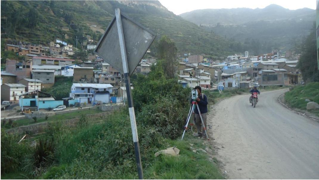
**Fotografía N°4 levantamiento topográfico de pendientes**
