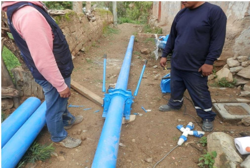
Fotografía N°11 trabajos de uniones con electrofusión en tubos HDPE verificaciones den obras similar al proyecto
