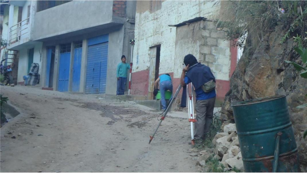
**Fotografía N°5 levantamiento topográfico de las conexiones domiciliarias**
