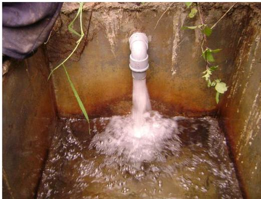
*Figura 29 Cámara rompe presión existente*
