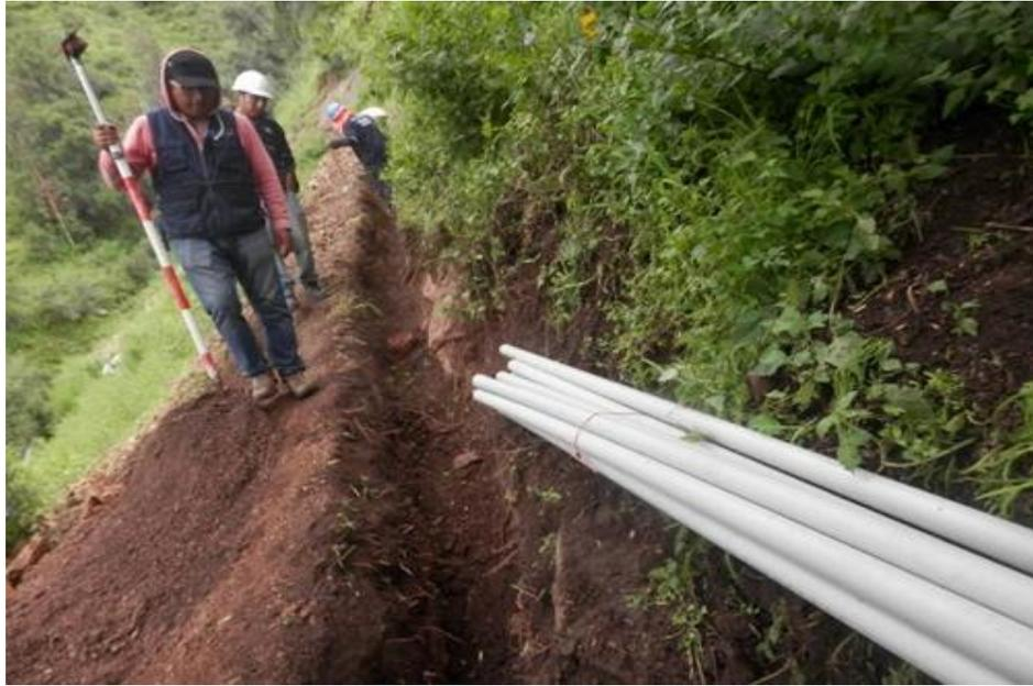
Fotografía N°8 Verificación del Canal de conducción en obras similares al proyecto
