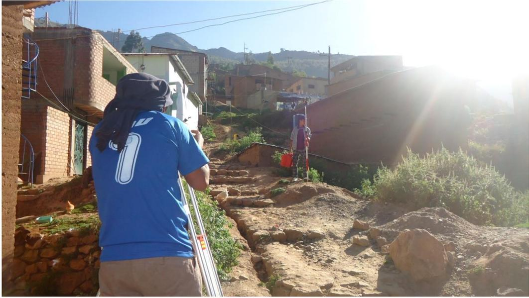
**Fotografía N°1 levantamiento topográfico**
