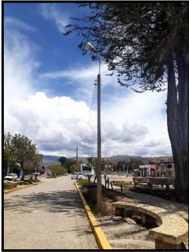
08. FIGURA. - MANEJO INADECUADO EN LA COMPOSICIÓN DE ASPECTOS COMO: FORMA. TEXTURA, COLOR DE VOLÚMENES Y MASAS DE LA EDIFICACIÓN. Elaboración propia
