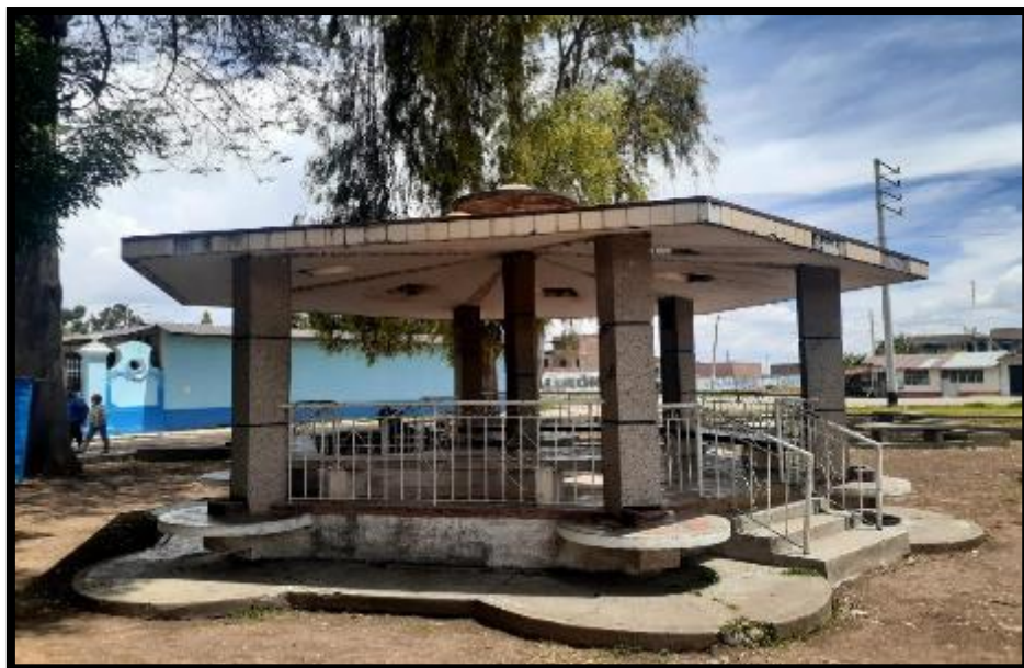
10. FIGURA. - EL MEDIO FÍSICO ARTIFICIAL- GLORIETA CUMPLE CON MÚLTIPLES FUNCIONES. Elaboración propia
