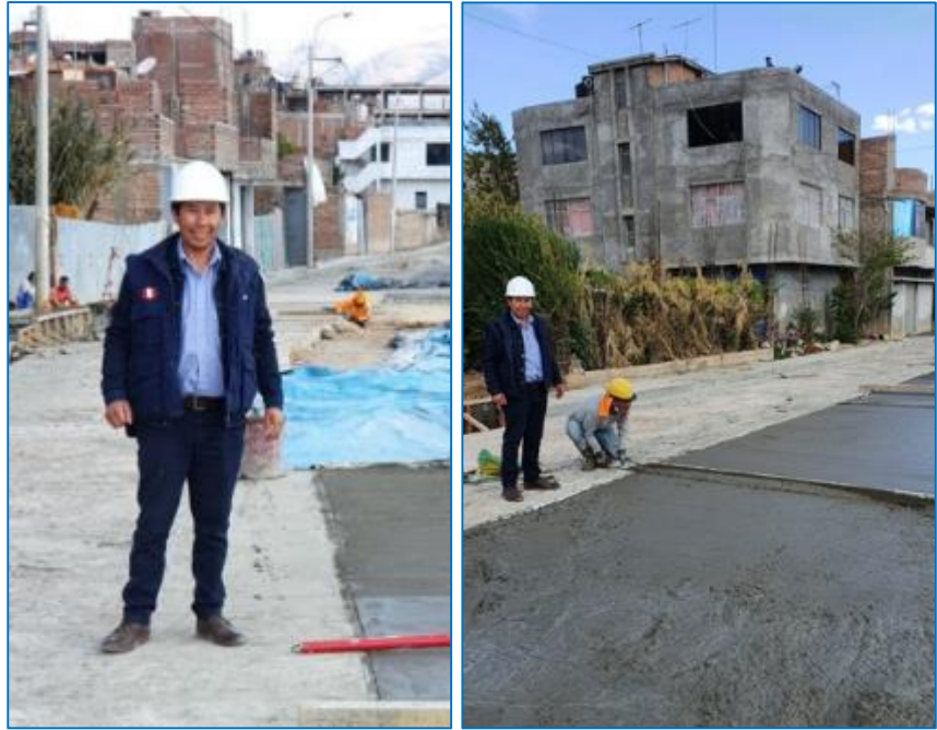
Figura 3: Regleado de la losa.
