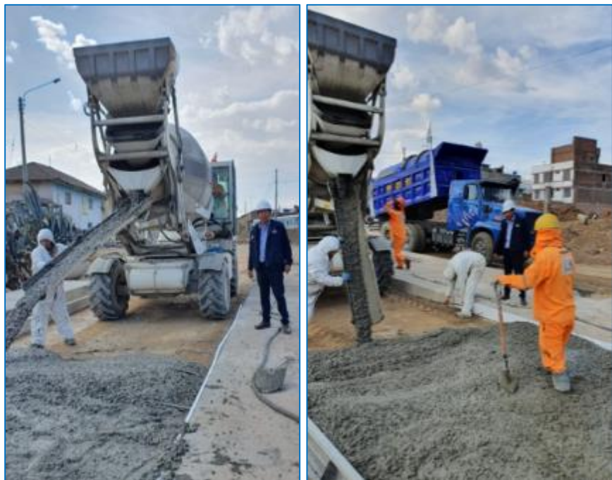
Figura 2: Vaciado de concreto para calzada vehicular.
